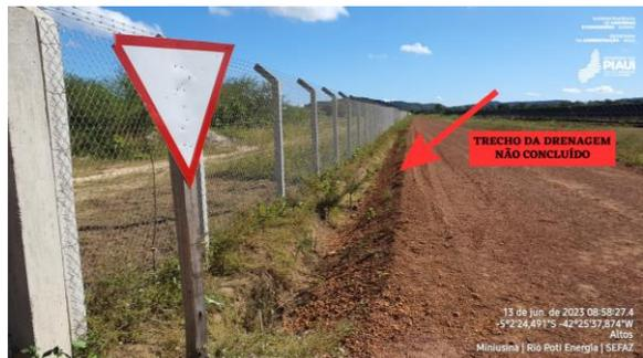
Figura 33 - Trecho de drenagem danificada.
