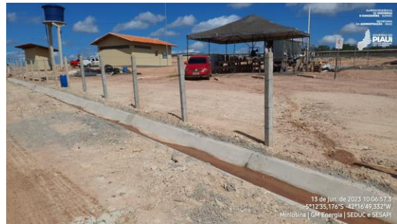
Figuras 7 a 20 - Execução do sistema de drenagem em andamento.
