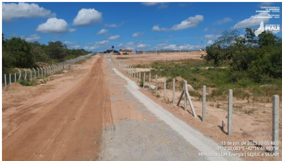
Figuras 7 a 20 - Execução do sistema de drenagem em andamento.
