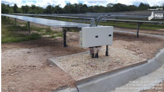
Figura 25 - Inversores em operação.
