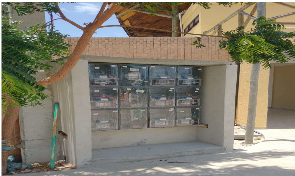
Construção de infraestrutura para instalação individualizada dos registros de energia
