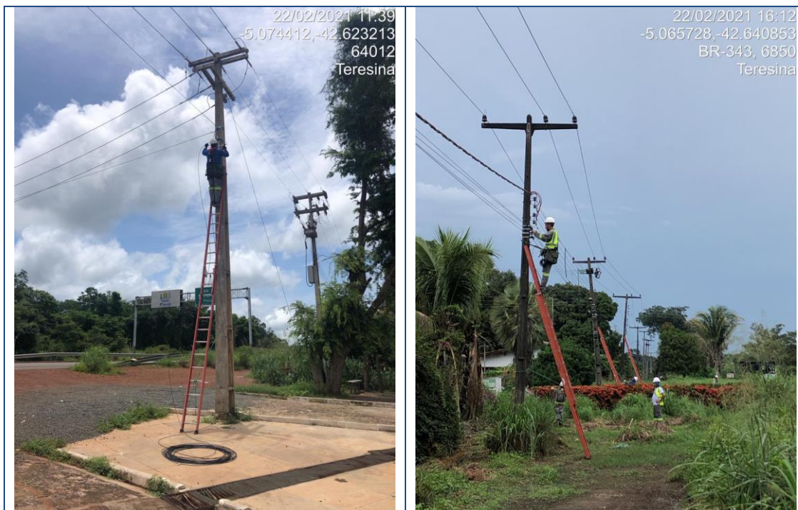
Figura 180 - Lançamento de Backbone aéreo trecho Teresina/Rodoanel
