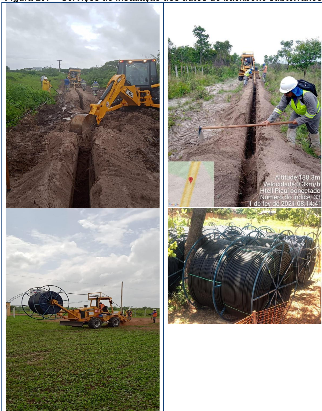
Figura 197 – Serviços de instalação dos dutos do backbone subterrâneo
