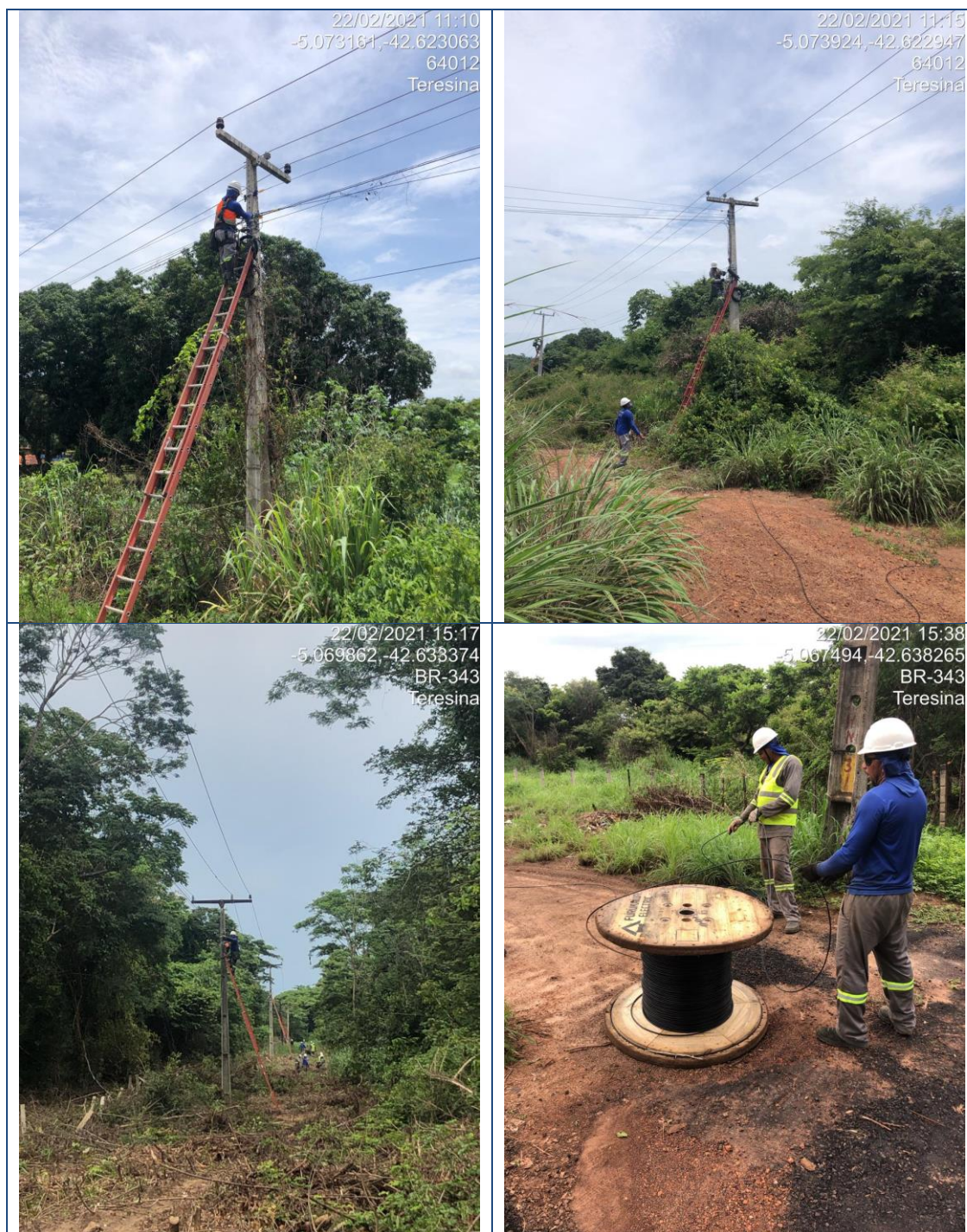
Figura 178 – Lançamento de Backbone aéreo trecho Teresina/Rodoanel
