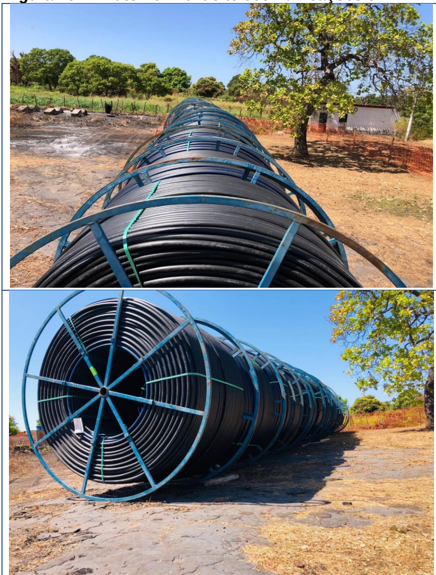
Figura 164 – Duto flexível de telecomunicações em PEAD
