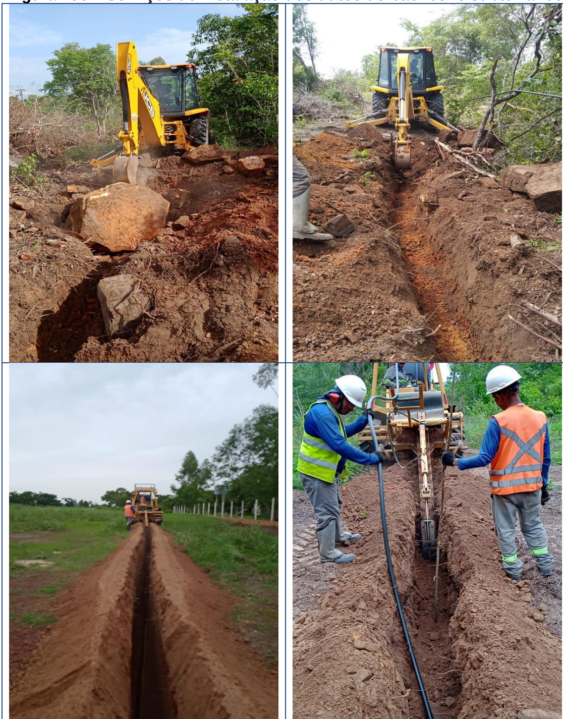
Figura 196 – Serviços de instalação dos dutos do backbone subterrâneo
