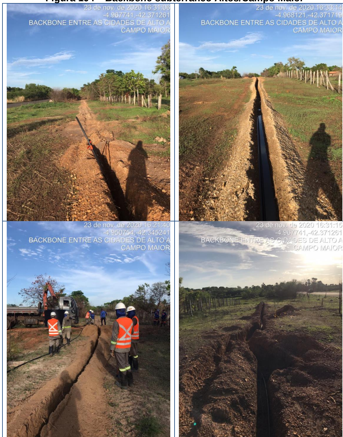
Figura 194 – Backbone subterrâneo Altos/Campo Maior
