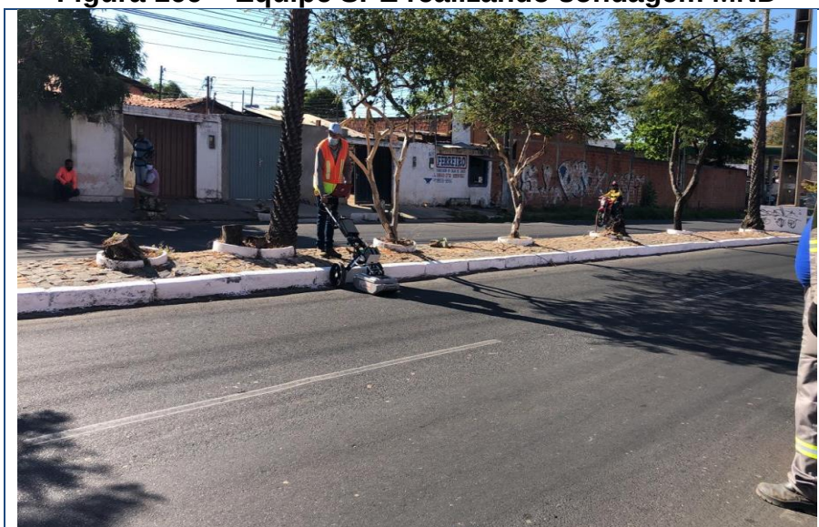
Figura 166 – Equipe SPE realizando sondagem MND
