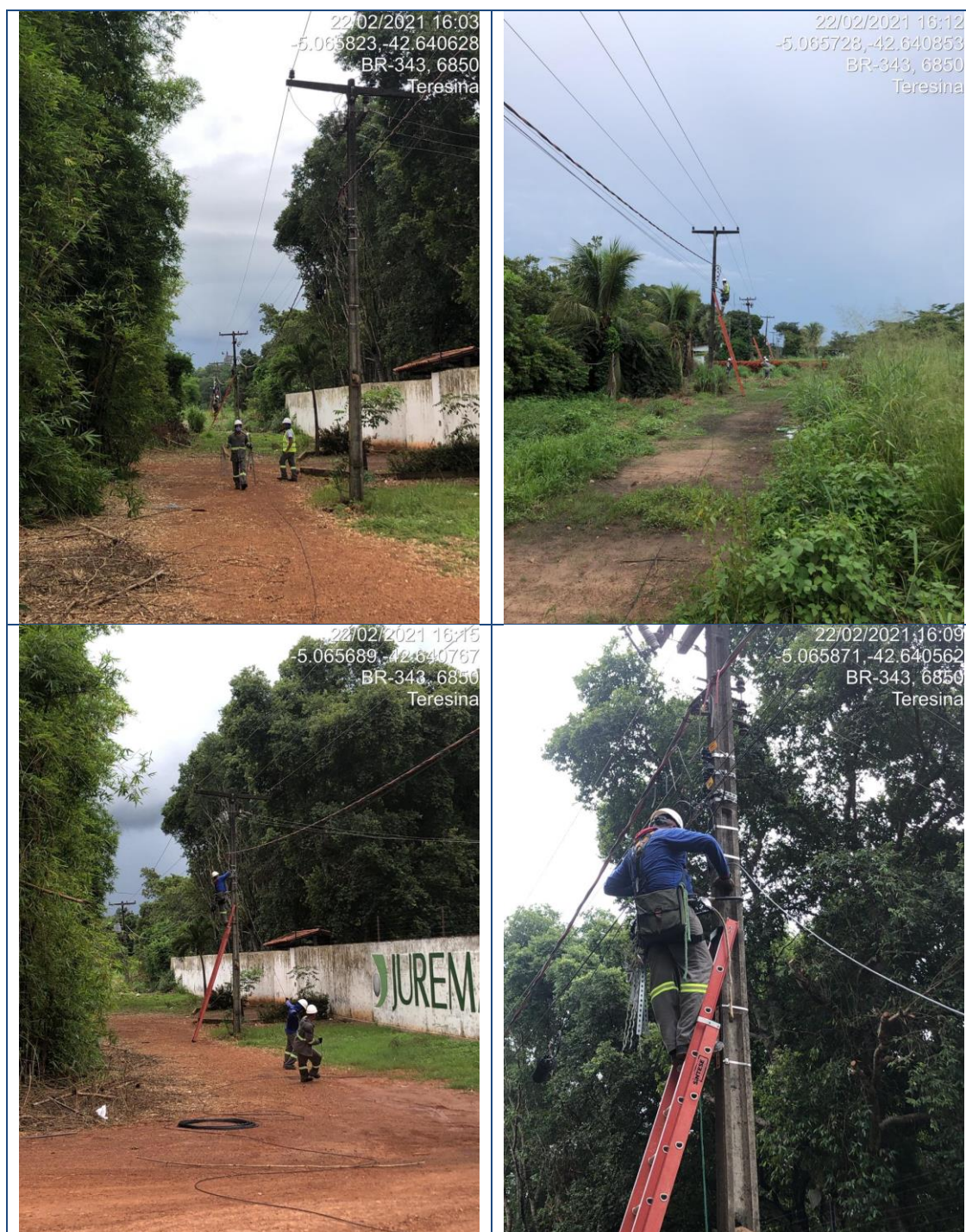
Figura 179 - Lançamento de Backbone aéreo trecho Teresina/Rodoanel
