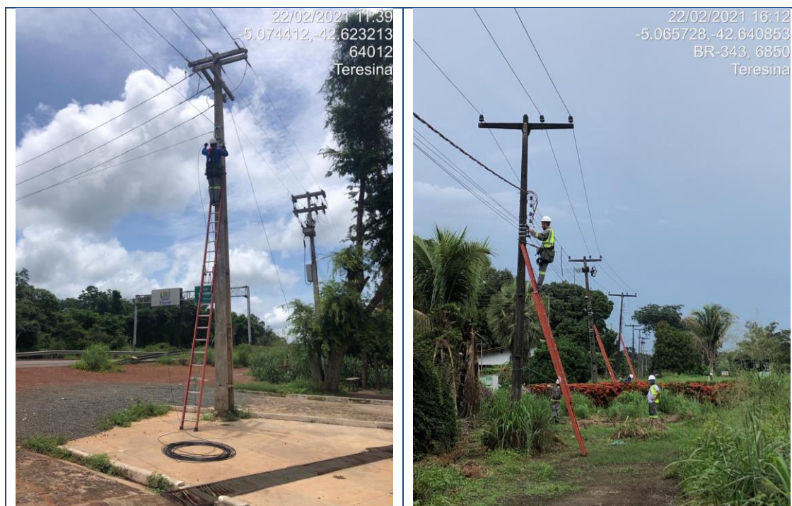
Figura 179 - Lançamento de Backbone aéreo trecho Teresina/Rodoanel Fevereiro/2021
