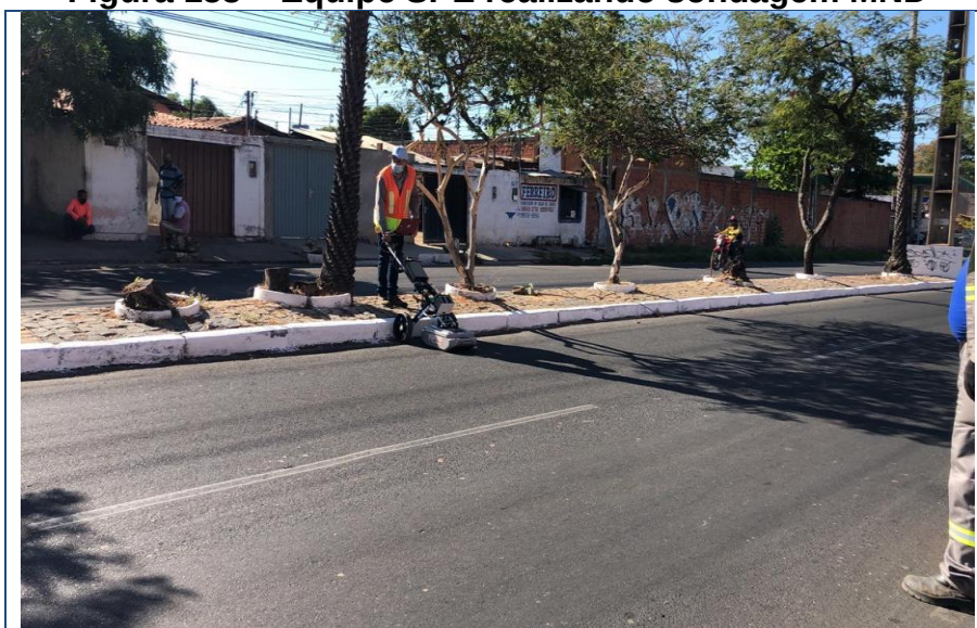
Figura 153 – Equipe SPE realizando sondagem MND
