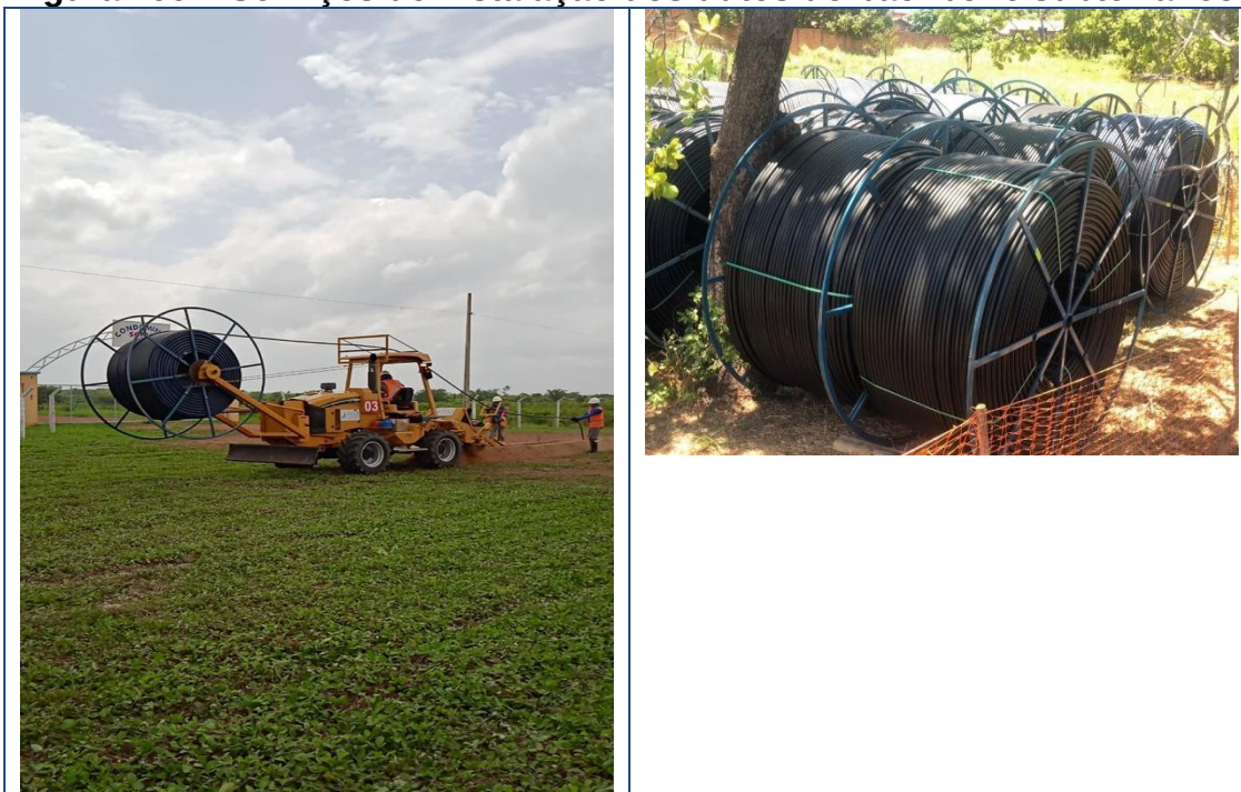
Figura 199 – Serviços de instalação dos dutos do backbone subterrâneo.
