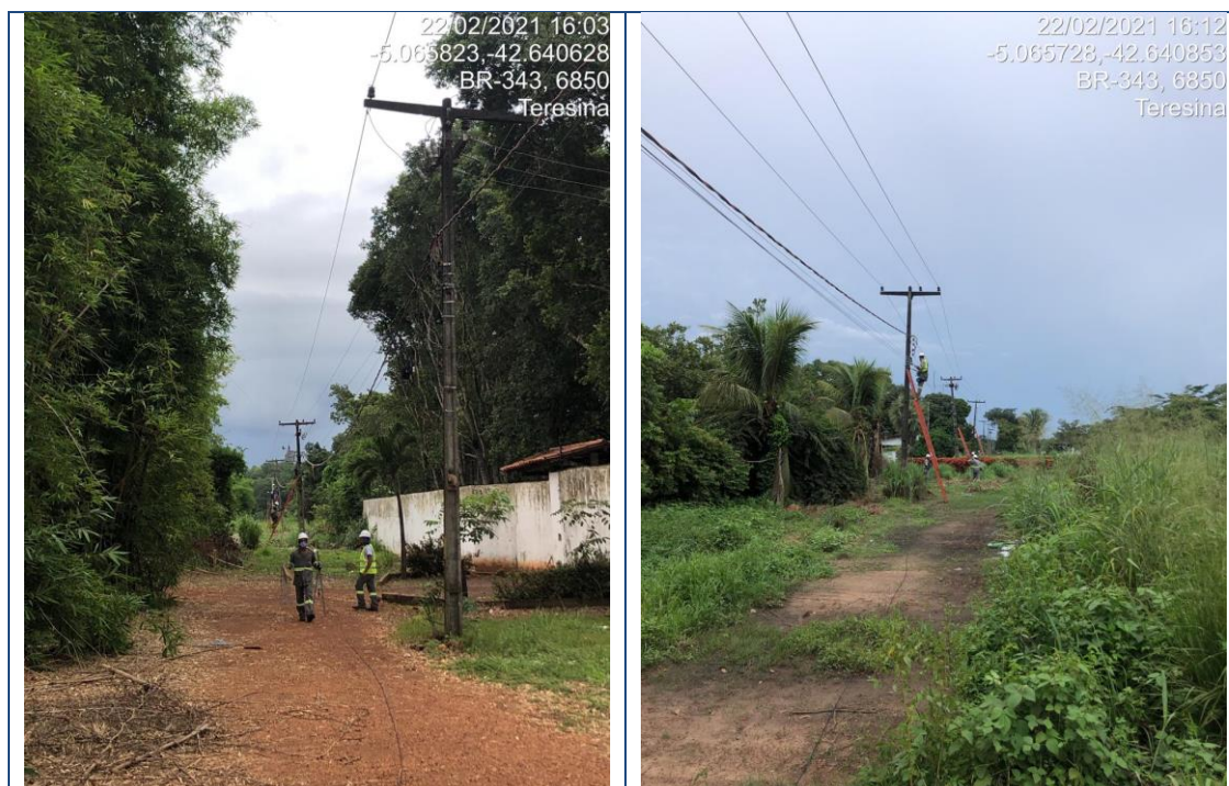
Figura 177 - Lançamento de Backbone aéreo trecho Teresina/Rodoanel Fevereiro/2021
