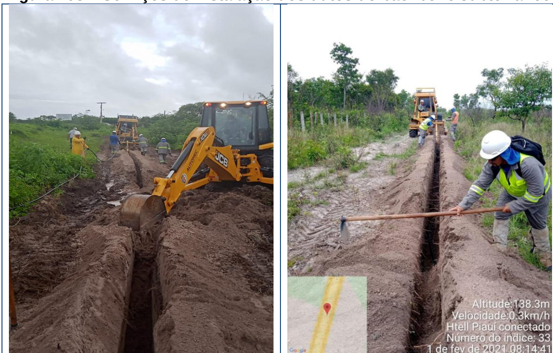
Figura 198 – Serviços de instalação dos dutos do backbone subterrâneo.
