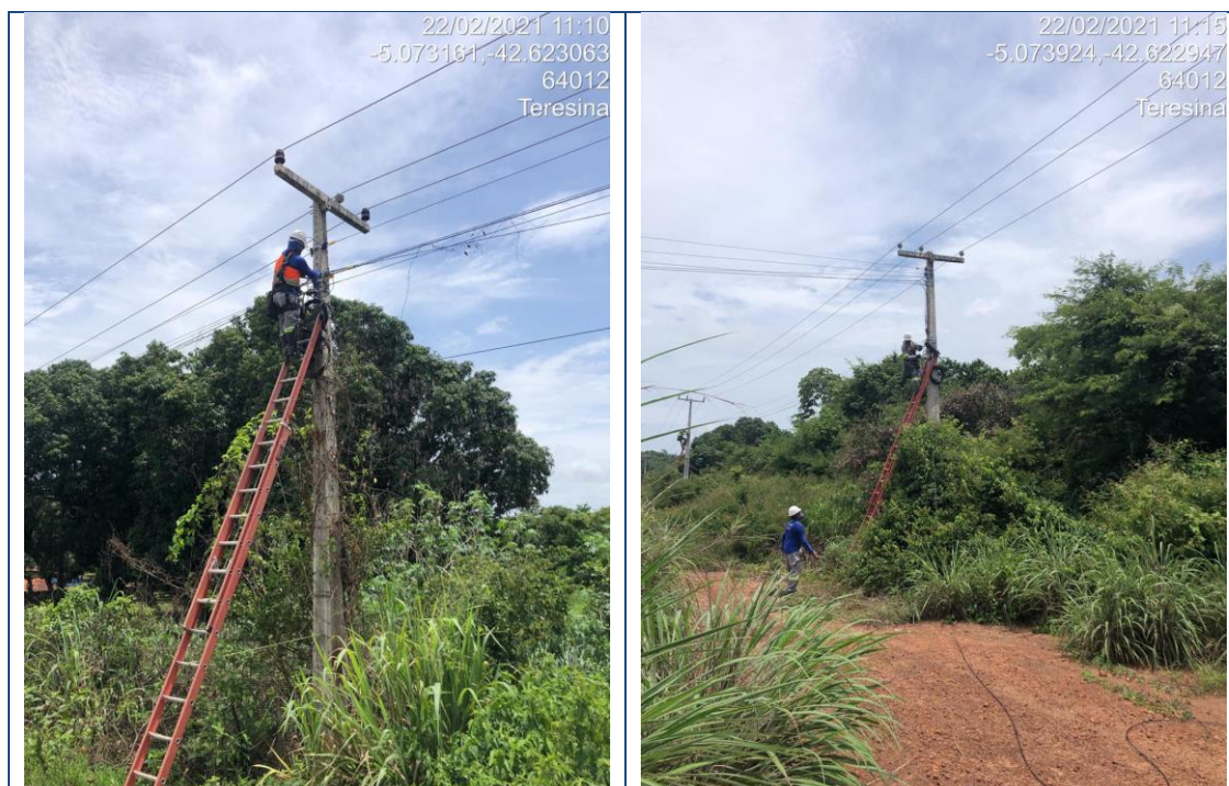
Figura 175 – Lançamento de Backbone aéreo trecho Teresina/Rodoanel - Fevereiro/2021
