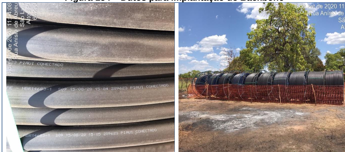
Figura 154 – Dutos para implantação do Backbone
