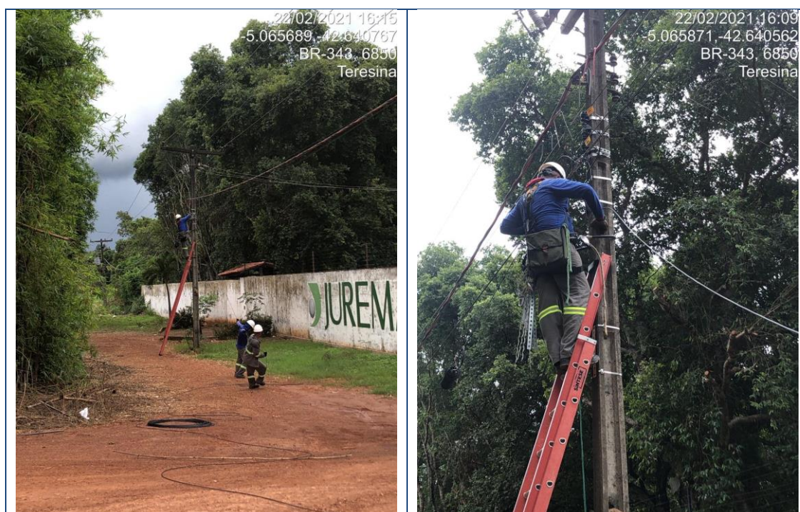
Figura 178 - Lançamento de Backbone aéreo trecho Teresina/Rodoanel Fevereiro/2021
