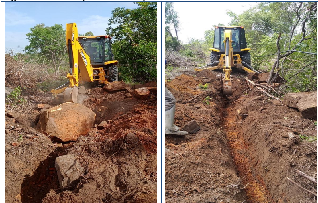
Figura 196 – Serviços de instalação dos dutos do backbone subterrâneo.
