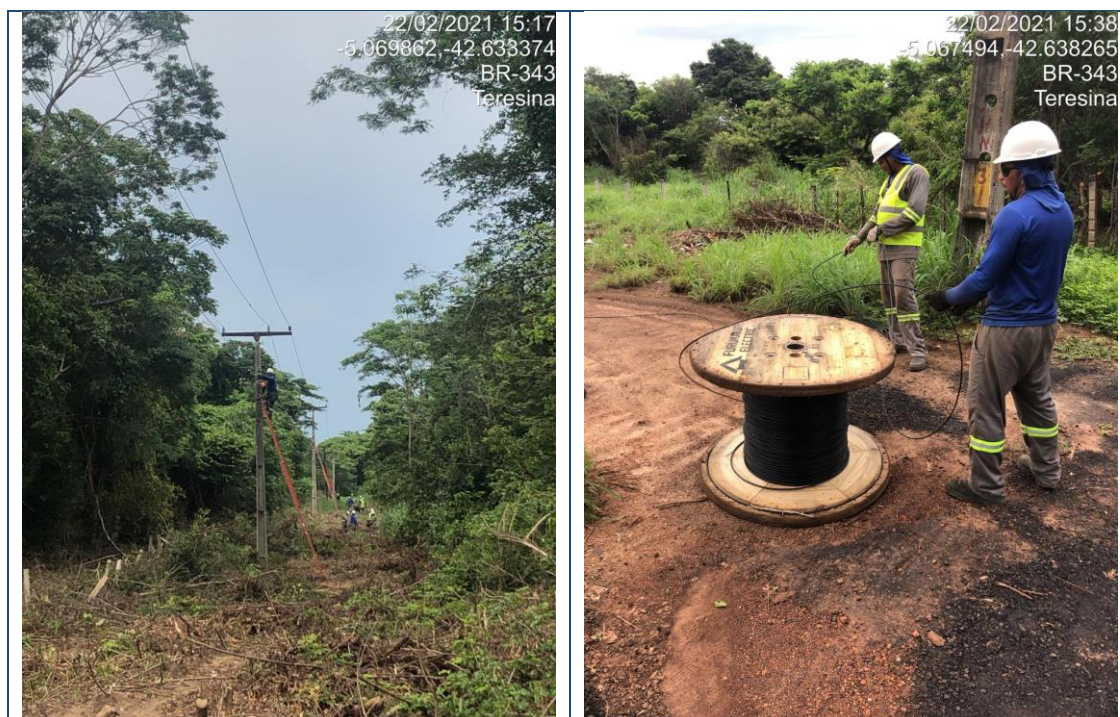
Figura 176 - Lançamento de Backbone aéreo trecho Teresina/Rodoanel Fevereiro/2021
