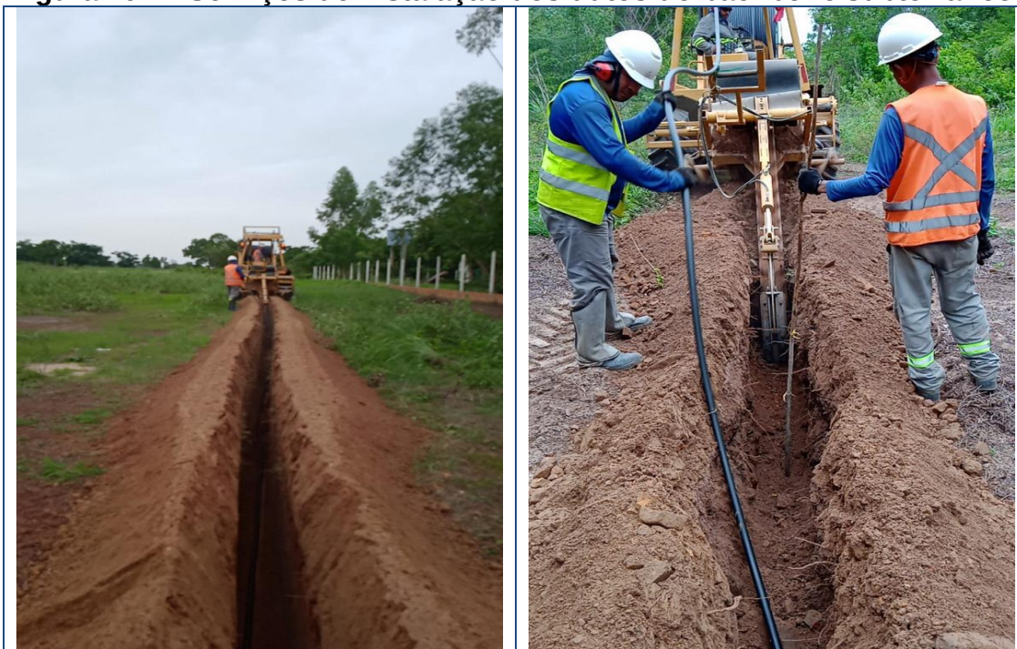
Figura 197 – Serviços de instalação dos dutos do backbone subterrâneo.
