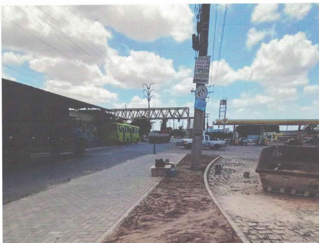
Imagem 6: Obra em andamento da calçada em frente à Portaria 1 - 26.10.2021
