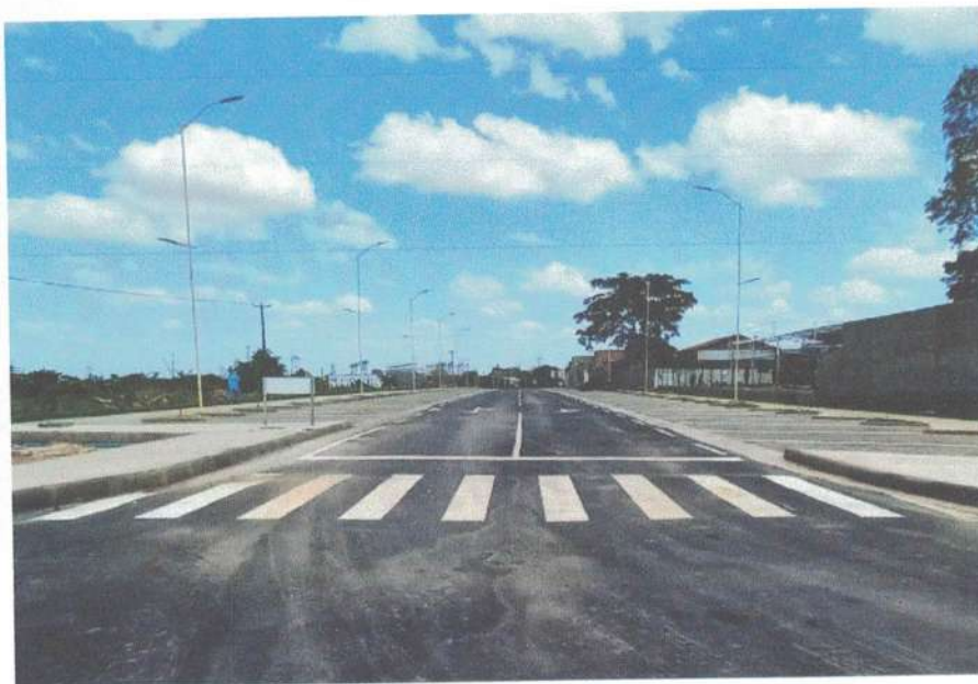
Imagem 2: Foto perspectiva da Avenida Flamboyant - 26.10.2021
