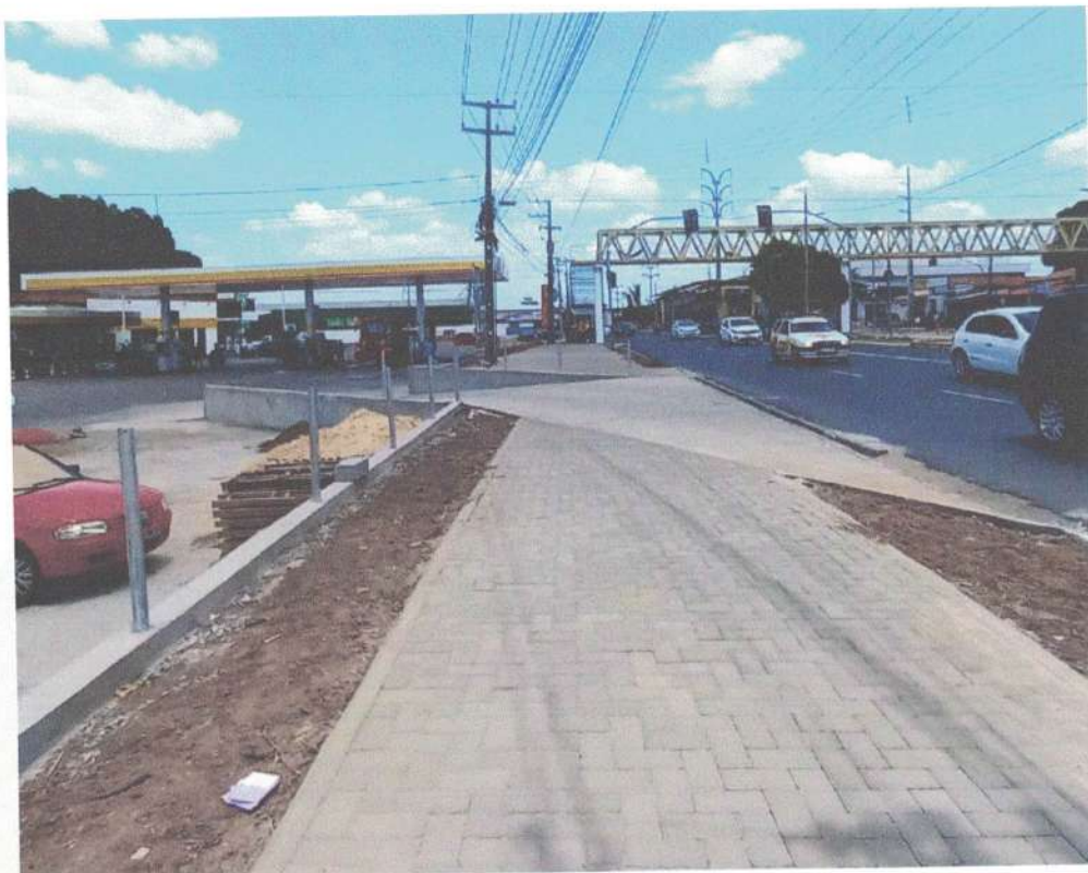
Imagem 7: Obra em andamento da calçada em frente ao Banco do Brasil - 26.10.2021
