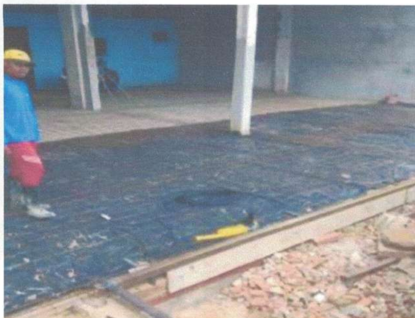
Imagem 19, 20 e 21: aplicação de tela e lona, concretagem do piso do box, da calçada e da rampa de acesso concluído.
