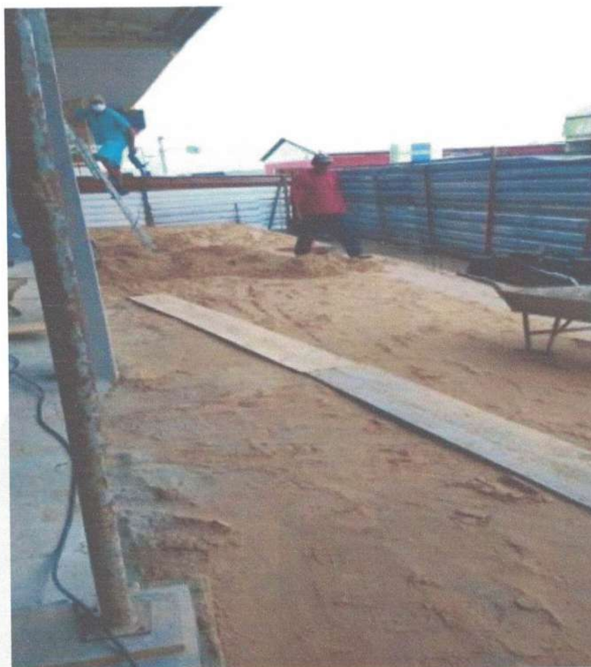
Imagem 6: Compactação do solo da calçada.
