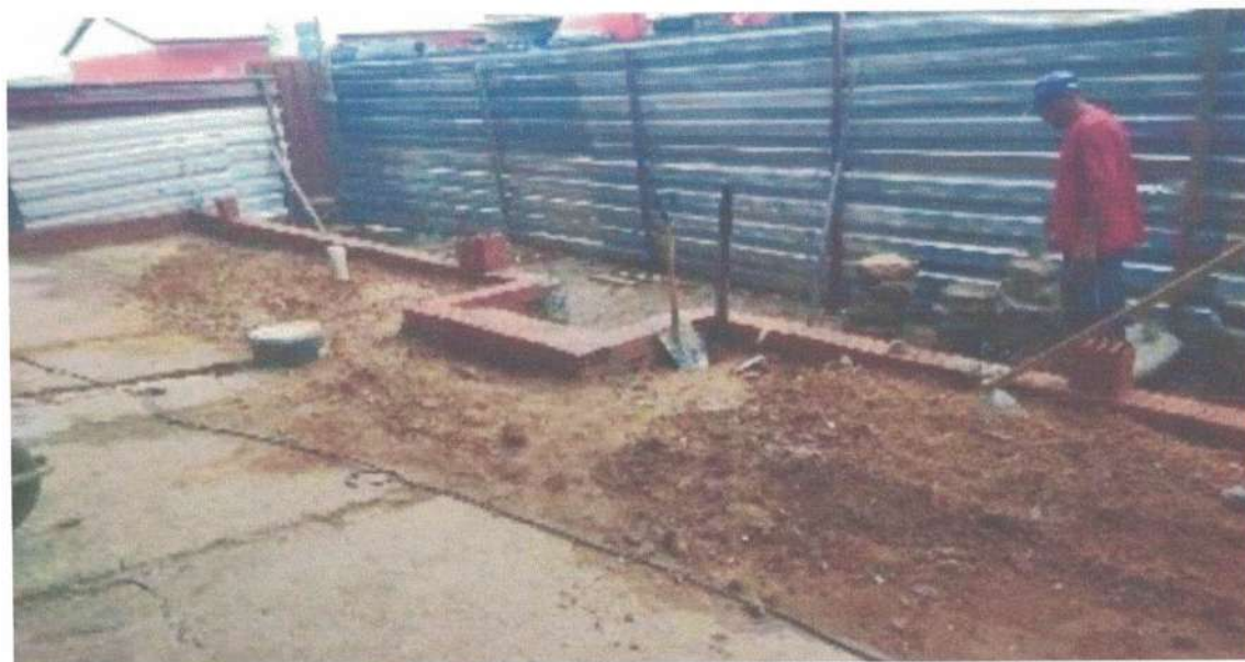
Imagem 5: Construção das escadas de acesso.
