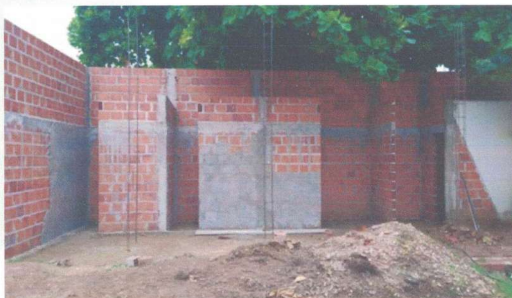
Imagem 4: inicialização do reboco das paredes.
