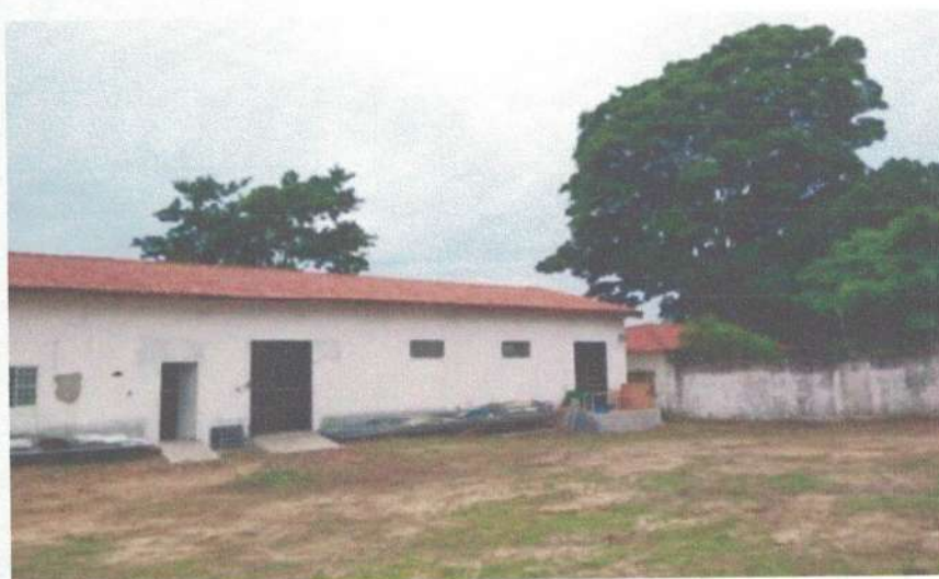
Imagem 3: Reparo do telhado concluído.
