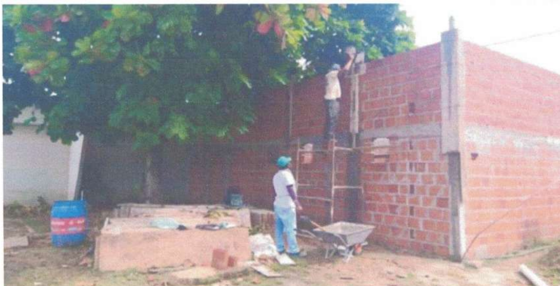
Imagem 3: concretagem de pilares.
