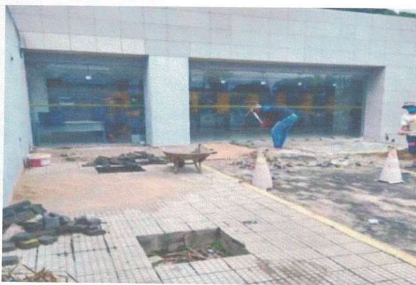
Imagem 26 e 27: caixas de inspeção, reparo da calçada em frente ao Banco do Brasil.
