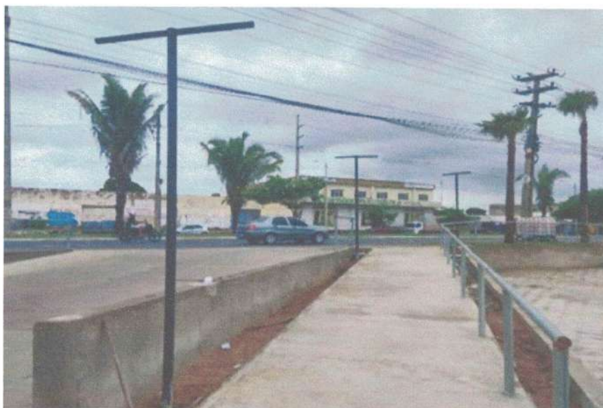
Imagem 28 e 29: assentamento do meio fio para realização das baias, instalação dos postes.
