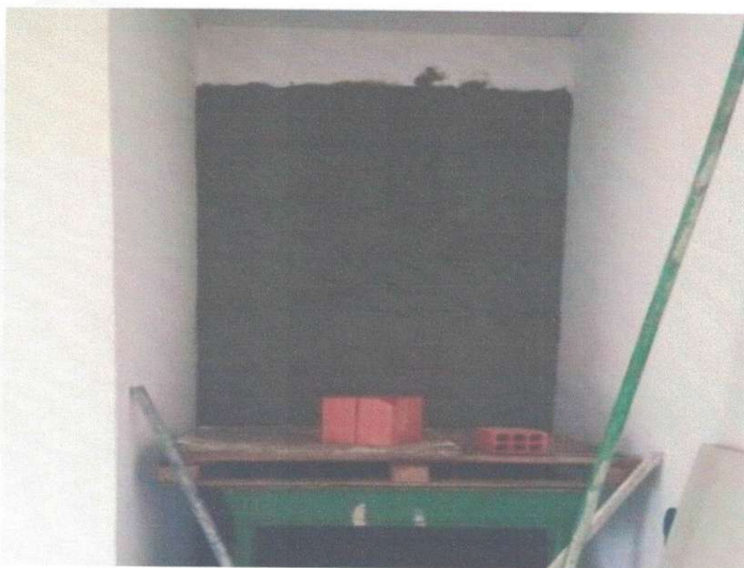
Imagem 1: manutenção de parede do almoxarifado
