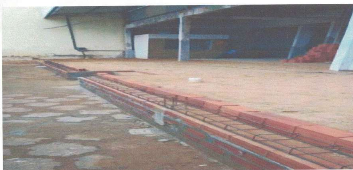
Imagem 7: Vigamento da calçada.
