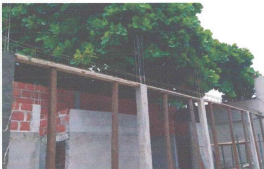
Imagem 13 e 14: Execução da montagem das fôrmas dos pilares para concretagem, reboco das paredes internas dos banheiros.
