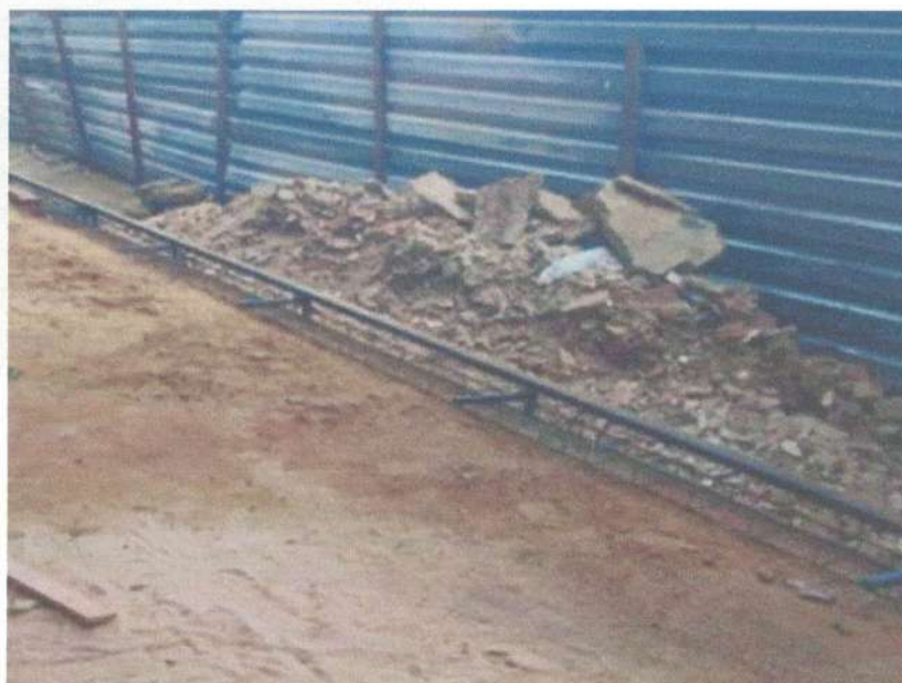
Imagem 17 e 18: demolição da guarita, para concretagem dos pilares, Vigamento da rampa.
