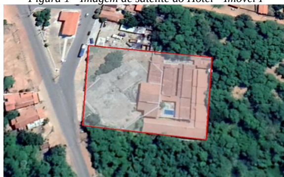
Figura 1 - Imagem de satélite do Hotel - Imóvel I
