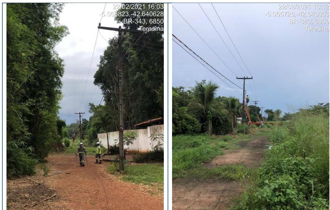
Figura 201 - Lançamento de Backbone aéreo trecho Teresina/Rodoanel Fevereiro/2021
