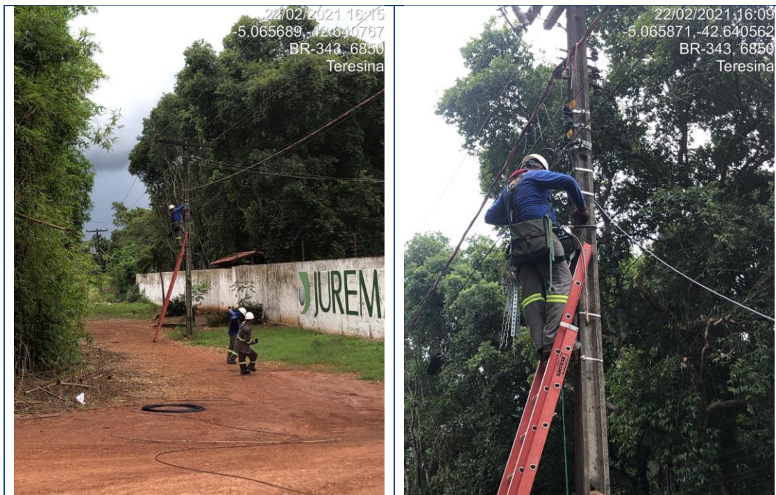
Figura 202 - Lançamento de Backbone aéreo trecho Teresina/Rodoanel Fevereiro/2021
