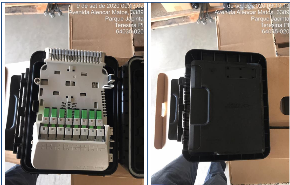
Figura 182 – Materiais e Equipamentos para implantação do Backbone
