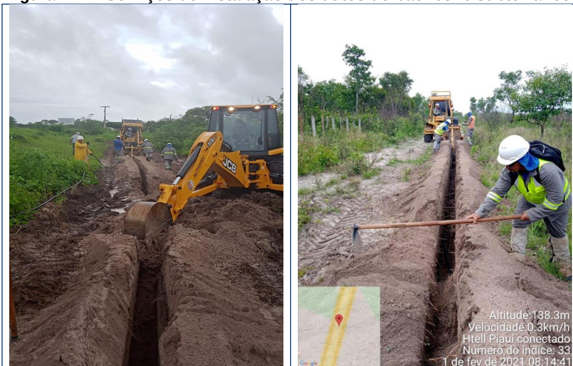
Figura 222 – Serviços de instalação dos dutos do backbone subterrâneo.
