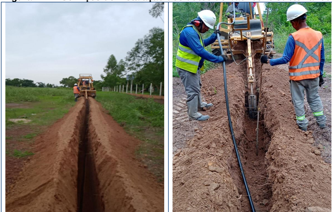
Figura 221 – Serviços de instalação dos dutos do backbone subterrâneo.
