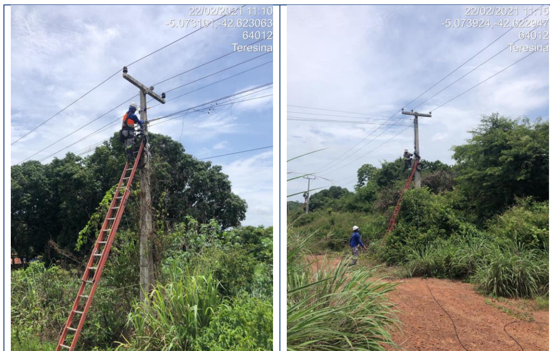
Figura 199 – Lançamento de Backbone aéreo trecho Teresina/Rodoanel - Fevereiro/2021
