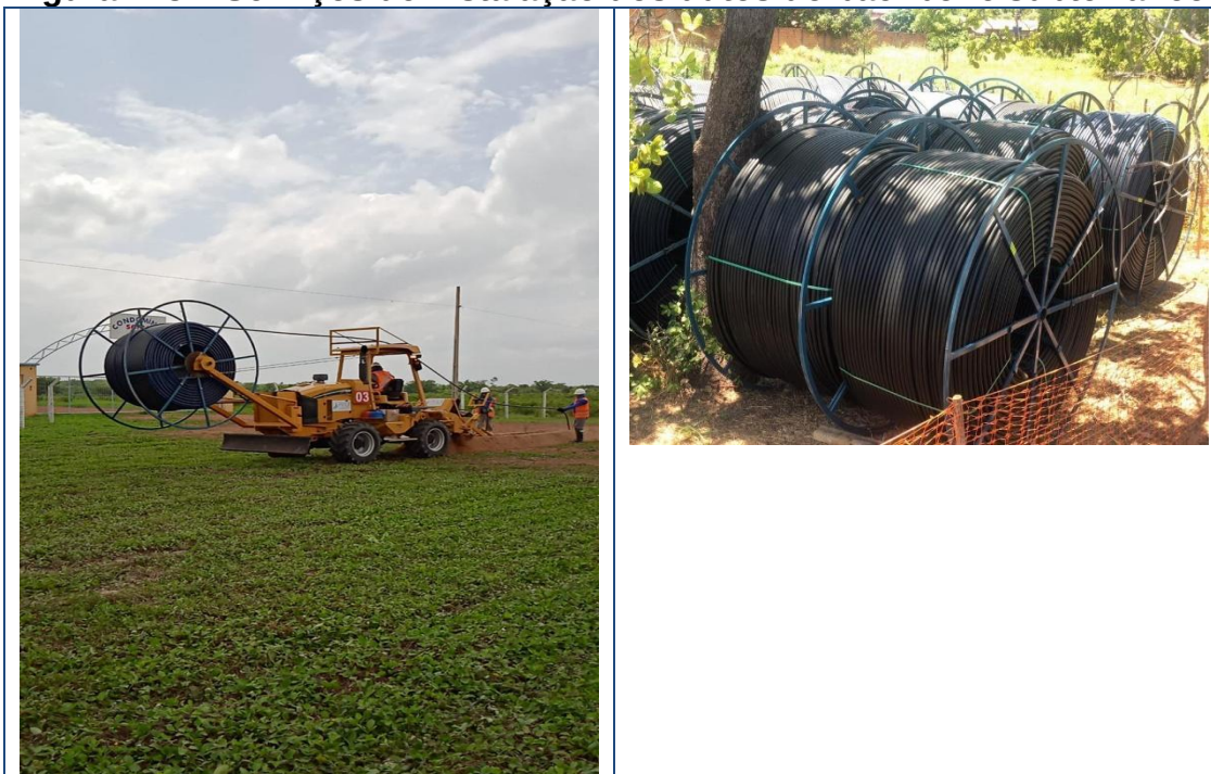
Figura 223 – Serviços de instalação dos dutos do backbone subterrâneo.
