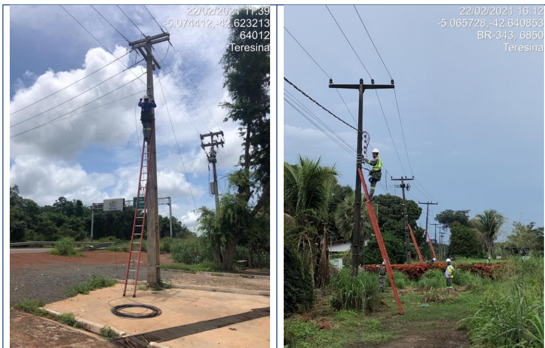
Figura 203 - Lançamento de Backbone aéreo trecho Teresina/Rodoanel Fevereiro/2021
