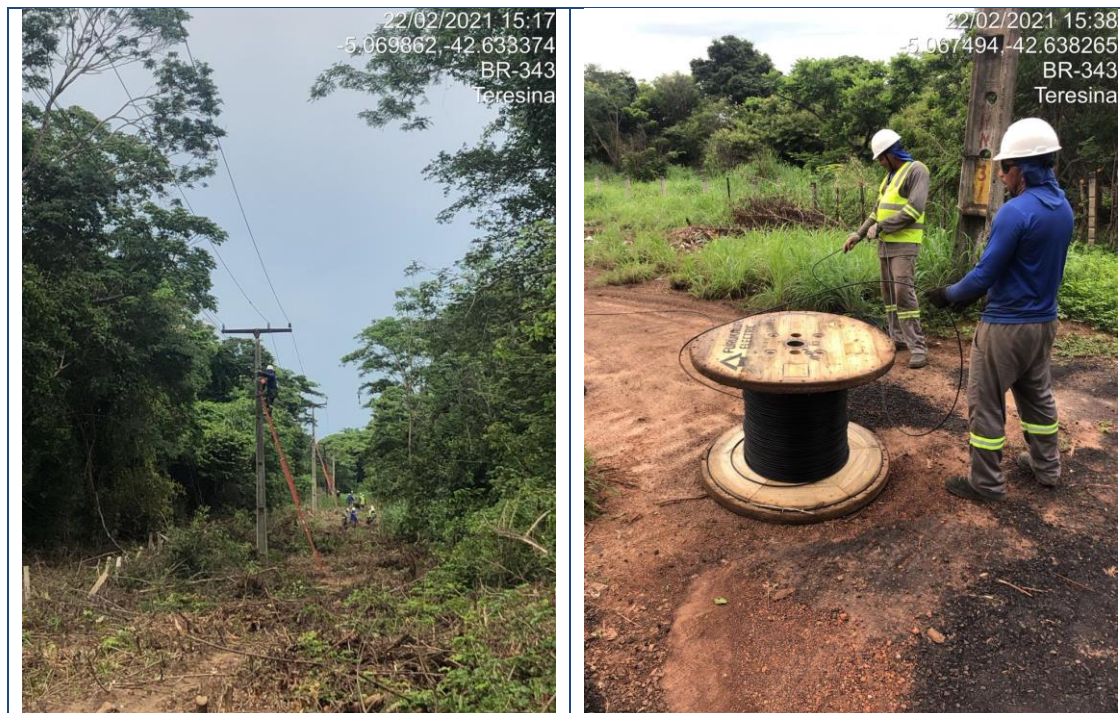
Figura 200 - Lançamento de Backbone aéreo trecho Teresina/Rodoanel Fevereiro/2021
