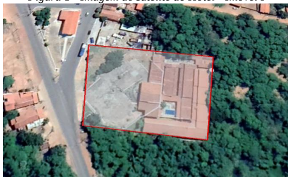
Figura 1 - Imagem de satélite do Hotel - Imóvel I
