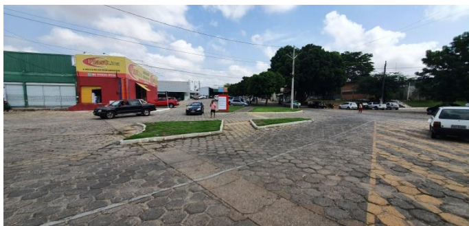
Vias de circulação – Foto 23
