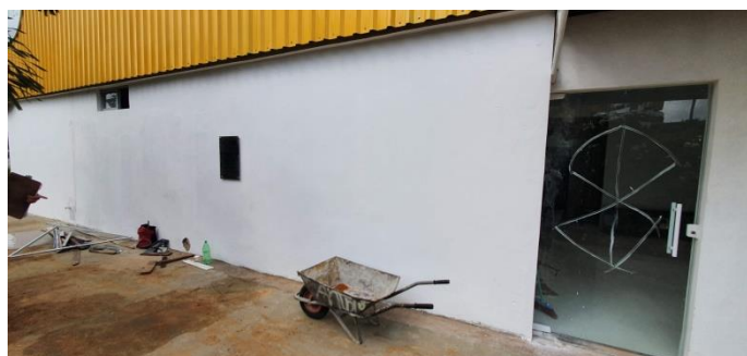
Banco de Saúde (em reforma) – Foto 08
