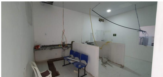
Banco de Saúde (em reforma) – Foto 11
