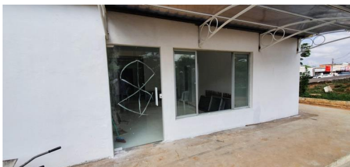
Banco de Saúde (em reforma) – Foto 09
