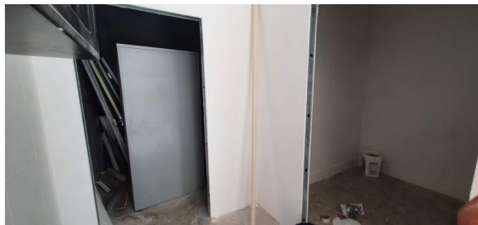
Banco de Saúde (em reforma) – Foto 12
