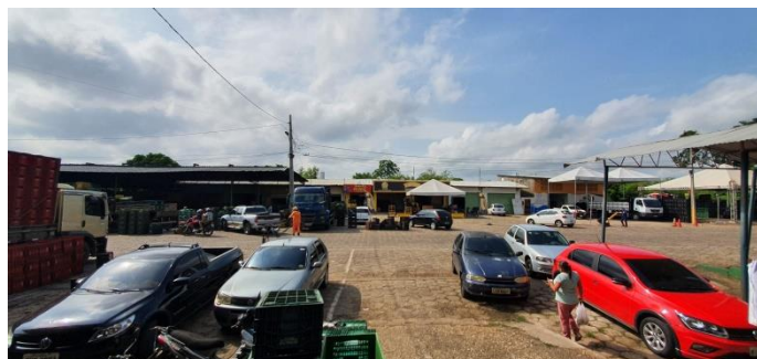
Banco de Saúde (em reforma) – Foto 06
