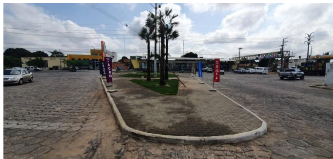
Vias de circulação – Foto 26
