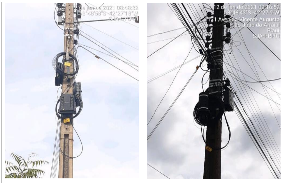
Figura 14 – Inspeção de não conformidades na manutenção e conservação da Fibra Ótica.
