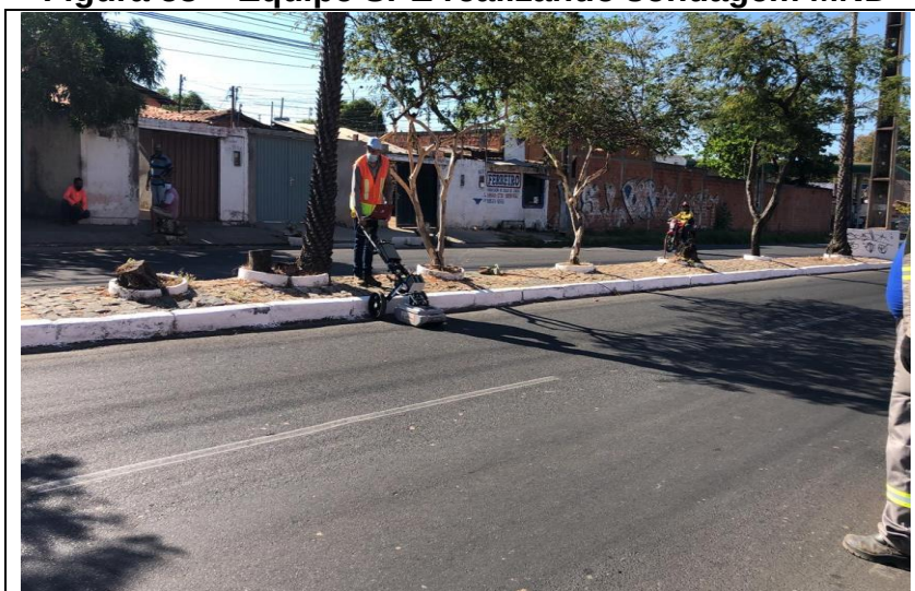
Figura 53 – Equipe SPE realizando sondagem MND
