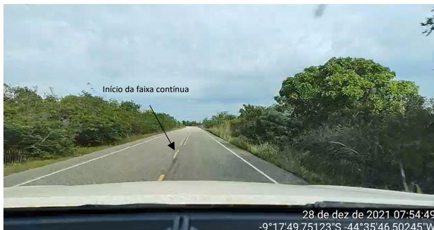
Não foram identificados elementos de proteção como guarda-corpo ou defesa metálica na região de Serra, próximo ao Km 33,7. O Verificador Independente recomenda à Concessionária que analise a necessidade de implantação de dispositivos que garantam a segurança do usuário.
