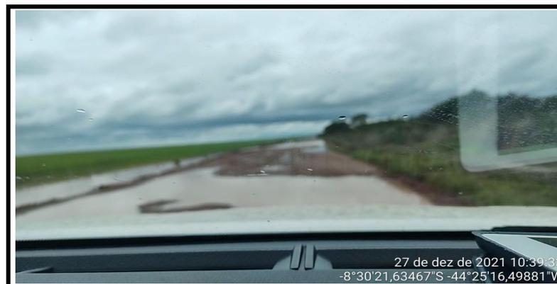
Final do segmento homogêneo 4 – trecho com pontos de alagamento comprometendo a pista, ficando intransitável.
