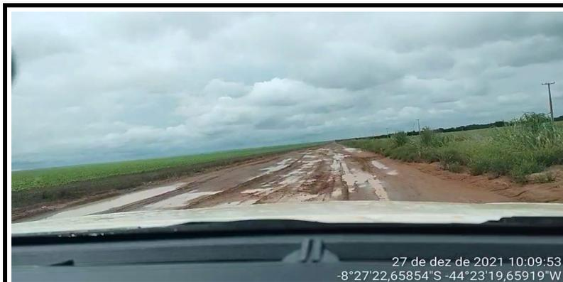
Final do segmento homogêneo 3 – atoleiro em trecho da pista dificultando a trafegabilidade no local.
