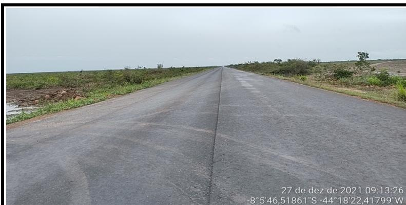
Diferença de nível no pavimento asfáltico da rodovia.
