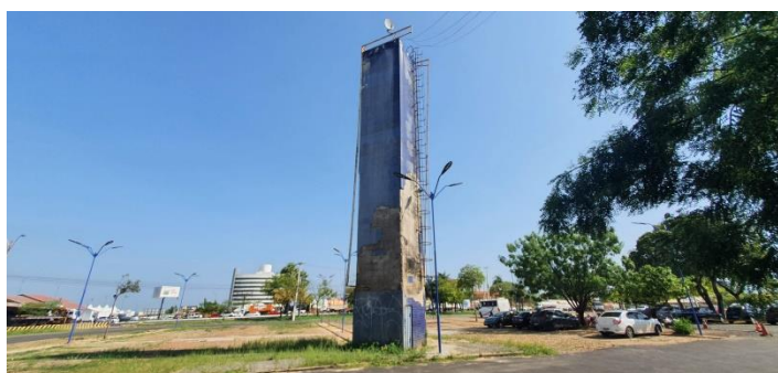
Foto 11 - Área do estacionamento
