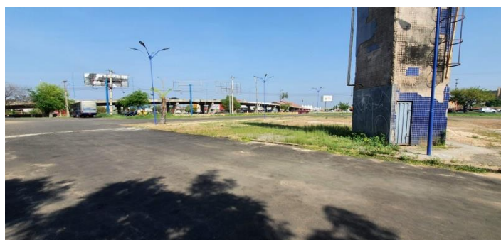
Foto 12 - Área do estacionamento
