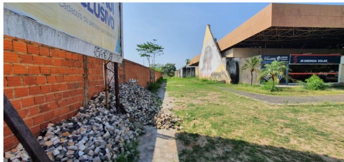
Foto 24 - Estrutura da cobertura
