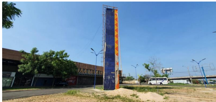
Foto 10 - Área do estacionamento
