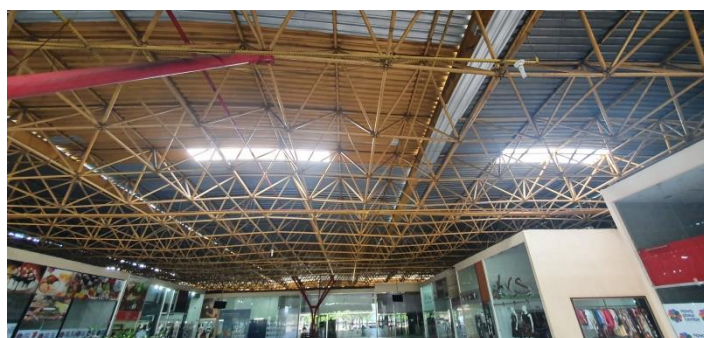
Foto 26 - Corredor de acesso as lojas internas
