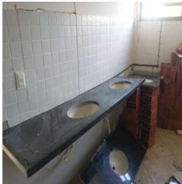
ÁREA RESTAURATE REPOSIÇÃO PIAS COZINHA – REFEITO INSTALAÇÕES HIDRÁULICAS - ELÉTRICA
