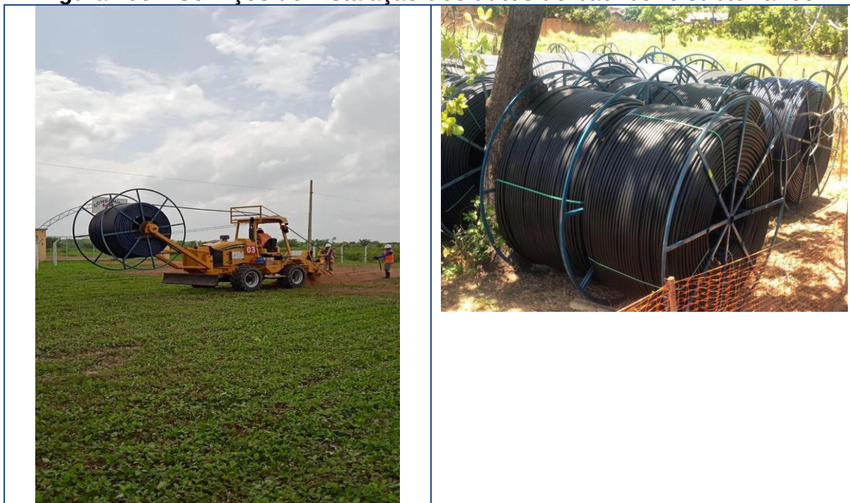
Figura 196 – Serviços de instalação dos dutos do backbone subterrâneo.
