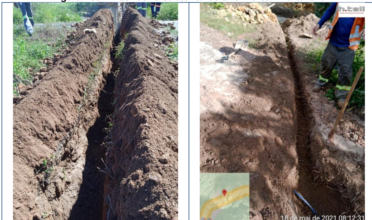
Figura 199 – Backbone subterrâneo anel norte - Maio/2020
