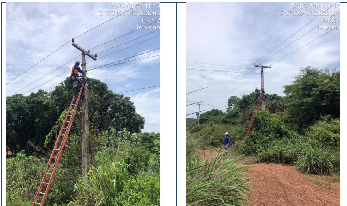
Figura 172 – Lançamento de Backbone aéreo trecho Teresina/Rodoanel - Fevereiro/2021
