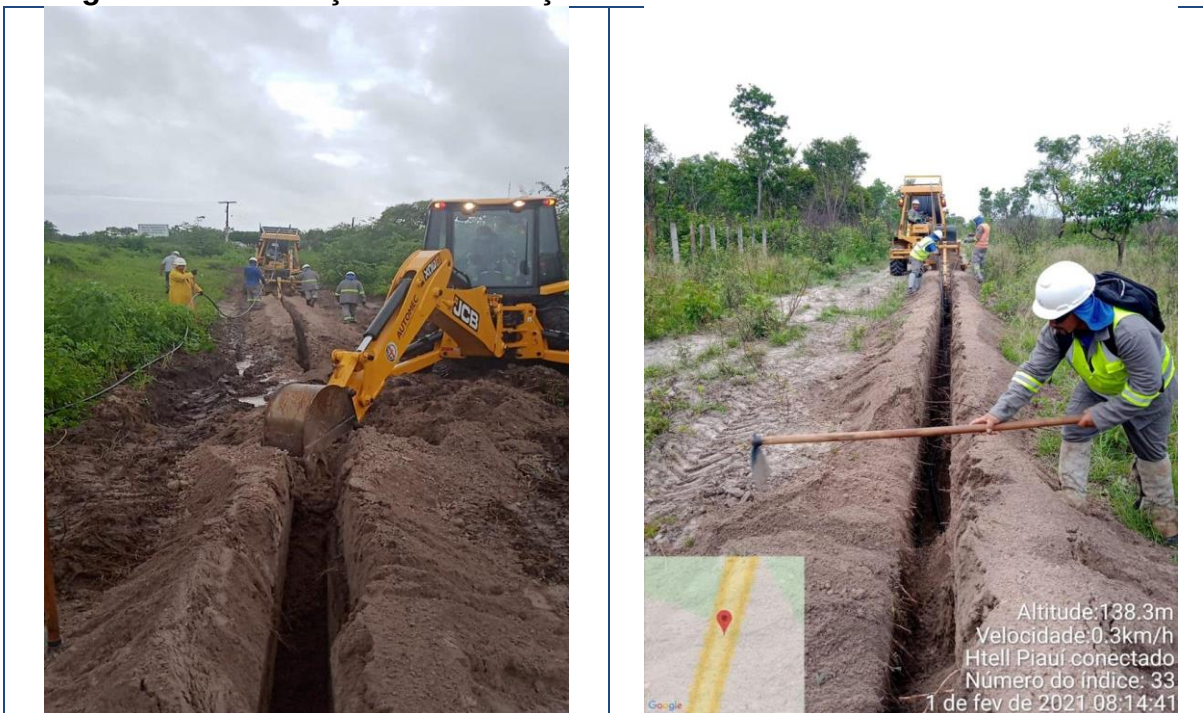
Figura 195 – Serviços de instalação dos dutos do backbone subterrâneo.
