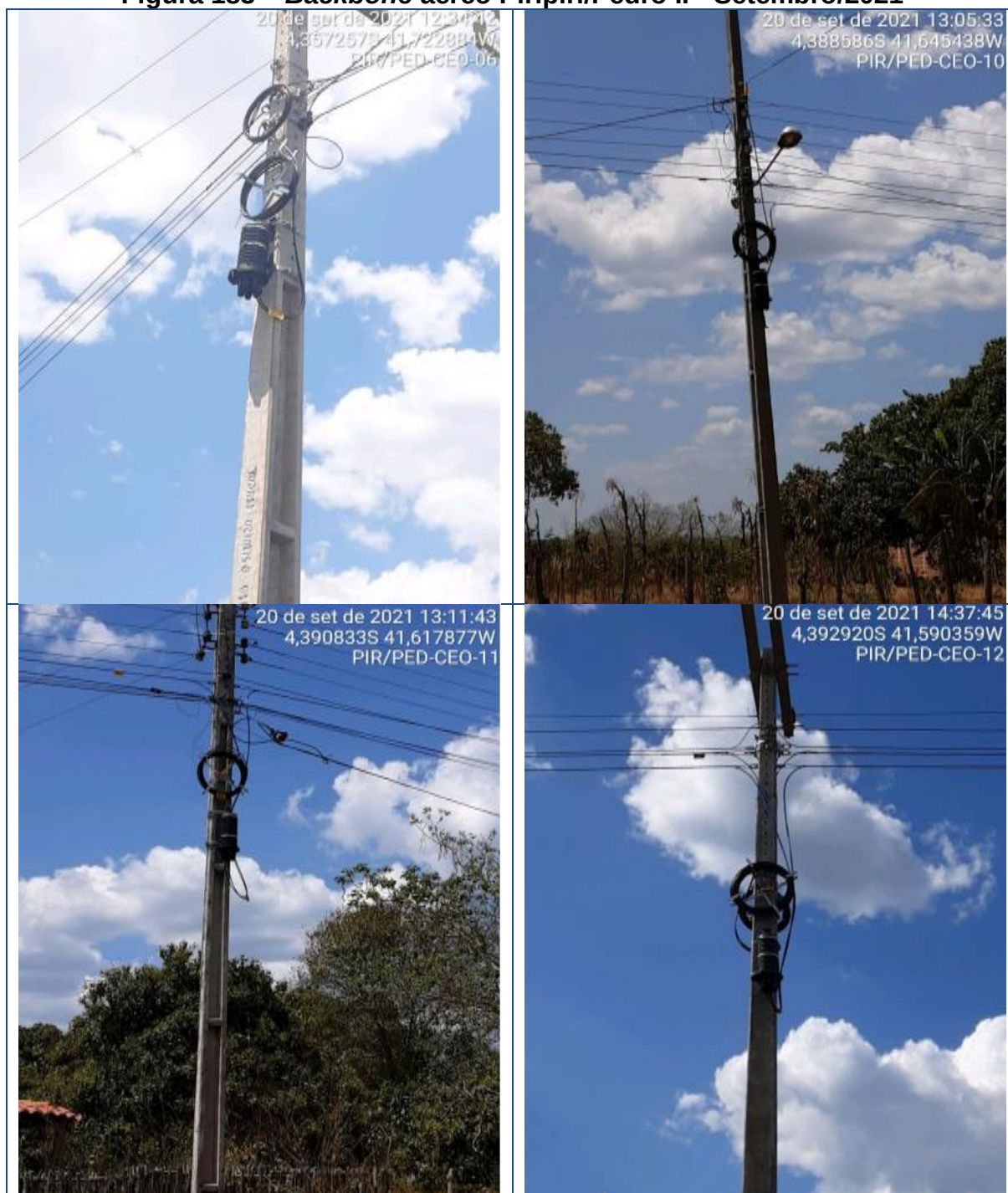
Figura 183 – Backbone aéreo Piripiri/Pedro II - Setembro/2021
