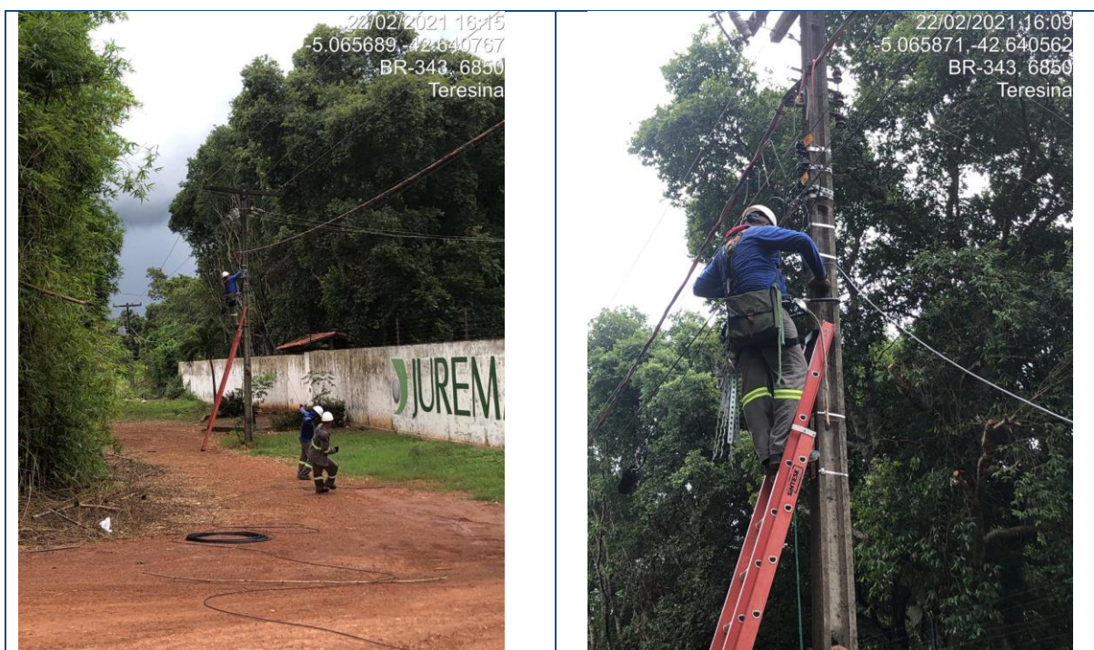
Figura 175 - Lançamento de Backbone aéreo trecho Teresina/Rodoanel Fevereiro/2021
