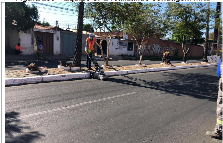
Figura 150 – Equipe SPE realizando sondagem MND
