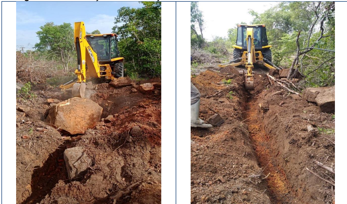
Figura 193 – Serviços de instalação dos dutos do backbone subterrâneo.
