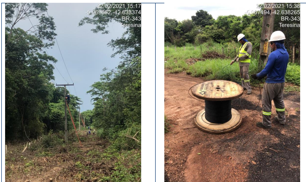
Figura 173 - Lançamento de Backbone aéreo trecho Teresina/Rodoanel Fevereiro/2021
