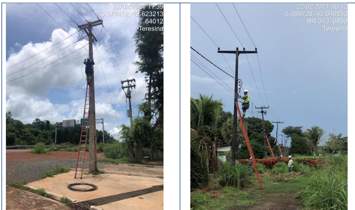
Figura 176 - Lançamento de Backbone aéreo trecho Teresina/Rodoanel Fevereiro/2021
