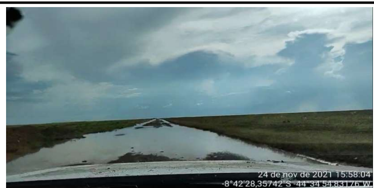
Difícil acesso para veículos, devido ao alagamento comprometendo a pista, desvio realizado em propriedades privadas.
