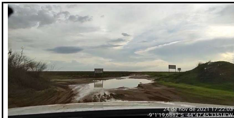
Final do segmento homogêneo 6 - alagamento comprometendo toda pista, dificultando o acesso de veículos.
