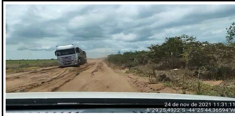
Trecho com a pista irregular, dificultando o acesso de veículos.
