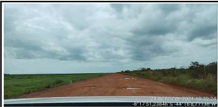
Início do segmento homogêneo 3 – trecho não pavimentado.
