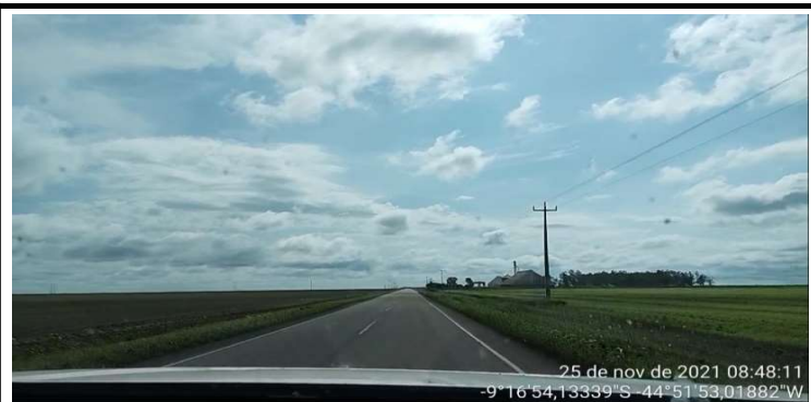
Início do segmento homogêneo 8 - pavimento sem defeitos aparentes.
