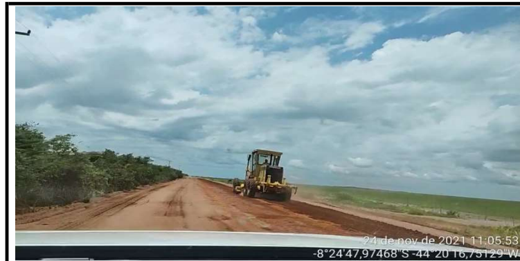
Maquinário trabalhando no leito do trecho.
