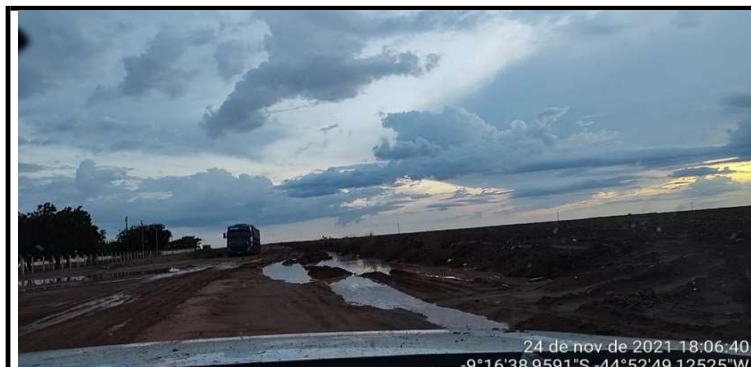
Final do segmento homogêneo 7 - trecho com a pista irregular e pontos de alagamento, dificultando o acesso de veículos.
