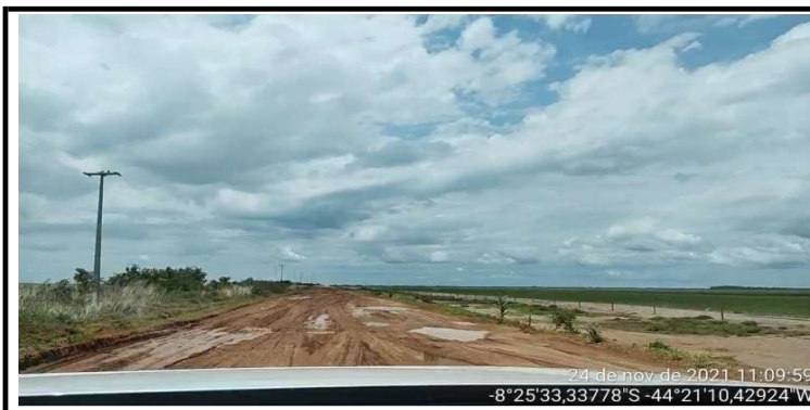
Atoleiro em trecho da pista.
