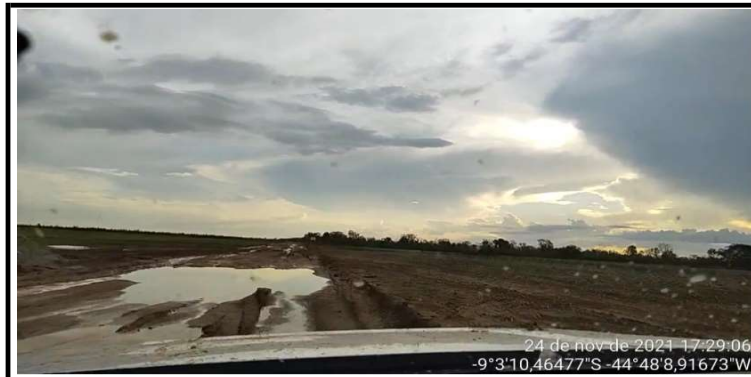
Trecho com buraco de grande proporção e pontos de alagamento comprometendo a pista
