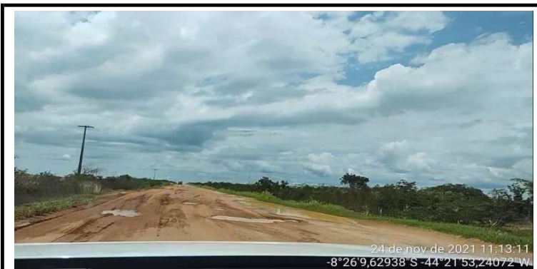
Final do segmento homogêneo 3 – Trecho não pavimentado. Difícil acesso para veículos.
