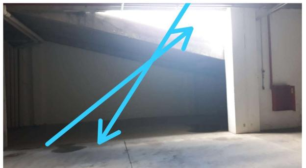
02-07-2021 às 10h03 - Estacionamento piso 1, molhando devido abertura rampa de acesso piso 2 estacionamentos.
