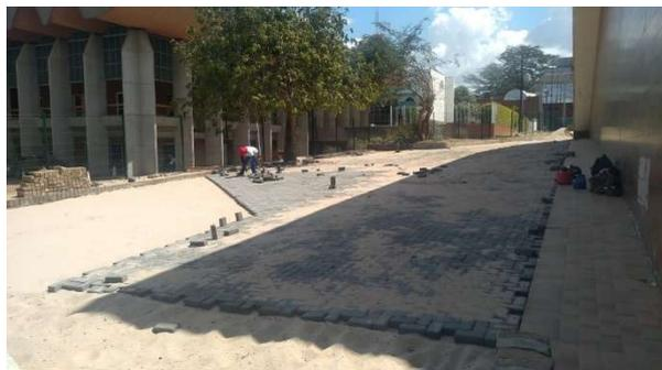
30-08-2021 às 13h43 - Instalação dos pisos bloquetes do estacionamento 4 em andamento
