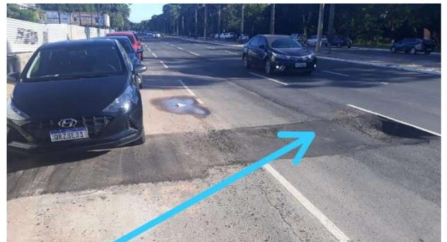
03-07-2021 às 07h51 - Afundamento no asfalto área de 0,50 x 1,10 (acionando a concessionária de esgoto).
