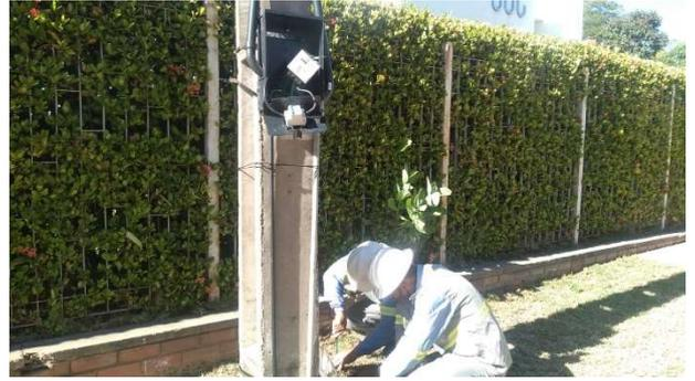
07-08-2021 às 08h42 - Empresa Equatorial energia, troca de medidor de monofásico para trifásico.
