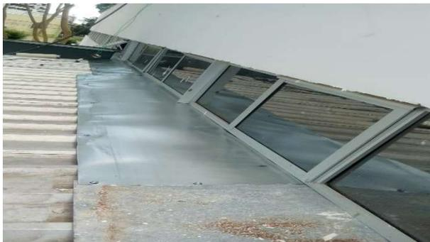
16-08-2021 às 11h53 - Segue instalação e vedação das calhas nas janelas frente marquise estacionamento 03.
