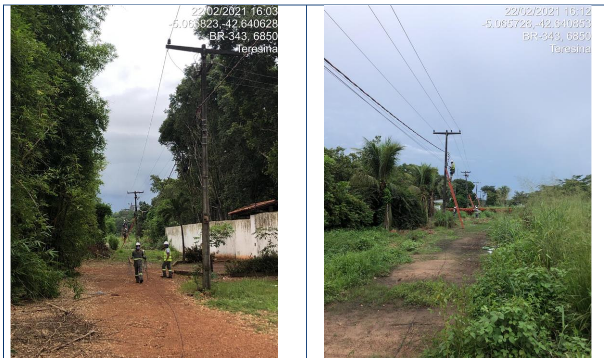
Figura 201 - Lançamento de Backbone aéreo trecho Teresina/Rodoanel Fevereiro/2021
