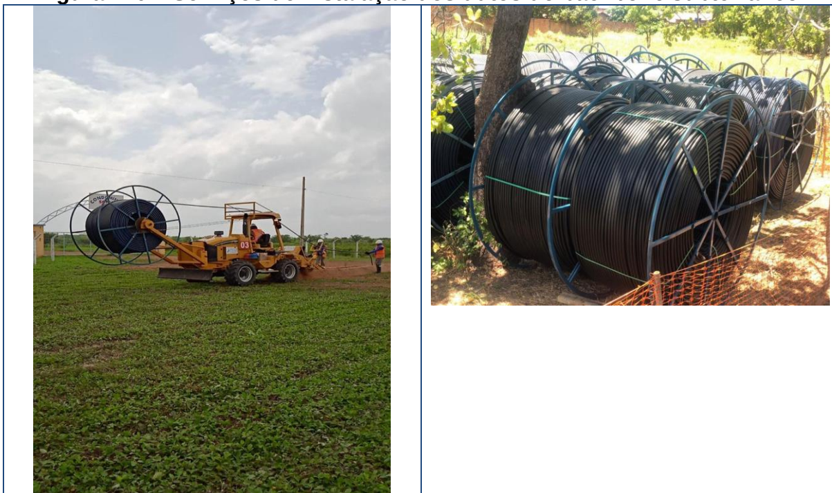
Figura 220 – Serviços de instalação dos dutos do backbone subterrâneo.
