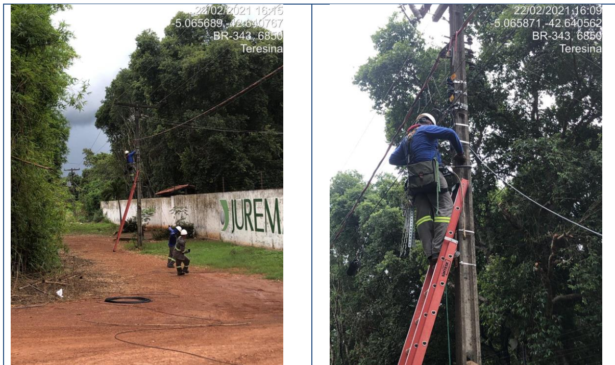
Figura 202 - Lançamento de Backbone aéreo trecho Teresina/Rodoanel Fevereiro/2021
