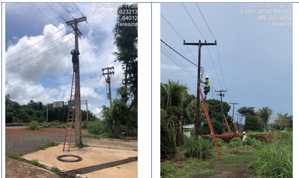
Figura 203 - Lançamento de Backbone aéreo trecho Teresina/Rodoanel Fevereiro/2021
