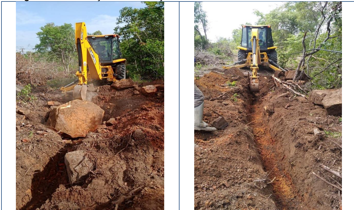
Figura 217 – Serviços de instalação dos dutos do backbone subterrâneo.
