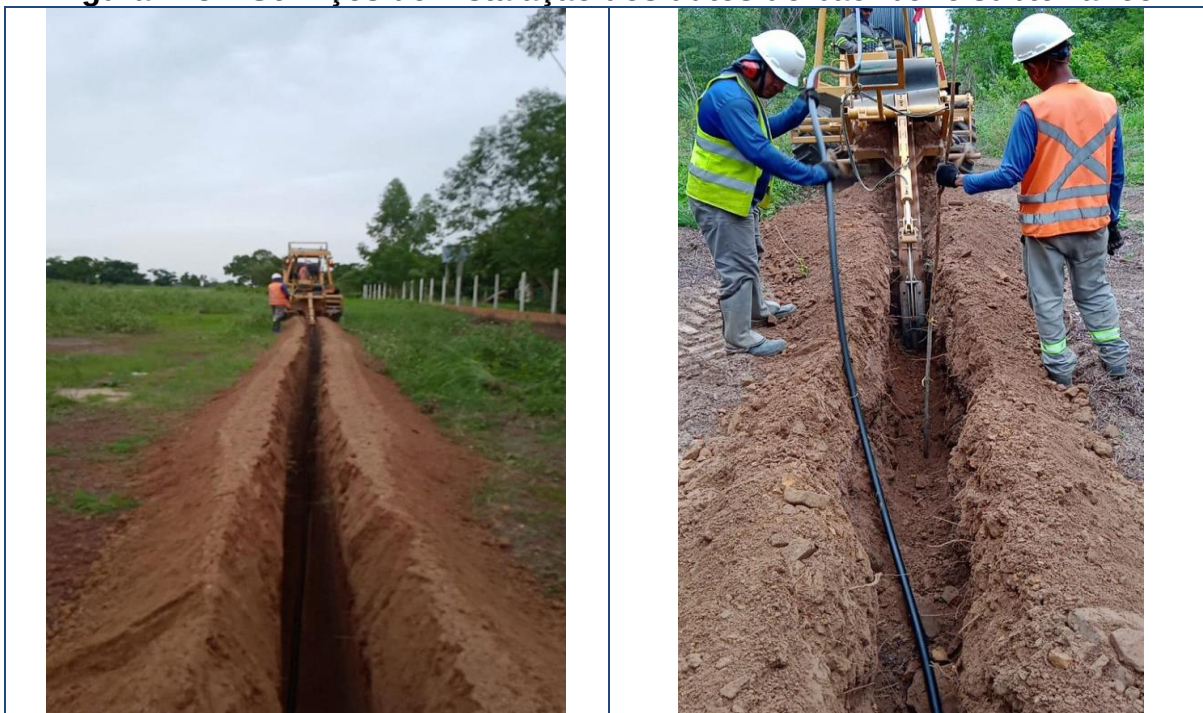
Figura 218 – Serviços de instalação dos dutos do backbone subterrâneo.
