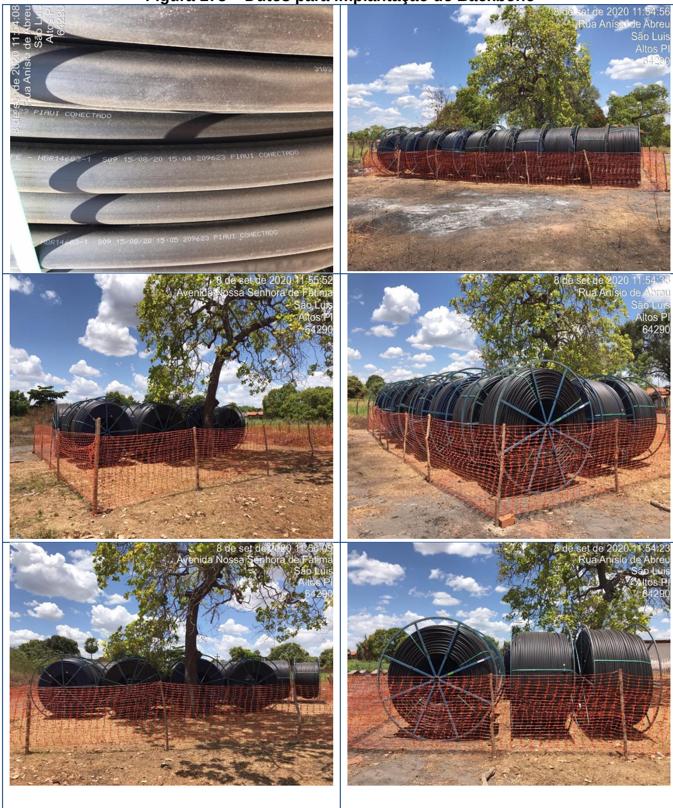
Figura 178 – Dutos para implantação do Backbone
