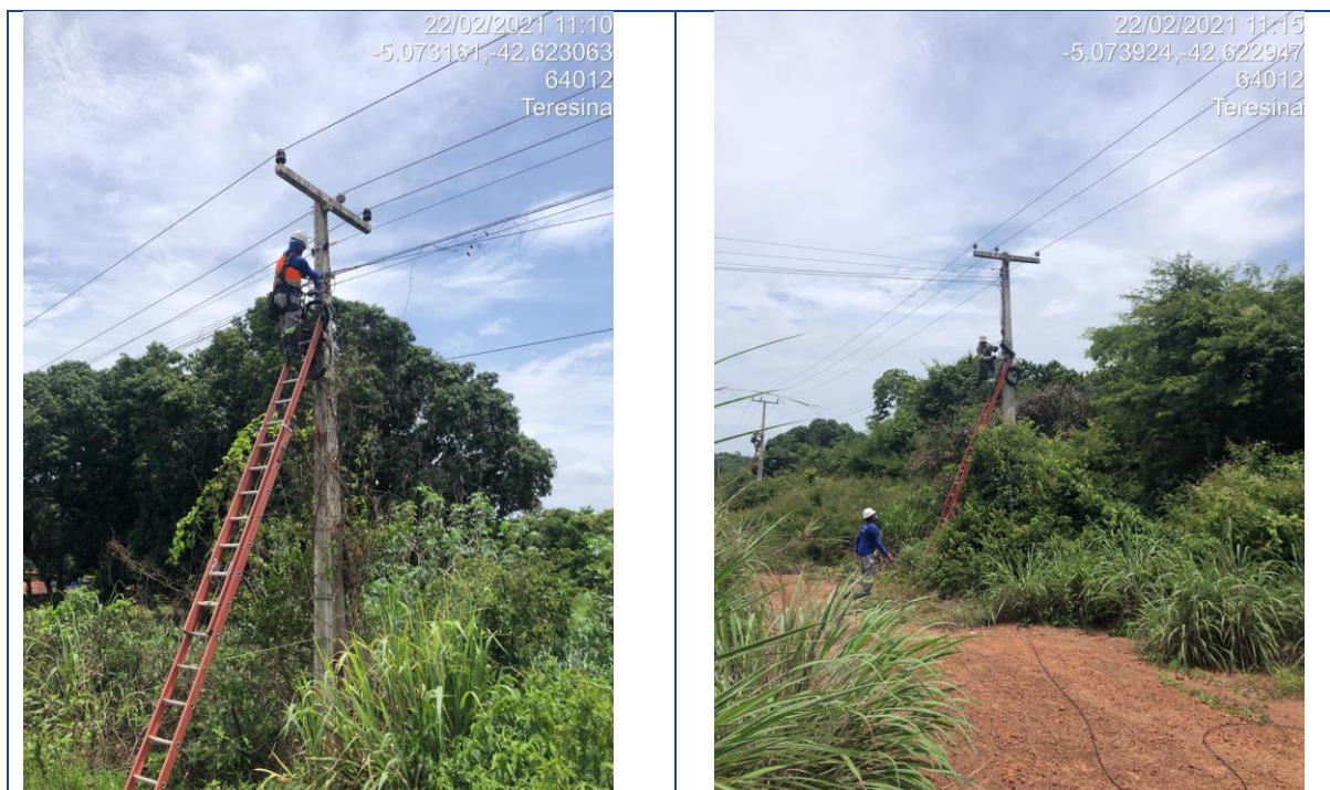
Figura 199 – Lançamento de Backbone aéreo trecho Teresina/Rodoanel - Fevereiro/2021
