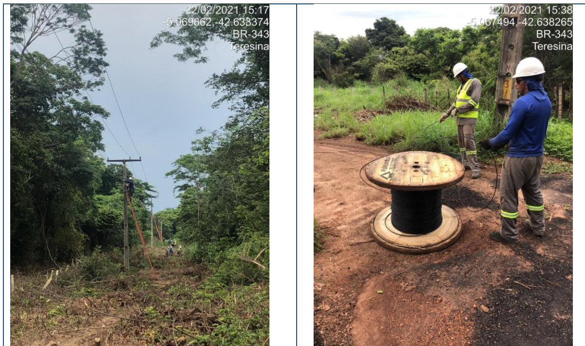
Figura 200 - Lançamento de Backbone aéreo trecho Teresina/Rodoanel Fevereiro/2021
