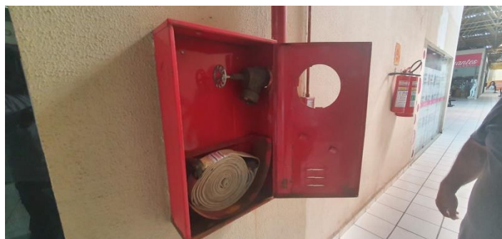
Foto 44 - Área de apoio
