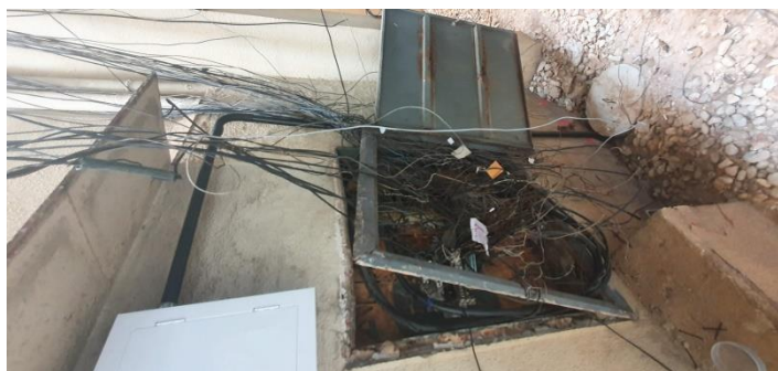
Foto 43 - Área de apoio
