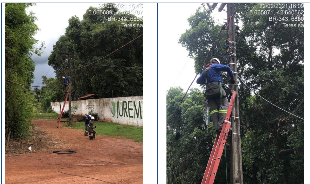
Figura 200 - Lançamento de Backbone aéreo trecho Teresina/Rodoanel
