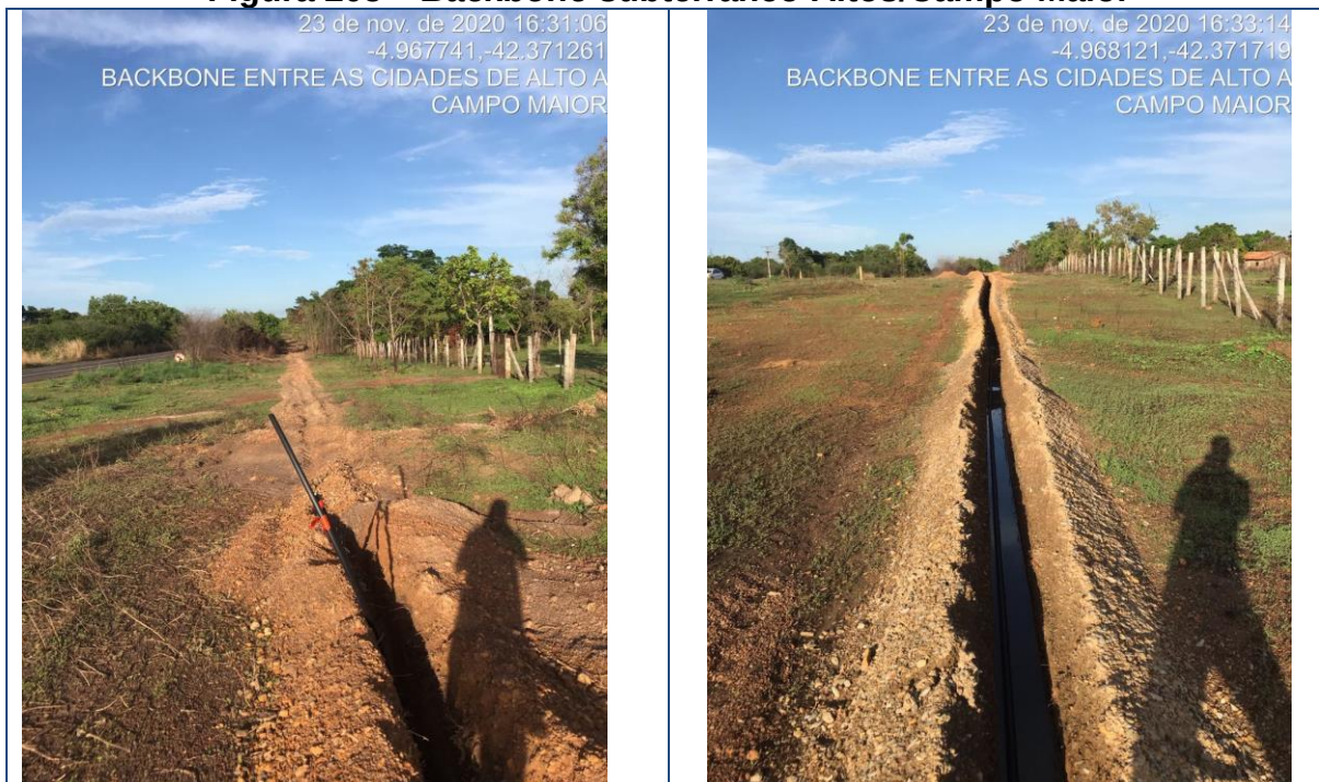
Figura 205 – Backbone subterrâneo Altos/Campo Maior
