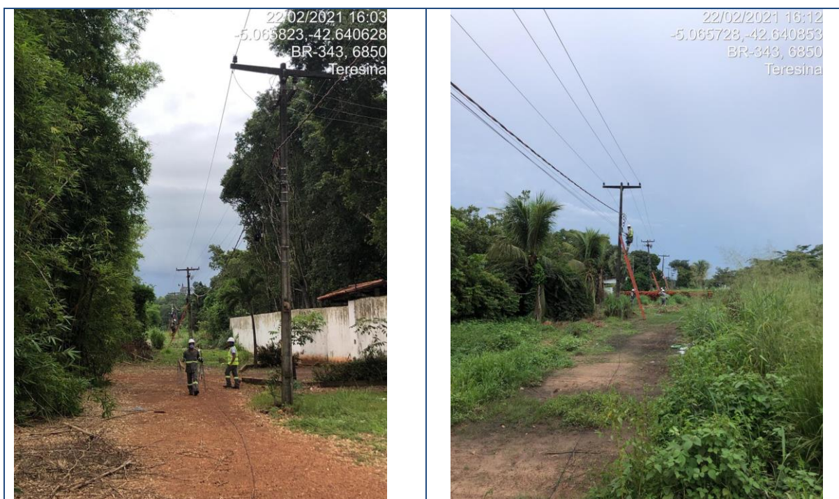
Figura 199 - Lançamento de Backbone aéreo trecho Teresina/Rodoanel
