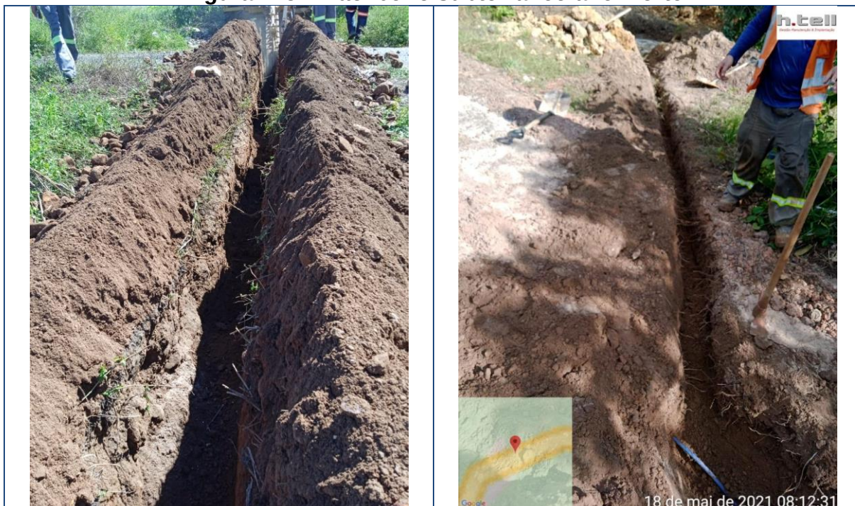
Figura 215 – Backbone subterrâneo anel norte
