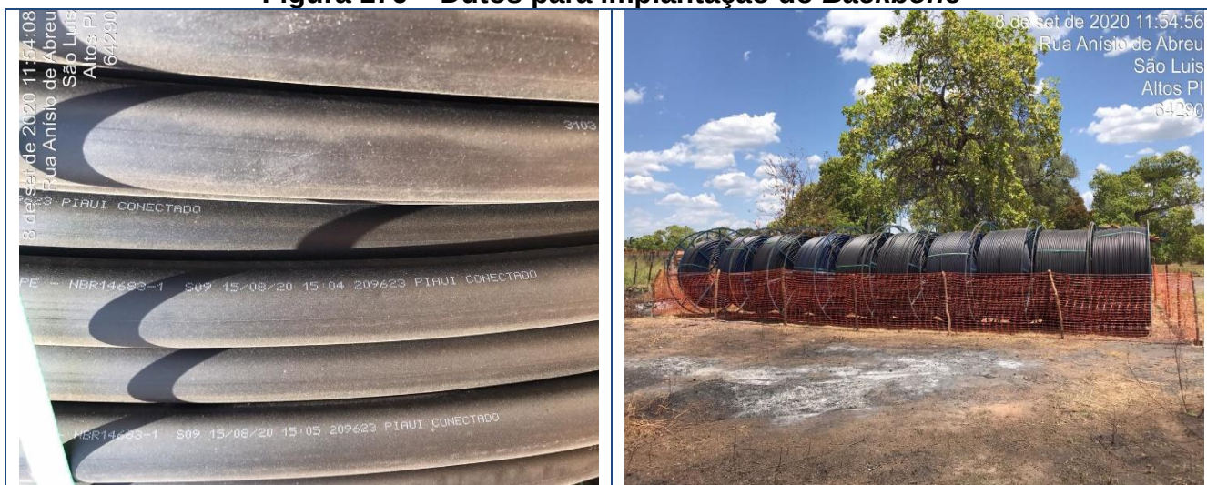
Figura 176 – Dutos para implantação do Backbone
