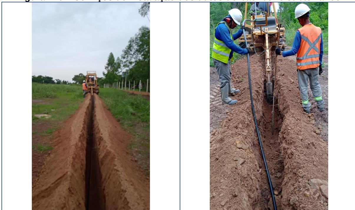
Figura 210 – Serviços de instalação dos dutos do backbone subterrâneo.
