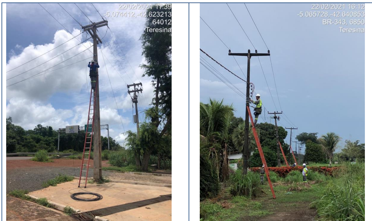
Figura 201 - Lançamento de Backbone aéreo trecho Teresina/Rodoanel
