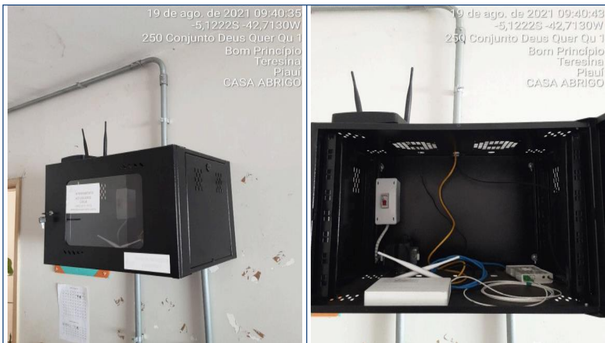
Figura 71 – PAG CETI João Henrique de Almeida Souza: NÃO CONFORME – Ausência de adesivo com contato para suporte no rack – Teresina
