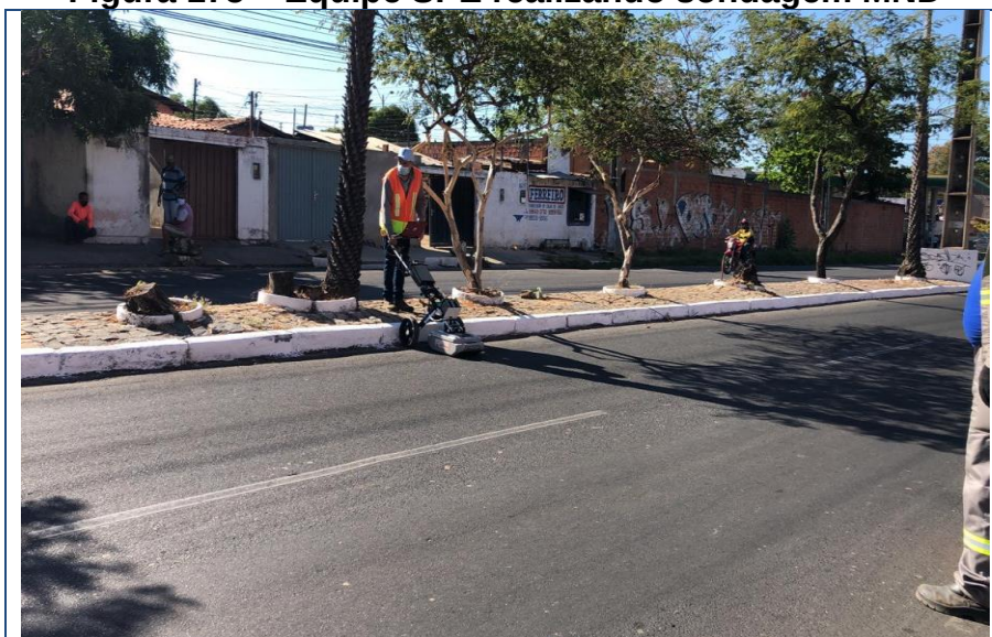
Figura 175 – Equipe SPE realizando sondagem MND
