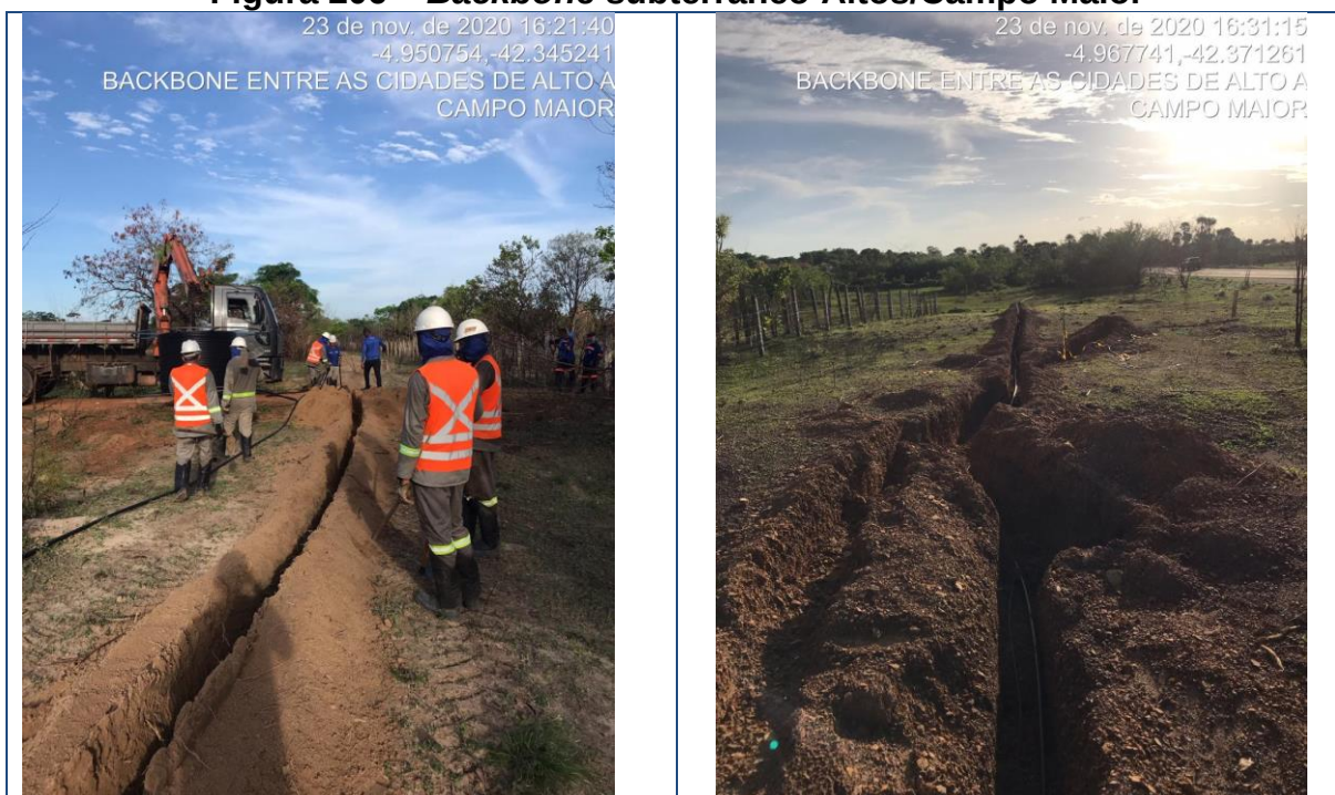
Figura 206 – Backbone subterrâneo Altos/Campo Maior
