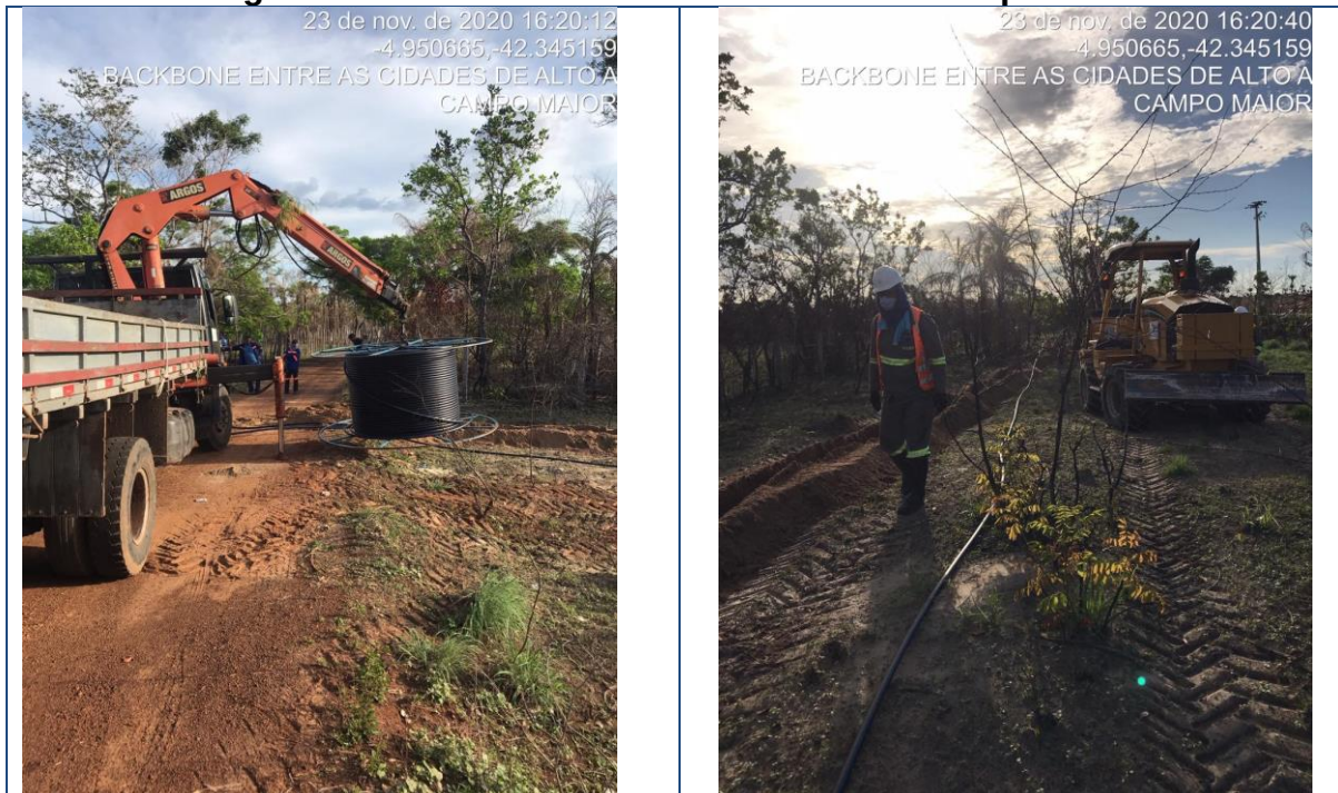
Figura 208 – Backbone subterrâneo Altos/Campo Maior
