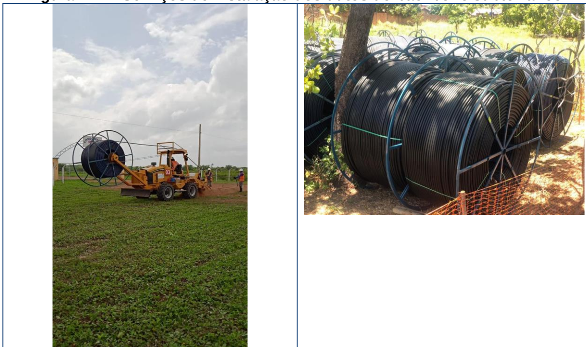
Figura 212 – Serviços de instalação dos dutos do backbone subterrâneo.
