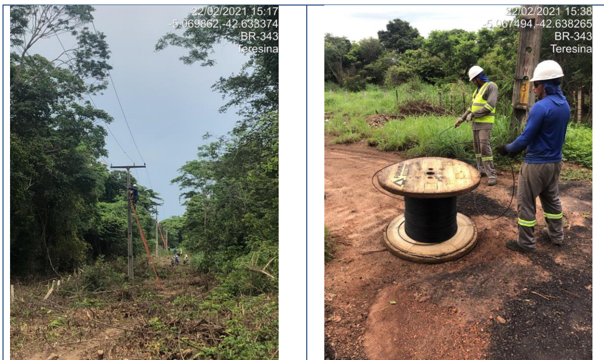
Figura 198 - Lançamento de Backbone aéreo trecho Teresina/Rodoanel
