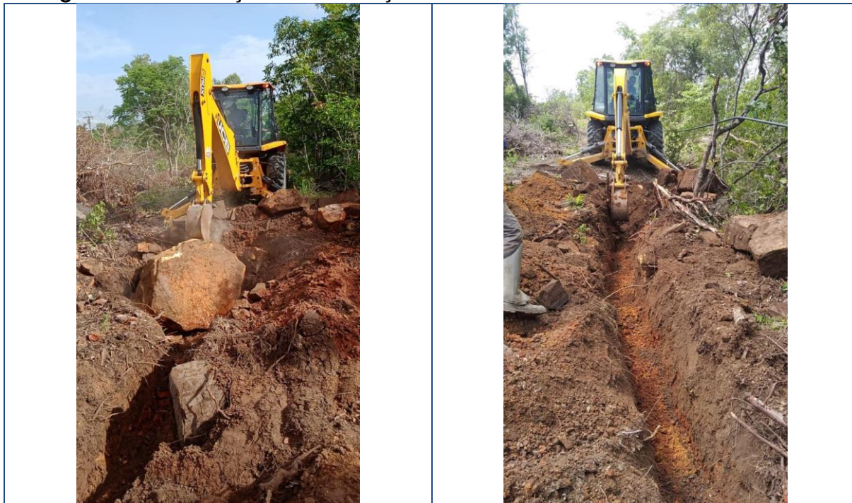
Figura 209 – Serviços de instalação dos dutos do backbone subterrâneo.
