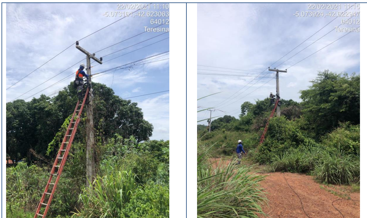
Figura 197 – Lançamento de Backbone aéreo trecho Teresina/Rodoanel
