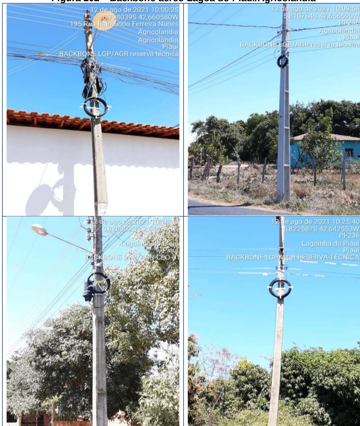
Figura 202 – Backbone aéreo Lagoa do Piauí/Agricolândia
