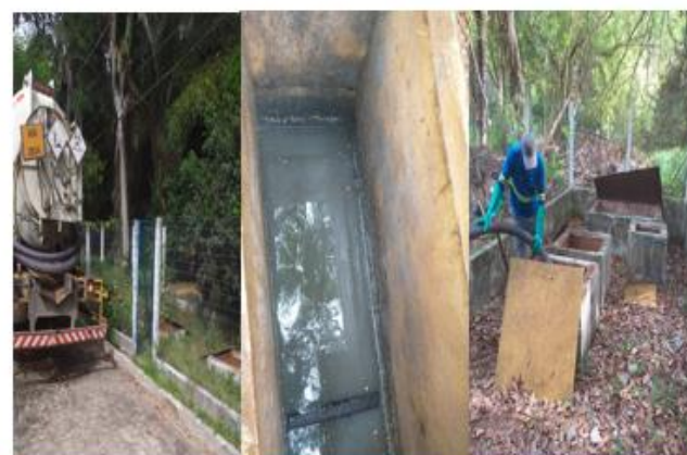
Limpeza caixa de areia, reatores e filtro ETE Terra dos Pássaros I, II, III
