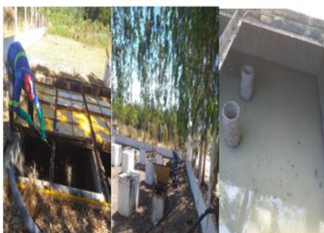
Limpeza caixa de areia e reatores da ETE Bosque Sul
