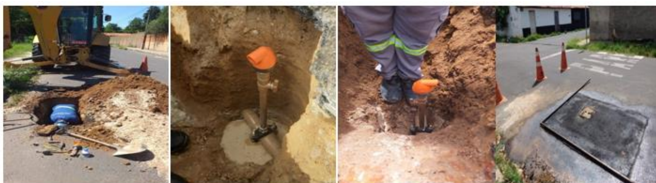
Instalação de Ventosas – Bairros Esplanada, Dirceu, Satélite e Jacinta Andrade
