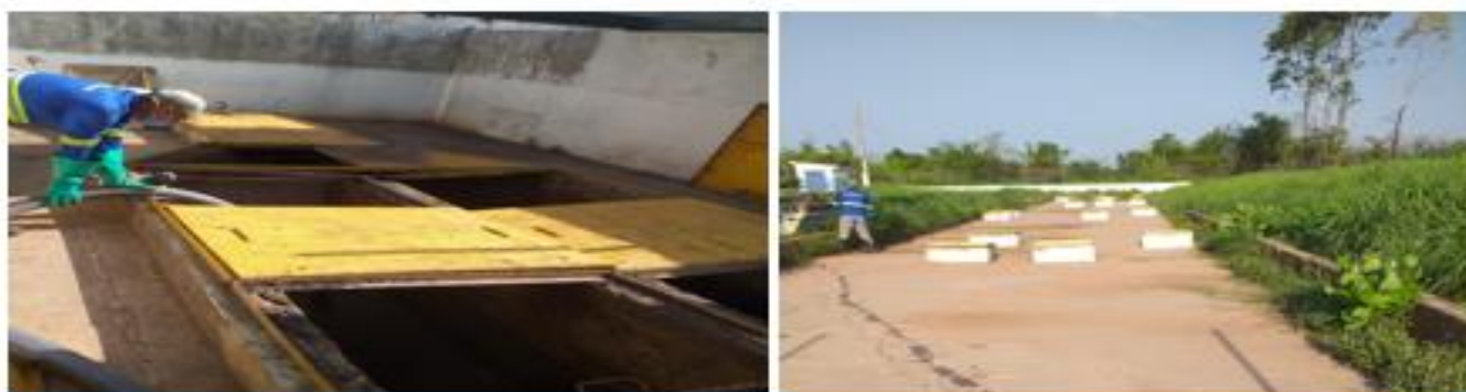
Limpeza caixa de areia e reatores da ETE Sigefredo Pacheco
