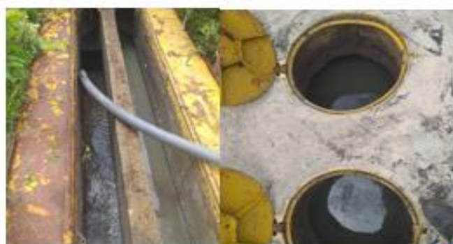
Limpeza caixa de areia e reatores da ETE Orgulho do Piauí
