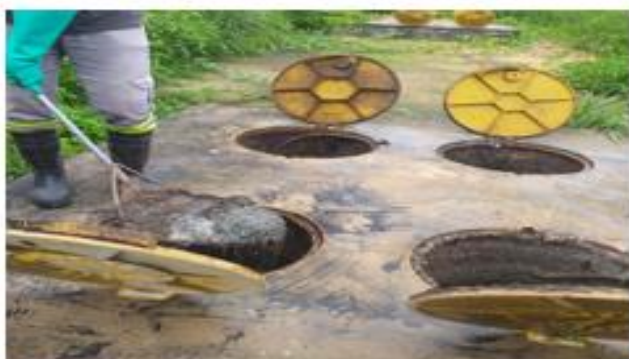
Limpeza caixa de areia e reatores da ETE Orgulho do Piauí
