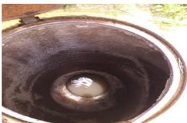
Limpeza dos reatores da ETE Francisco das Chagas
