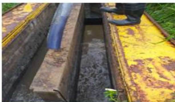
Limpeza caixa de areia e reatores da ETE Orgulho do Piauí
