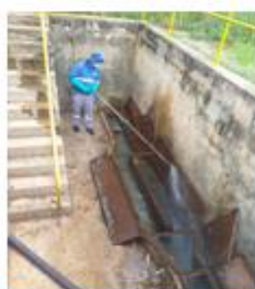
Limpeza caixa de areia e reatores ETE Francisco das Chagas
