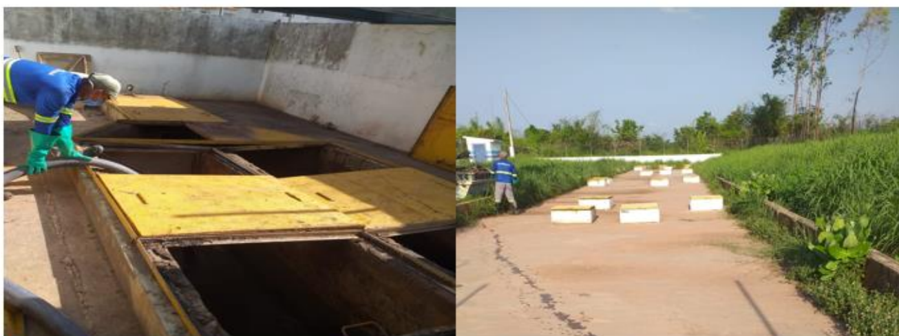
Limpeza caixa de areia e reatores da ETE Sigefredo Pacheco
