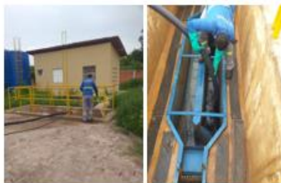
Limpeza caixa de areia ETE Lucídio Freitas
