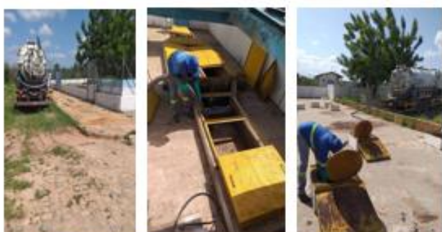
Limpeza da caixa de areia e reatores da ETE Sigefredo Pacheco
