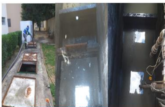
Limpeza caixa de areia e poço ETE Margens do Poti
