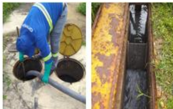
Limpeza caixa de areia e reatores ETE Orgulho
