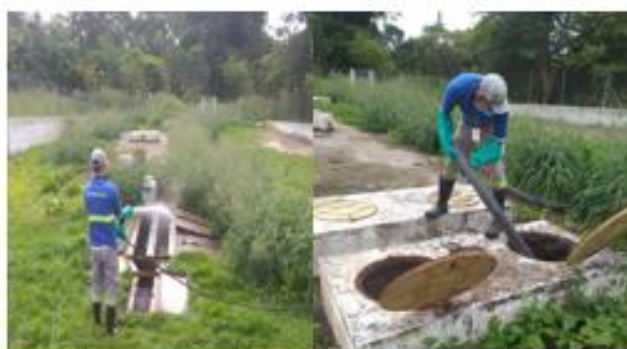
Limpeza caixa de areia e reatores da ETE Eduardo Costa
