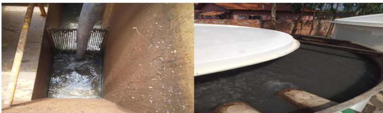
Limpeza dos caixa de areia e reatores da ETE Edigar Gaioso
