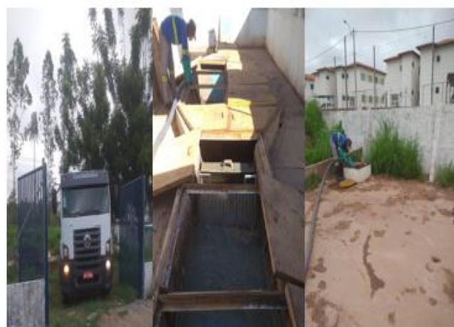
Limpeza caixa de areia, reatores e filtros ETE Sigefredo Pacheco
