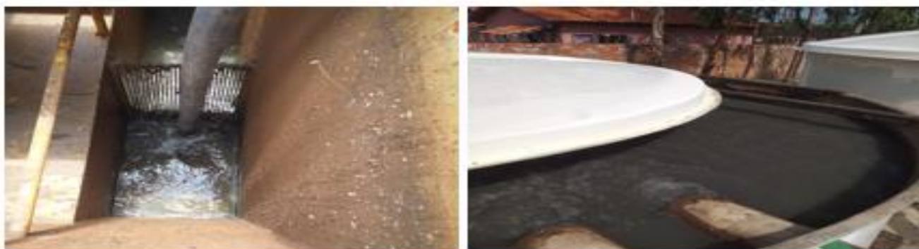
Limpeza dos caixa de areia e reatores da ETE Edigar Gaioso
