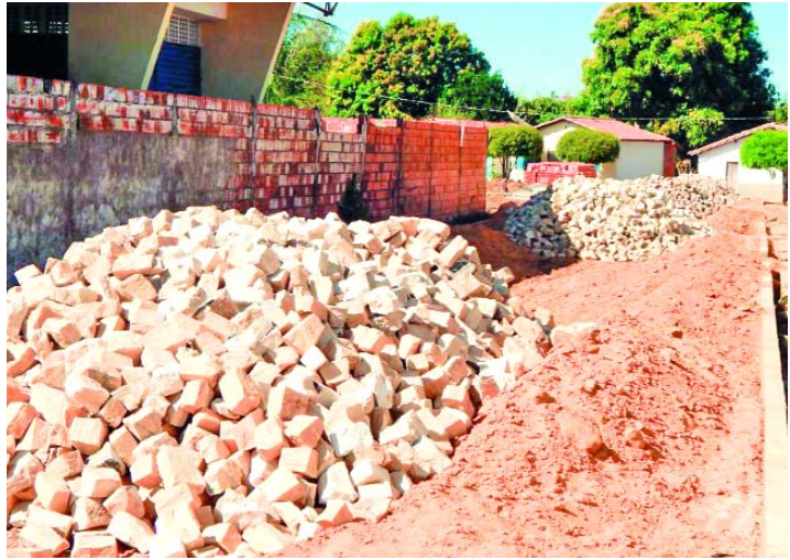
RUAS estão recebendo pavimentação poliédrica
