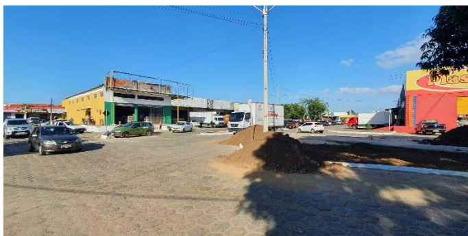
Sinalização e Circulação de Pedestres – Foto 13
