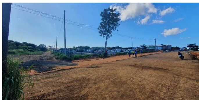
Manutenção do entreposto – Foto 20
