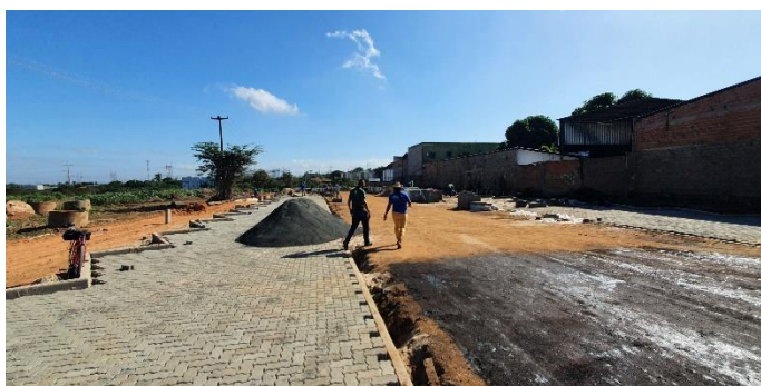
Manutenção do entreposto – Foto 19
