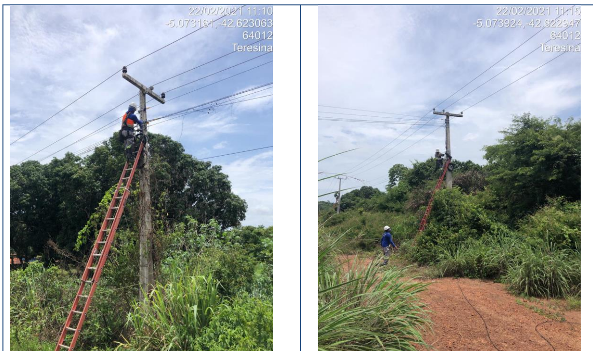
Figura 232 – Lançamento de Backbone aéreo trecho Teresina/Rodoanel
