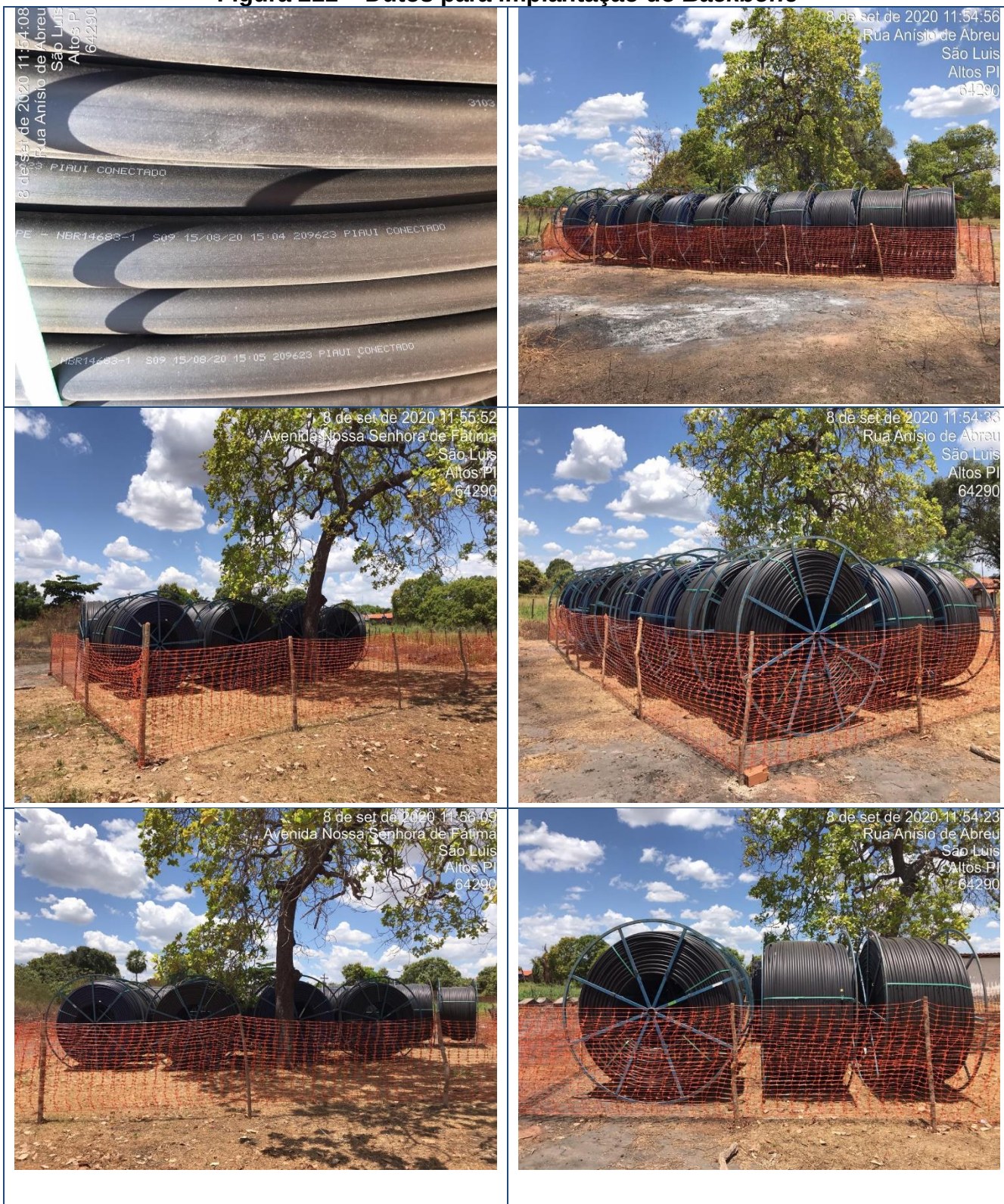
Figura 211 – Dutos para implantação do Backbone
