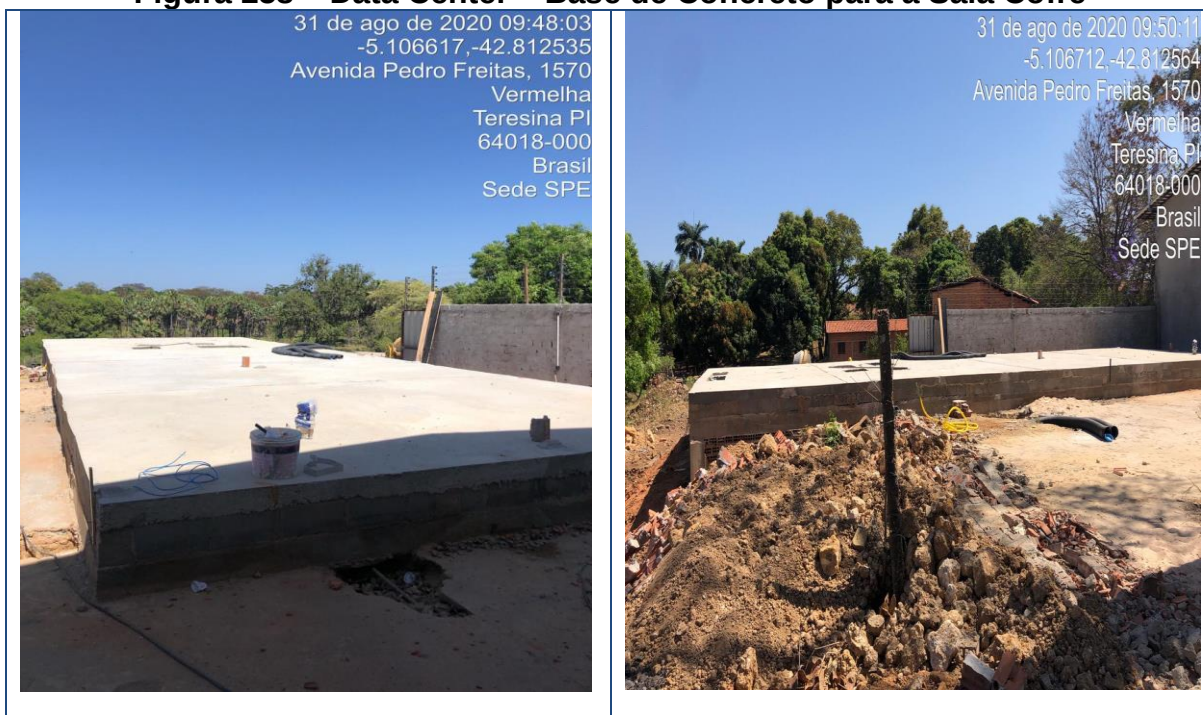
Figura 258 – Data Center – Base de Concreto para a Sala Cofre
