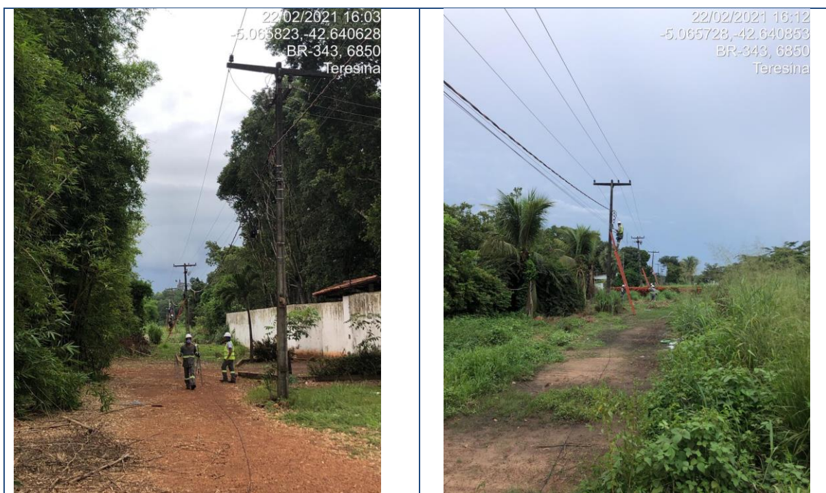
Figura 234 - Lançamento de Backbone aéreo trecho Teresina/Rodoanel
