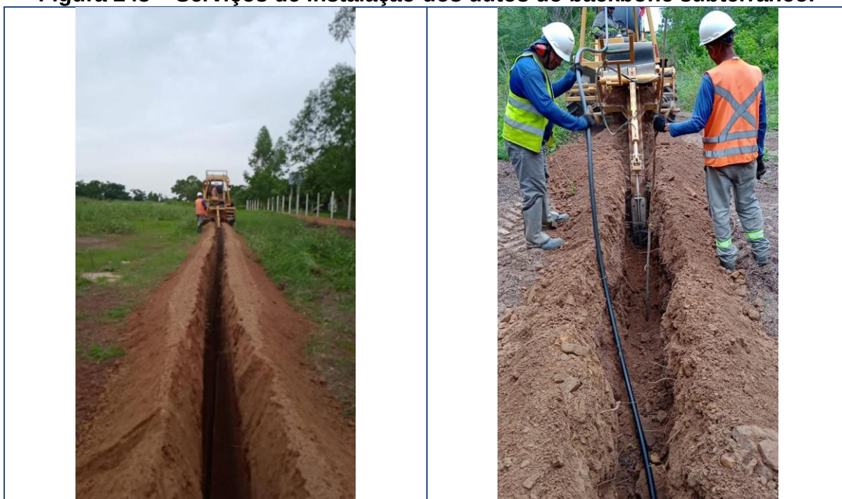
Figura 243 – Serviços de instalação dos dutos do backbone subterrâneo.
