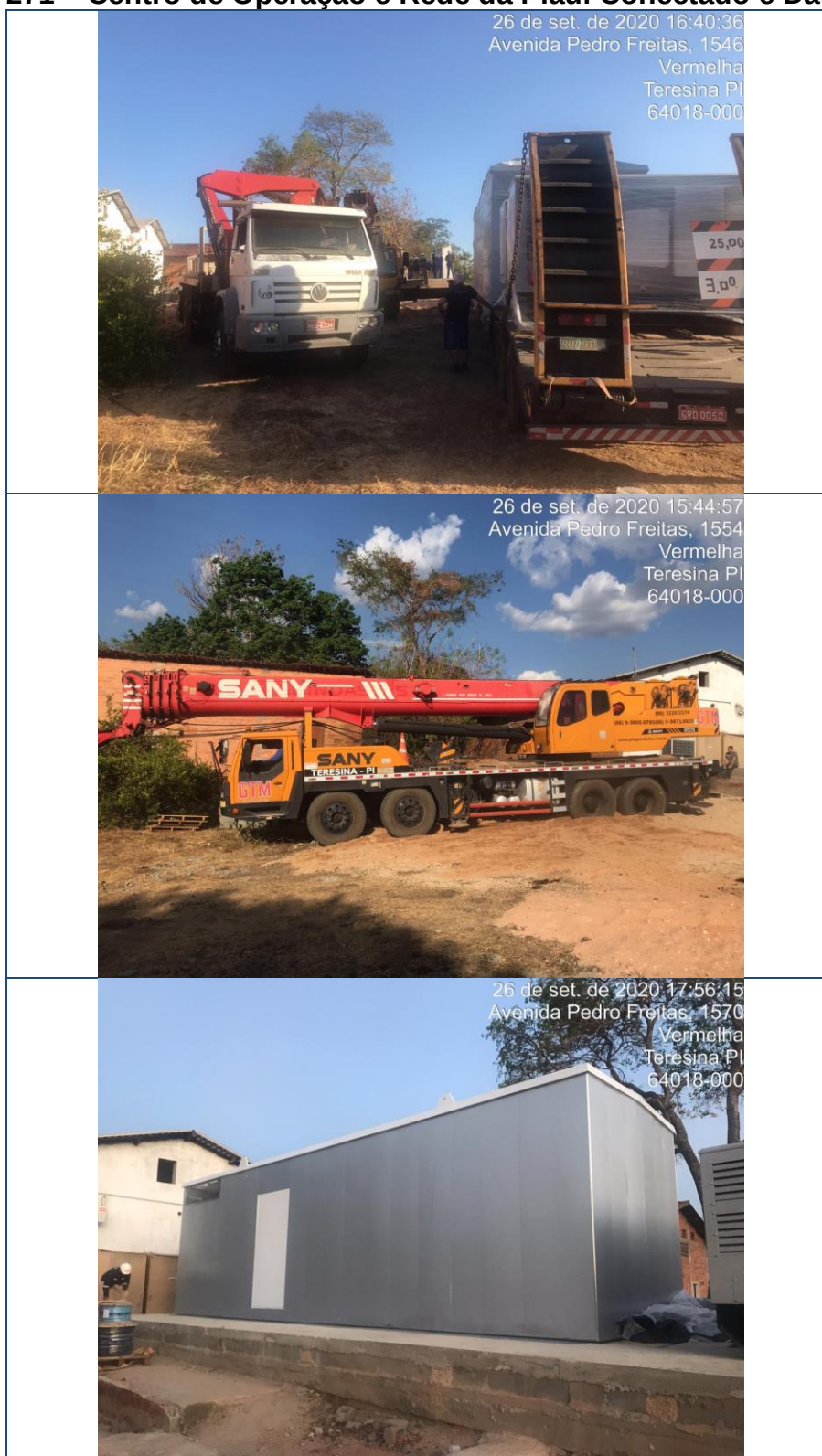
Figura 271 – Centro de Operação e Rede da Piauí Conectado e Datacenter
