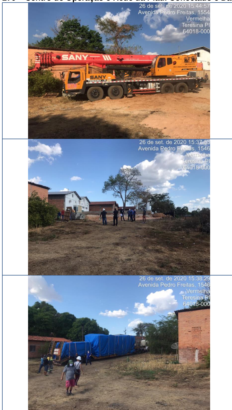
Figura 270 – Centro de Operação e Rede da Piauí Conectado e Datacenter
