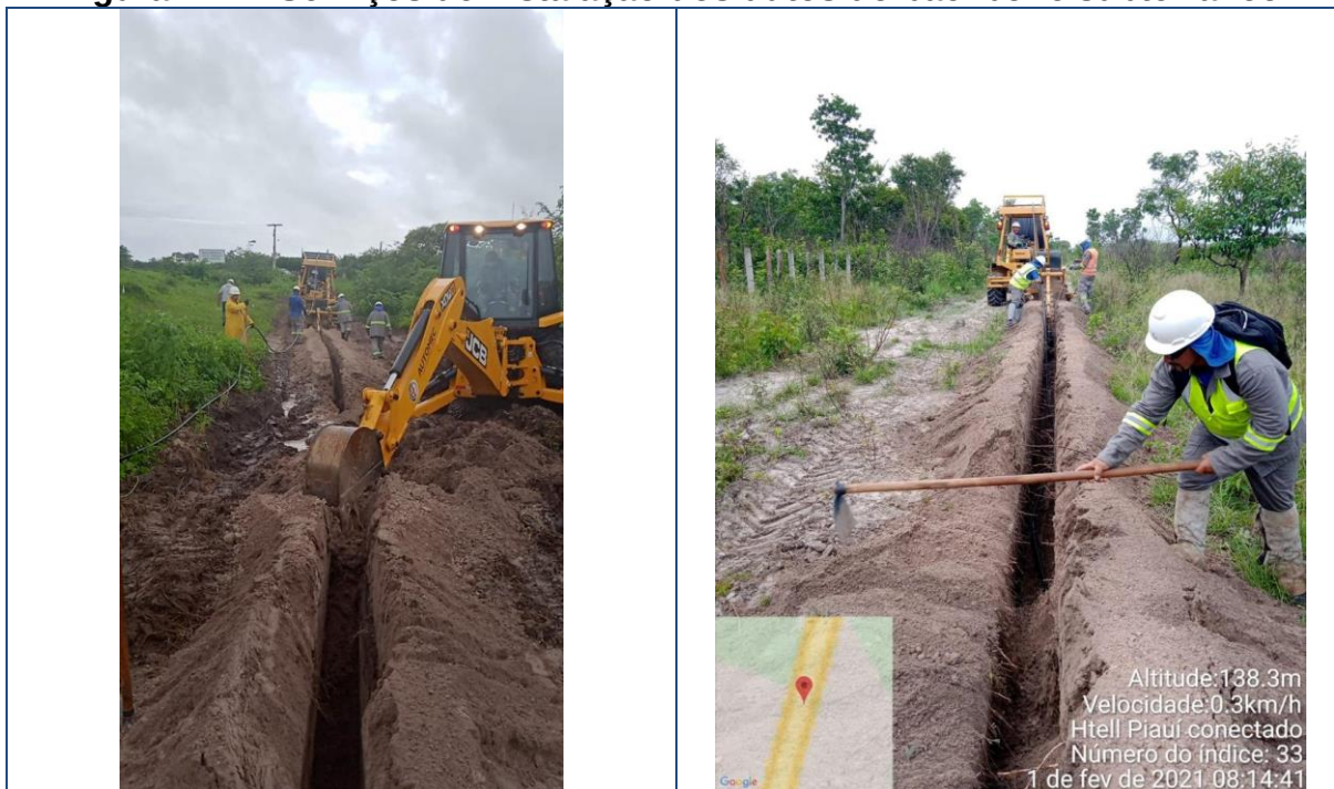
Figura 244 – Serviços de instalação dos dutos do backbone subterrâneo.
