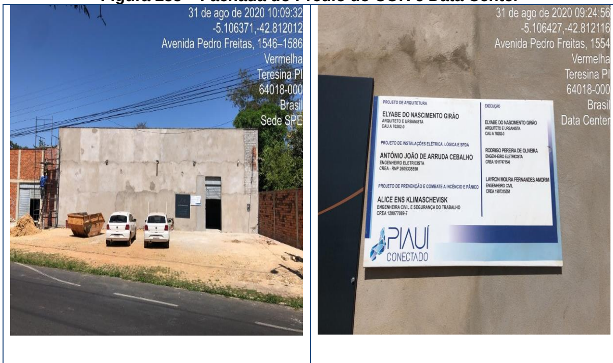
Figura 255 – Fachada do Prédio do COR e Data Center
