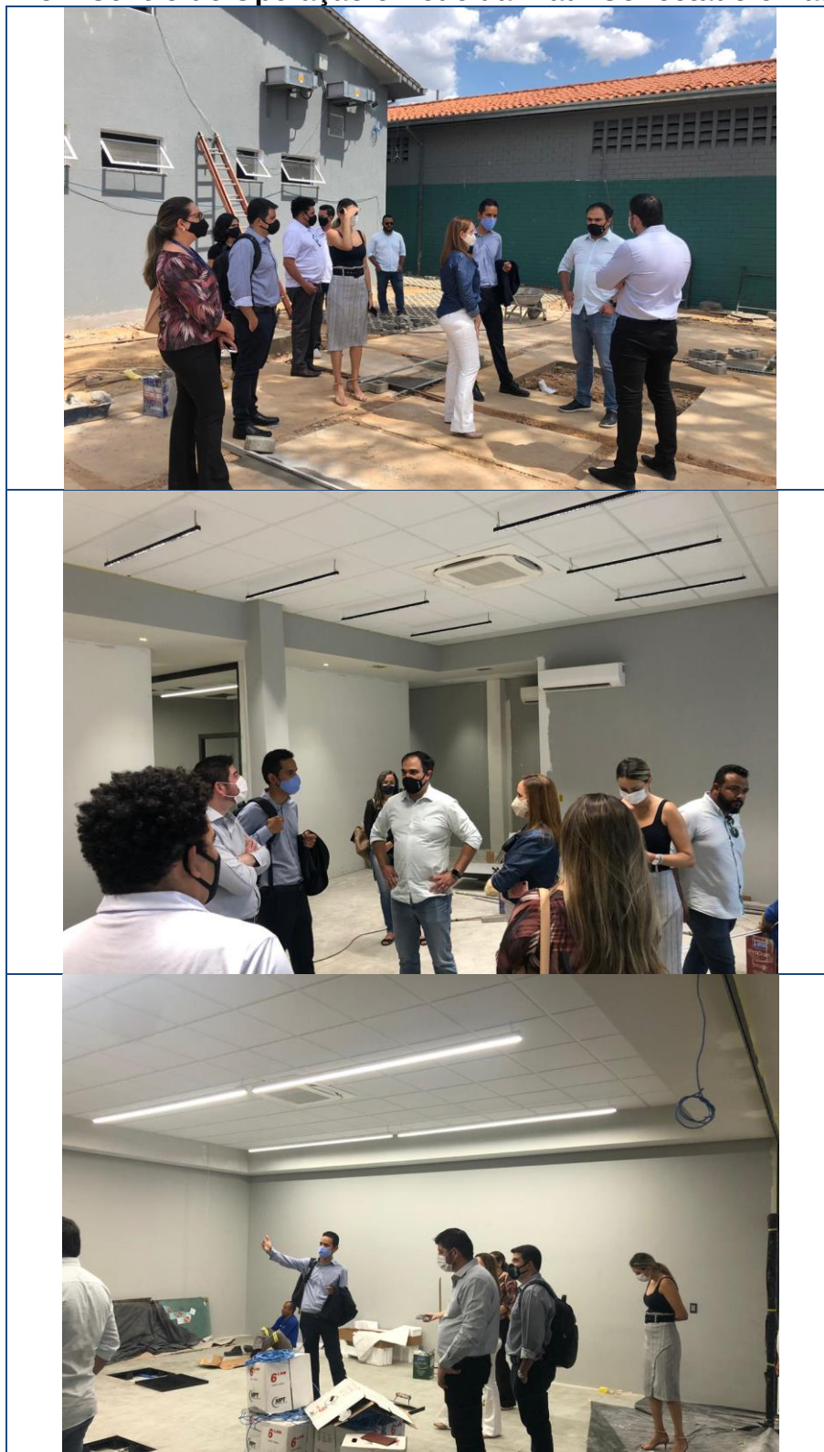
Figura 275 – Centro de Operação e Rede da Piauí Conectado e Datacenter
