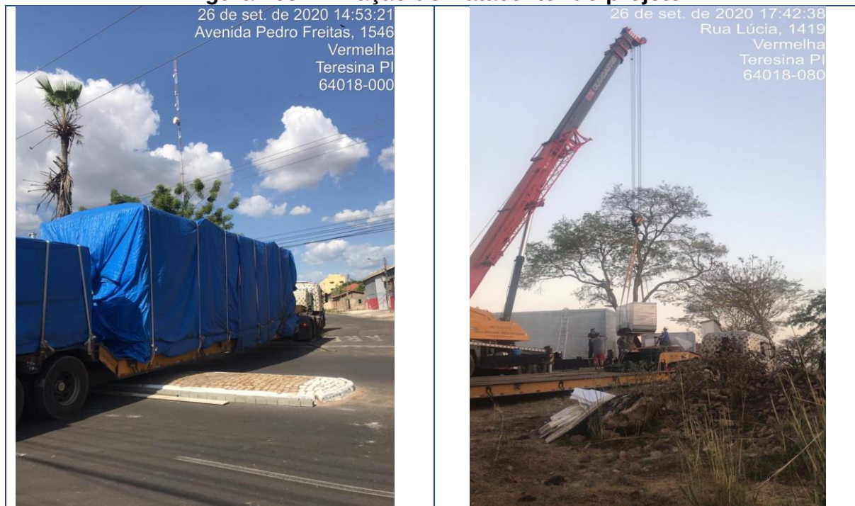
Figura 268 – Fixação do Datacenter do projeto
