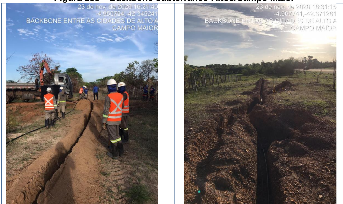
Figura 238 – Backbone subterrâneo Altos/Campo Maior
