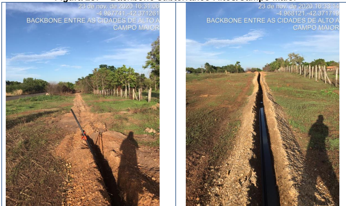
Figura 237 – Backbone subterrâneo Altos/Campo Maior
