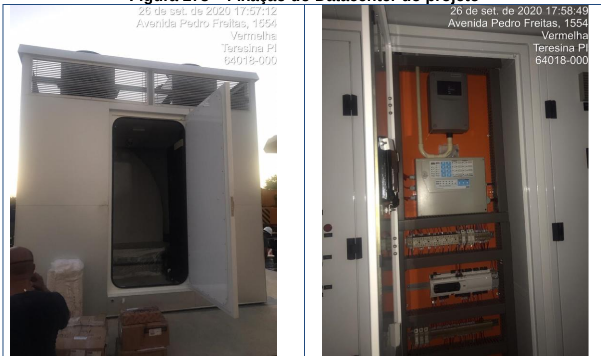
Figura 273 – Fixação do Datacenter do projeto
