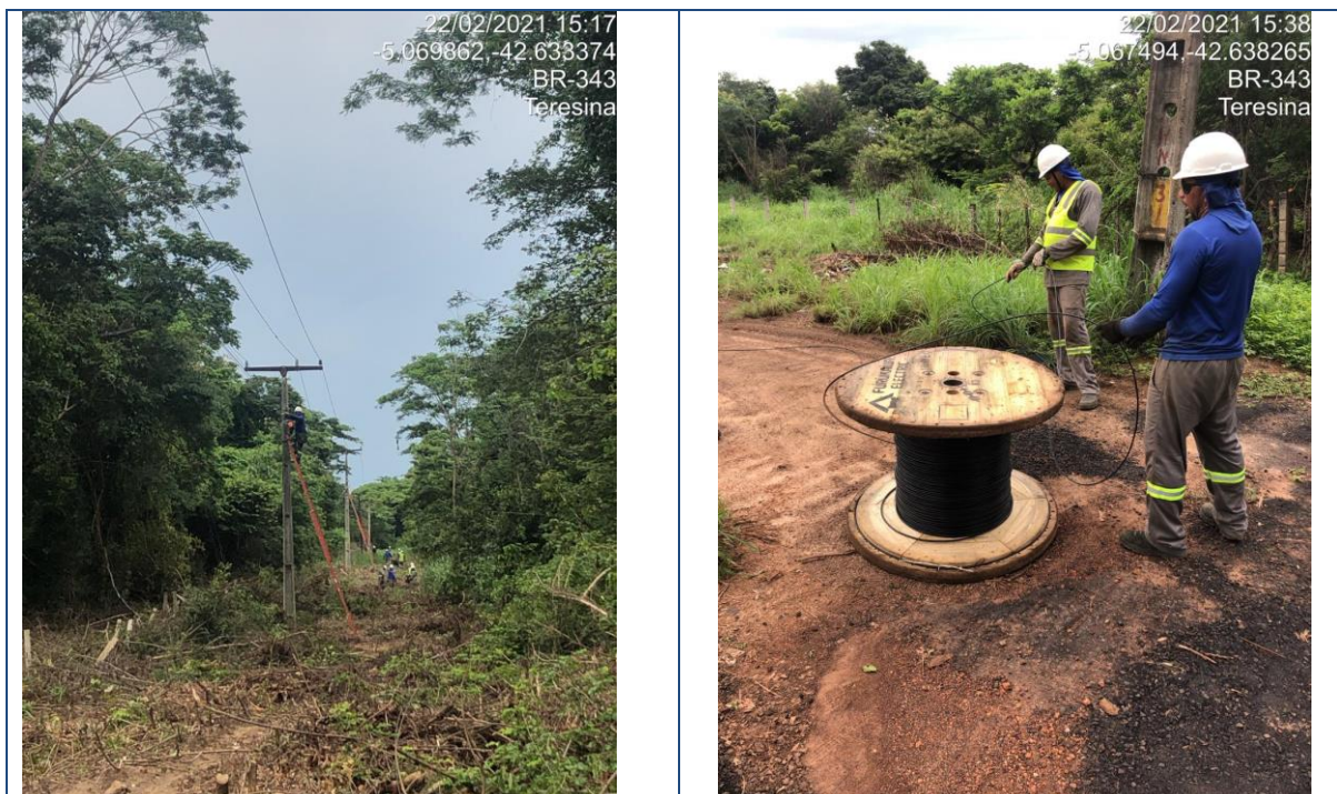
Figura 233 - Lançamento de Backbone aéreo trecho Teresina/Rodoanel
