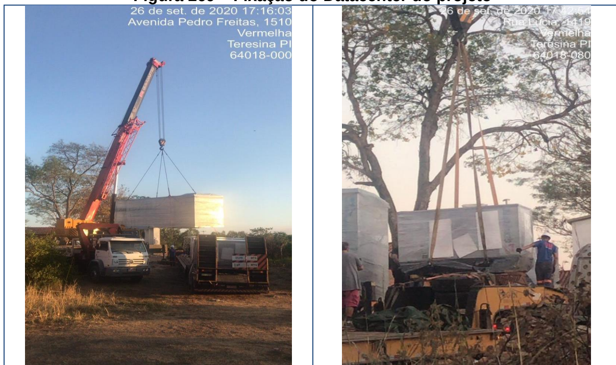
Figura 269 – Fixação do Datacenter do projeto
