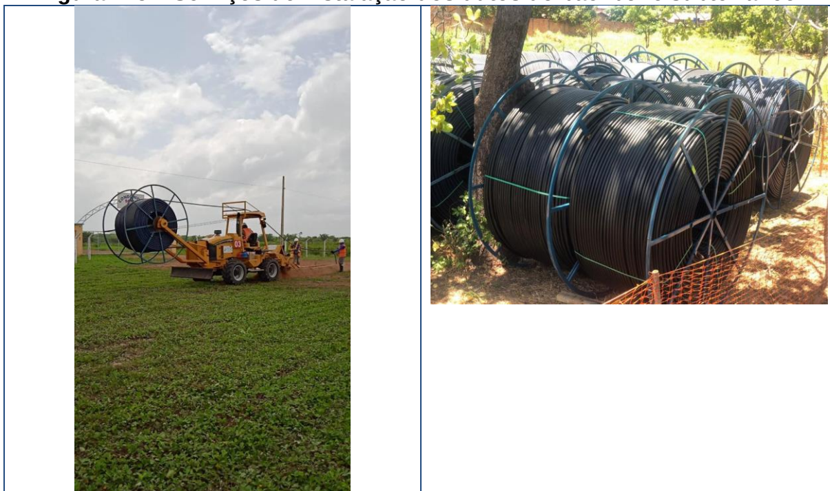
Figura 245 – Serviços de instalação dos dutos do backbone subterrâneo.
