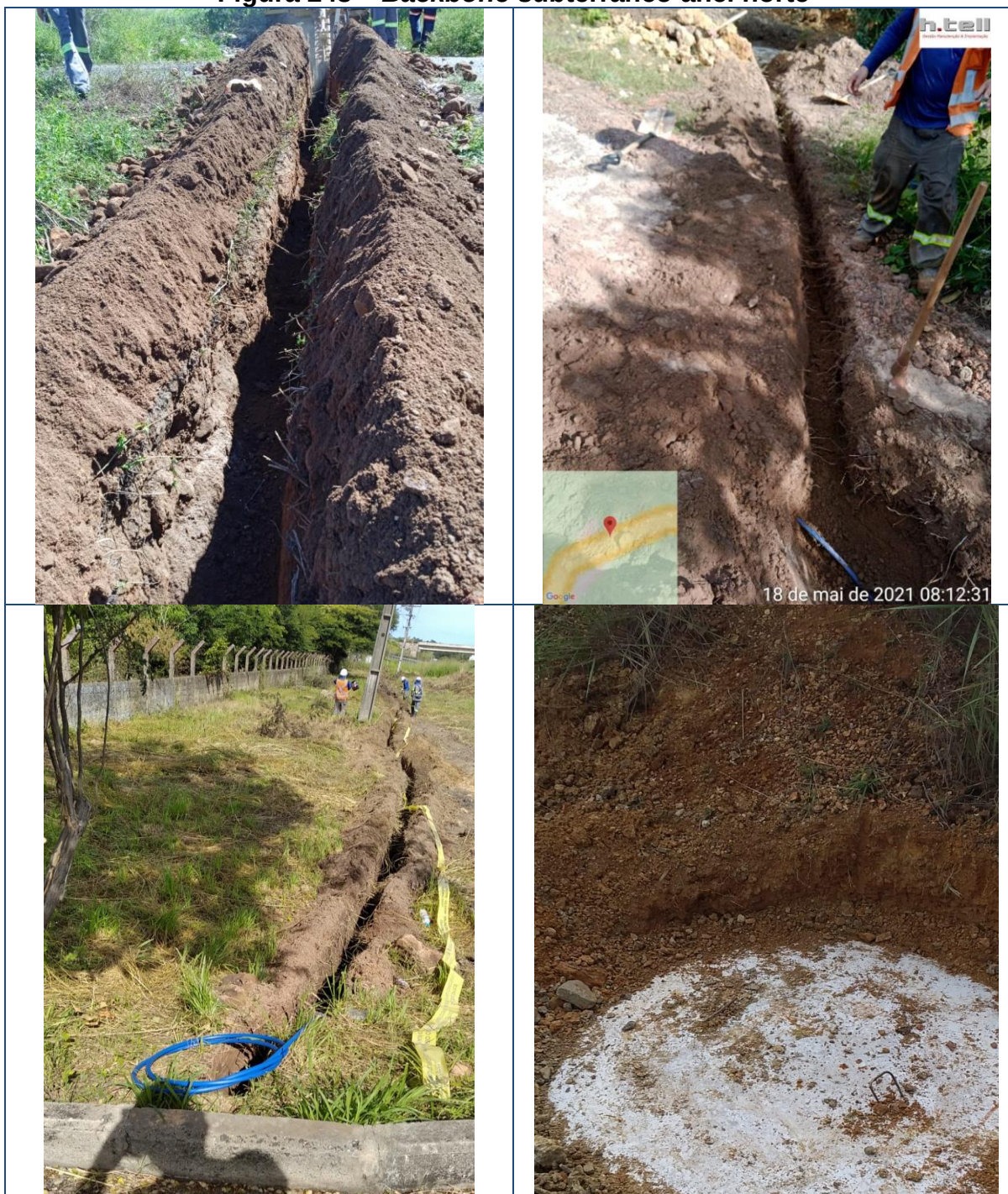
Figura 248 – Backbone subterrâneo anel norte
