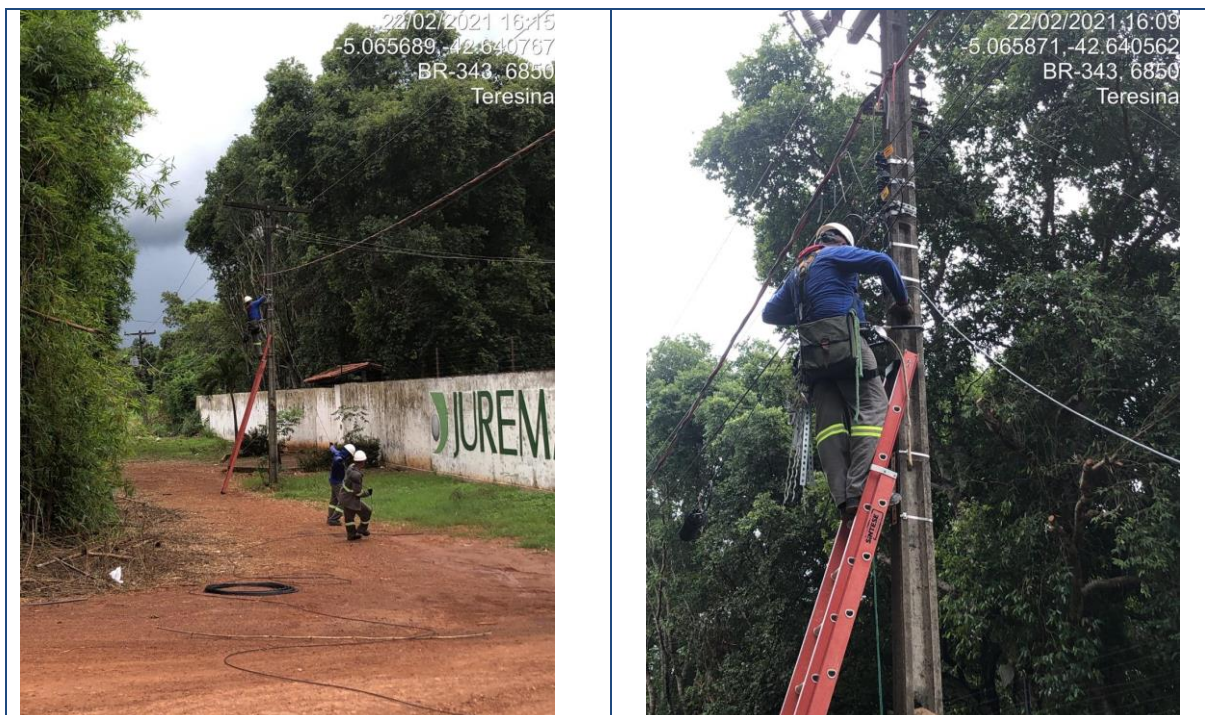
Figura 235 - Lançamento de Backbone aéreo trecho Teresina/Rodoanel
