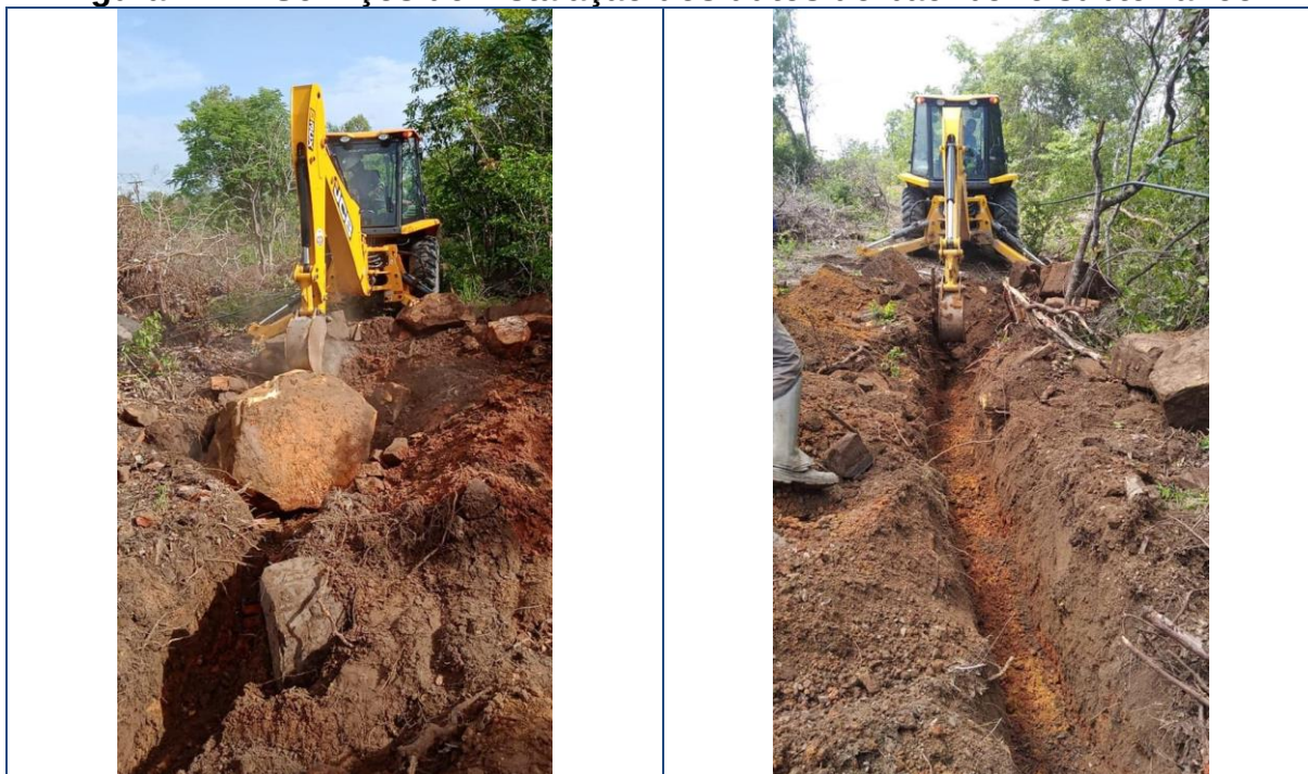
Figura 242 – Serviços de instalação dos dutos do backbone subterrâneo.
