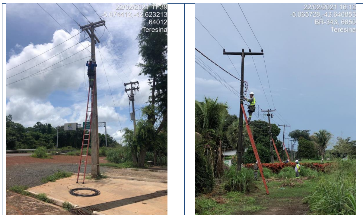
Figura 185 - Lançamento de Backbone aéreo trecho Teresina/Rodoanel
