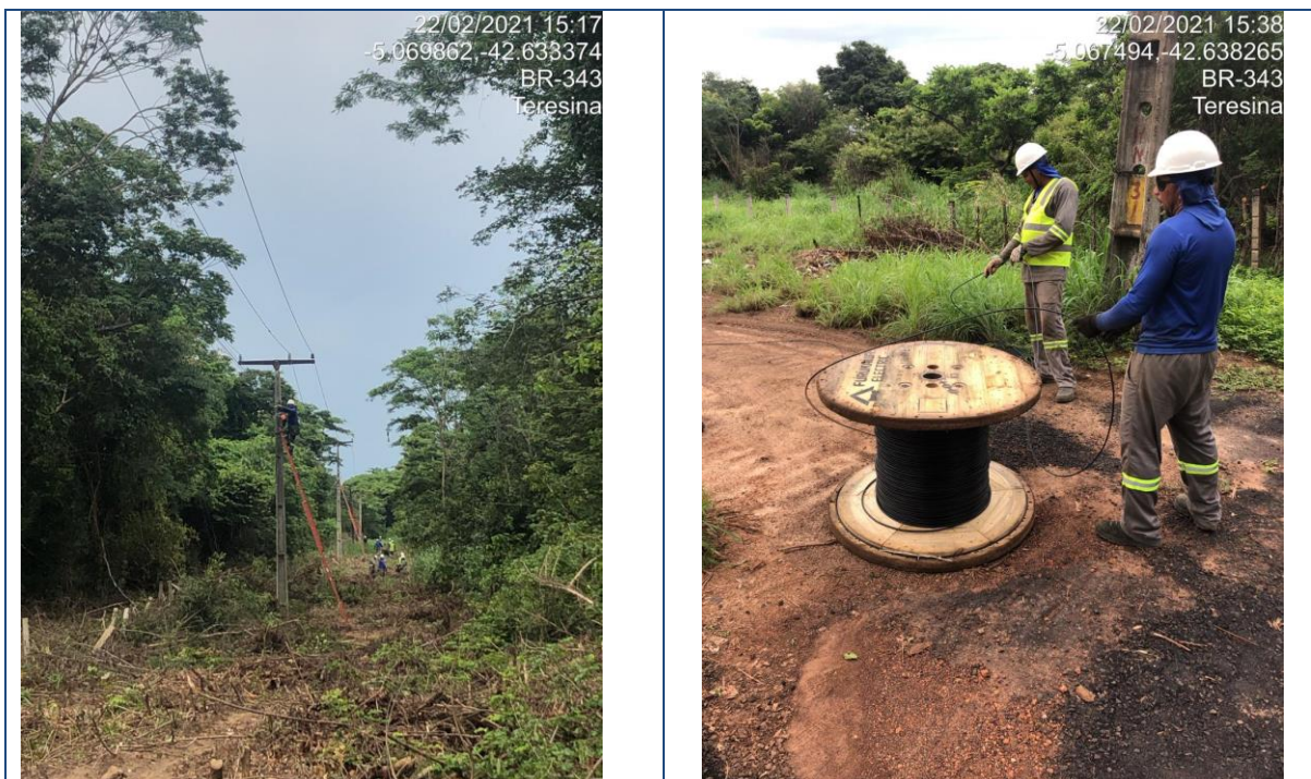
Figura 182 - Lançamento de Backbone aéreo trecho Teresina/Rodoanel
