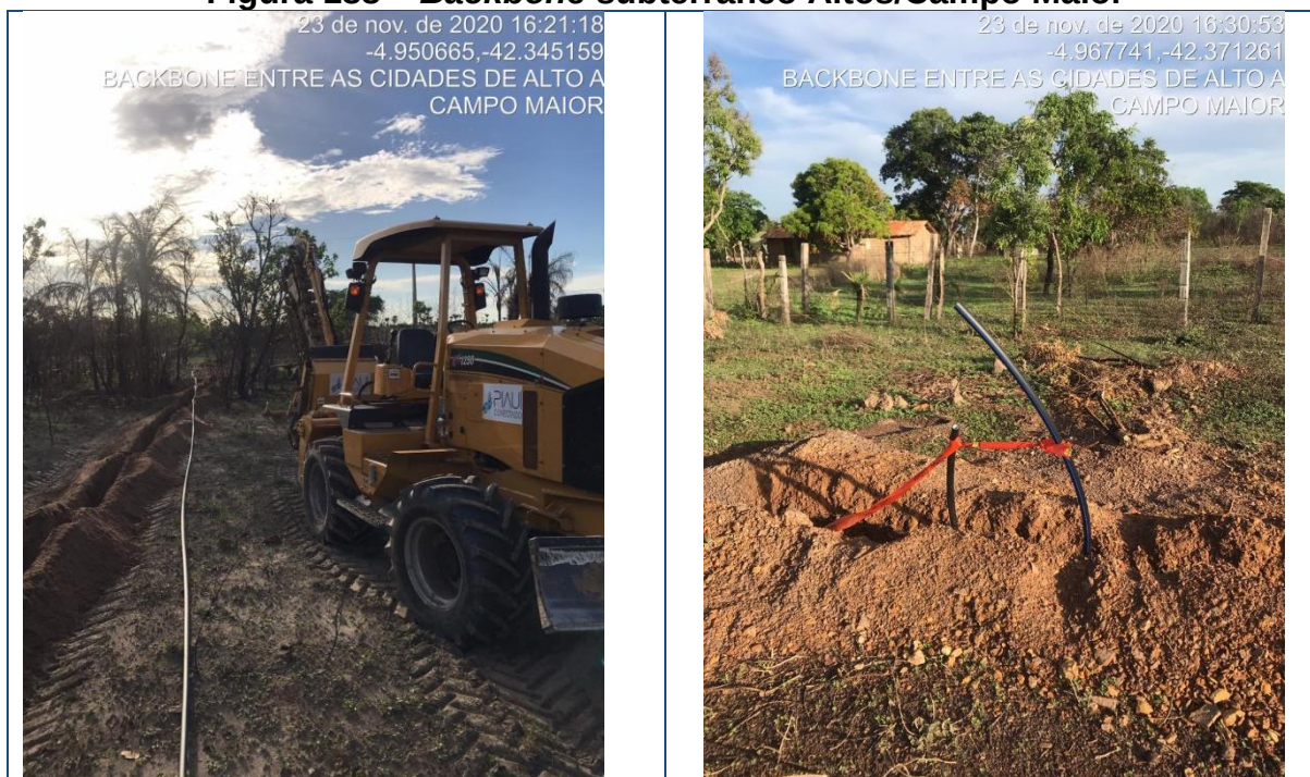
Figura 188 – Backbone subterrâneo Altos/Campo Maior
