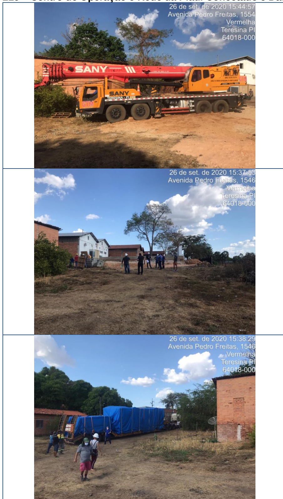
Figura 216 – Centro de Operação e Rede da Piauí Conectado e Datacenter
