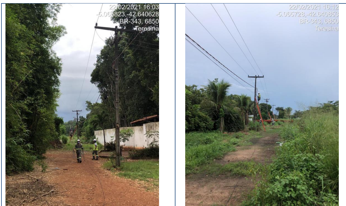
Figura 183 - Lançamento de Backbone aéreo trecho Teresina/Rodoanel
