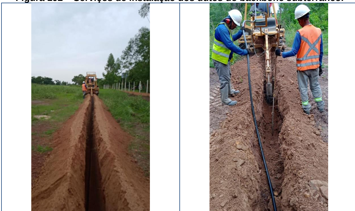
Figura 192 – Serviços de instalação dos dutos do backbone subterrâneo.
