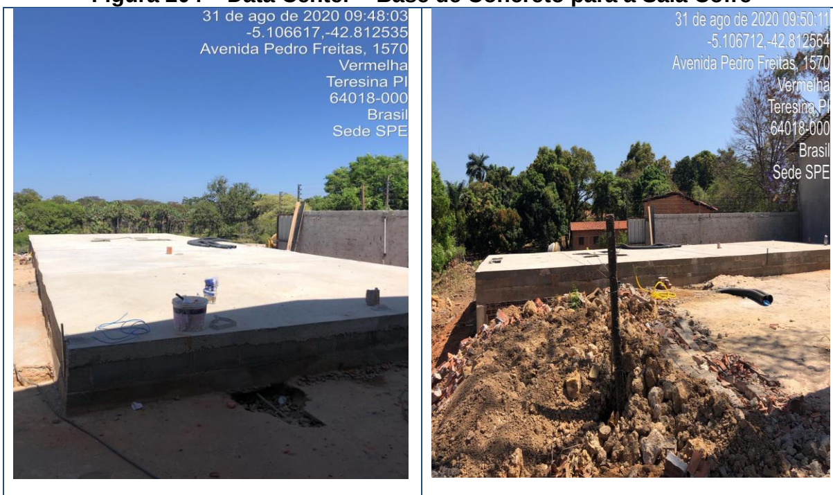
Figura 204 – Data Center – Base de Concreto para a Sala Cofre
