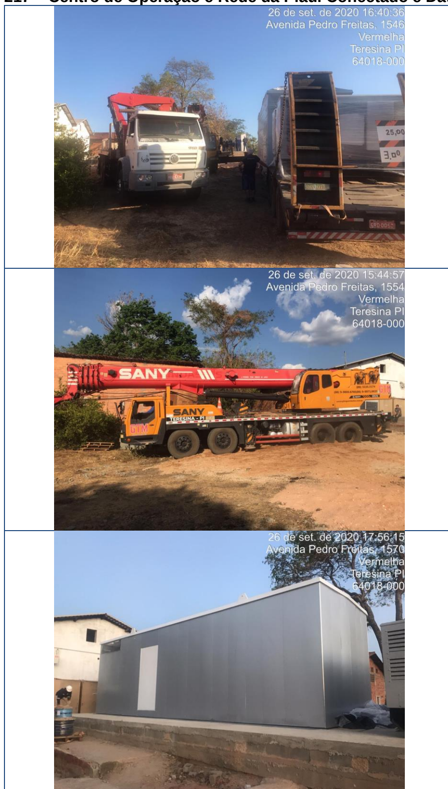
Figura 217 – Centro de Operação e Rede da Piauí Conectado e Datacenter
