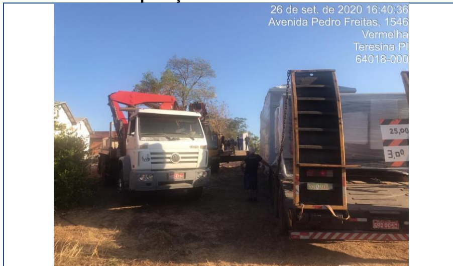
Figura 220 – Centro de Operação e Rede da Piauí Conectado e Datacenter
