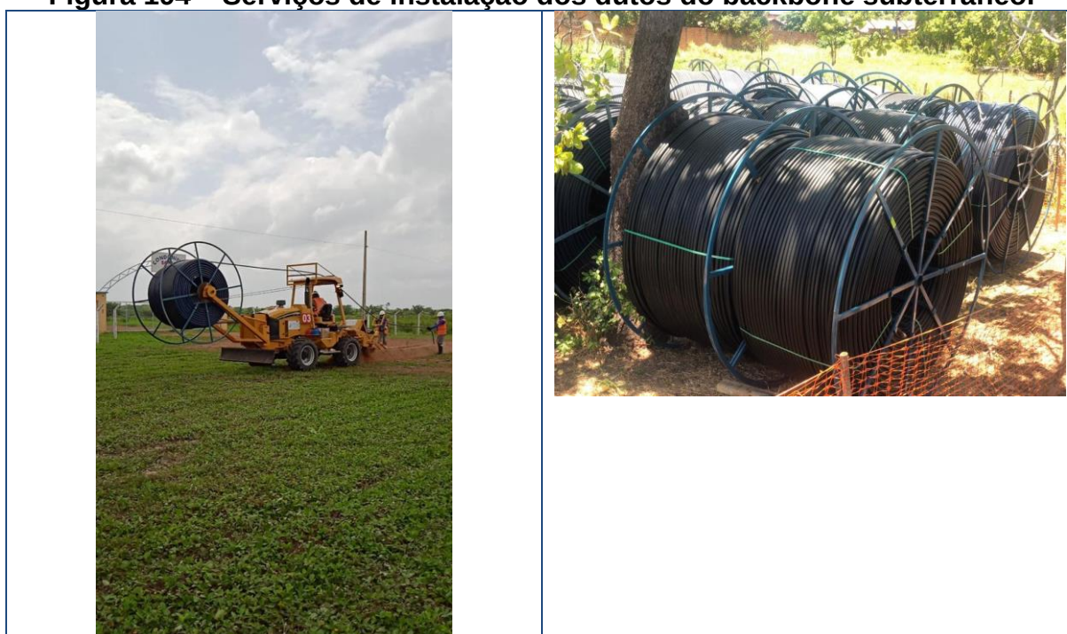
Figura 194 – Serviços de instalação dos dutos do backbone subterrâneo.
