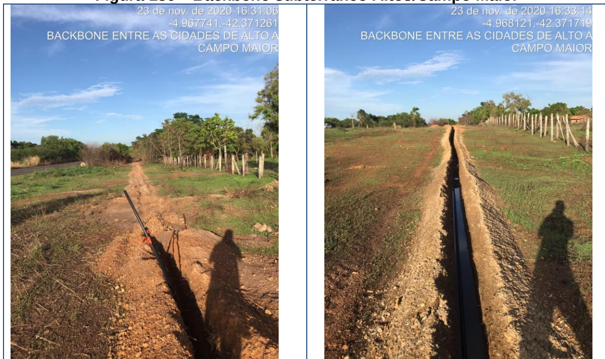
Figura 186 – Backbone subterrâneo Altos/Campo Maior
