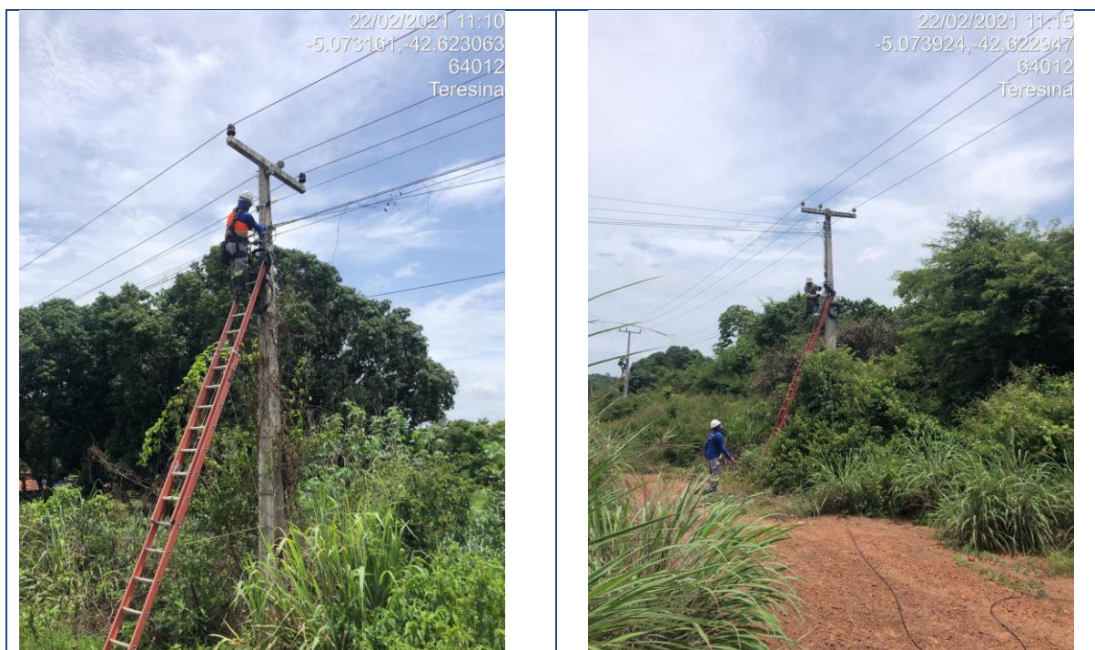
Figura 181 – Lançamento de Backbone aéreo trecho Teresina/Rodoanel
