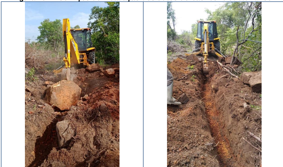
Figura 191 – Serviços de instalação dos dutos do backbone subterrâneo.
