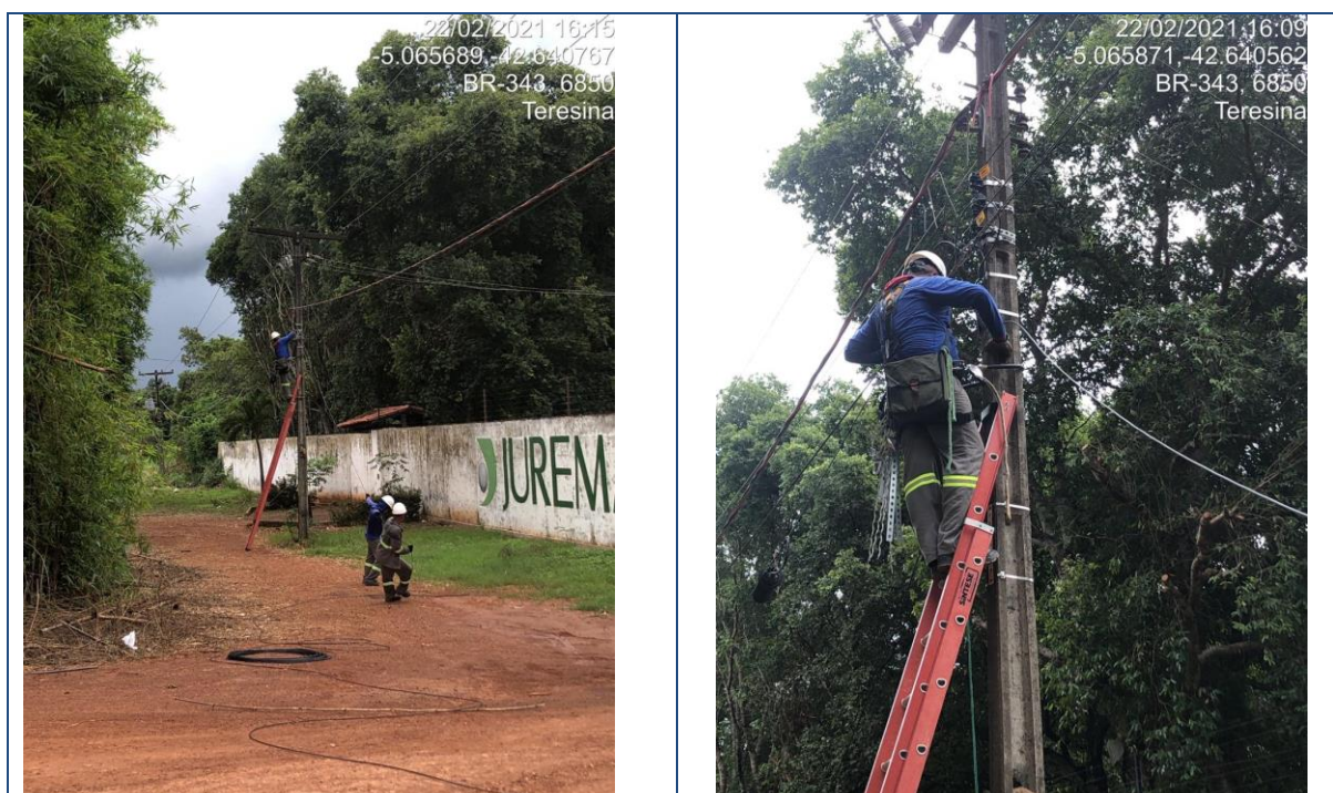
Figura 184 - Lançamento de Backbone aéreo trecho Teresina/Rodoanel
