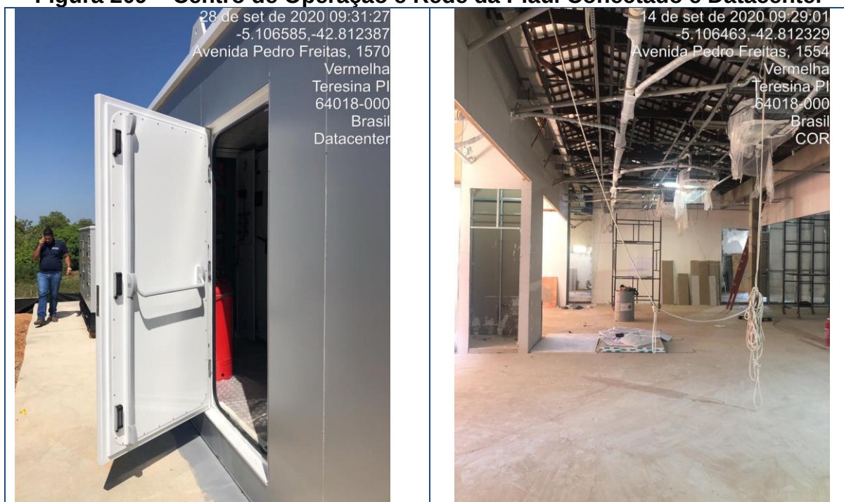
Figura 209 – Centro de Operação e Rede da Piauí Conectado e Datacenter
