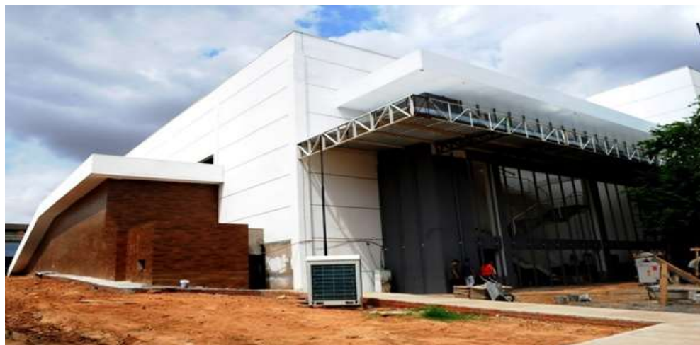
Figura 4 Centro de Convenções - Área de Urbanização - 09/01/2018
