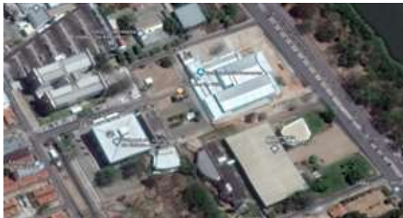
Figura03 - Vista Aérea do Centro de Convenções de Teresina.
