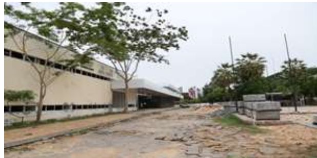
Figura 04 - Situação Atual da Área do Estacionamento Externo.
