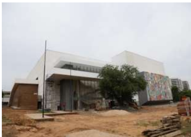
Figura 02 - Situação Faixada do Imóvel
