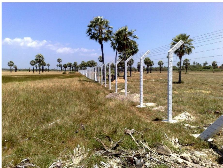
**Figura 5. Cerca com estacas de concreto**
