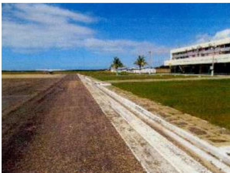
**Figura 12. Vala de drenagem junto ao estacionamento de aeronaves**
