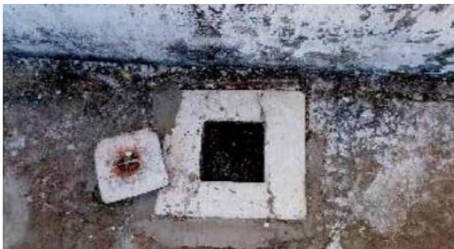
**Figura 11. Caixa de inspeção de fossa séptica.**
