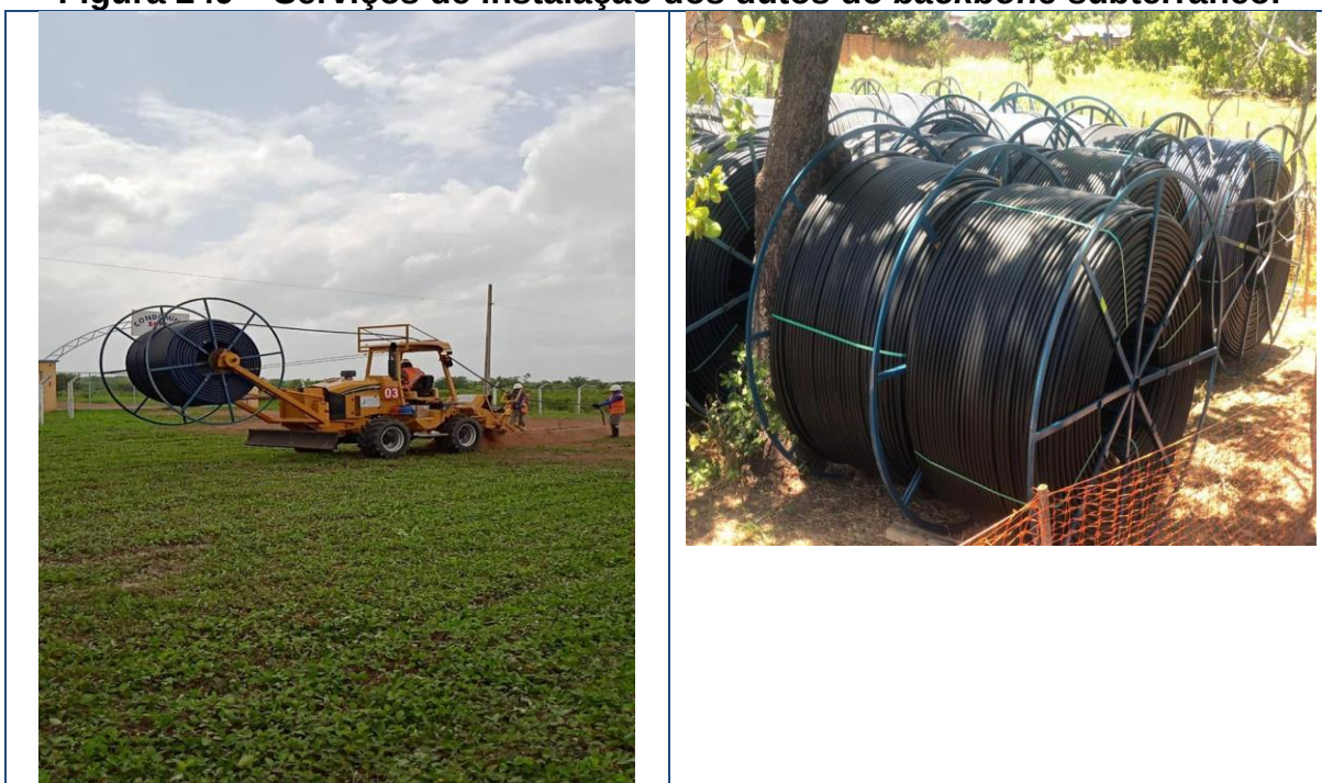
Figura 249 – Serviços de instalação dos dutos do backbone subterrâneo.
