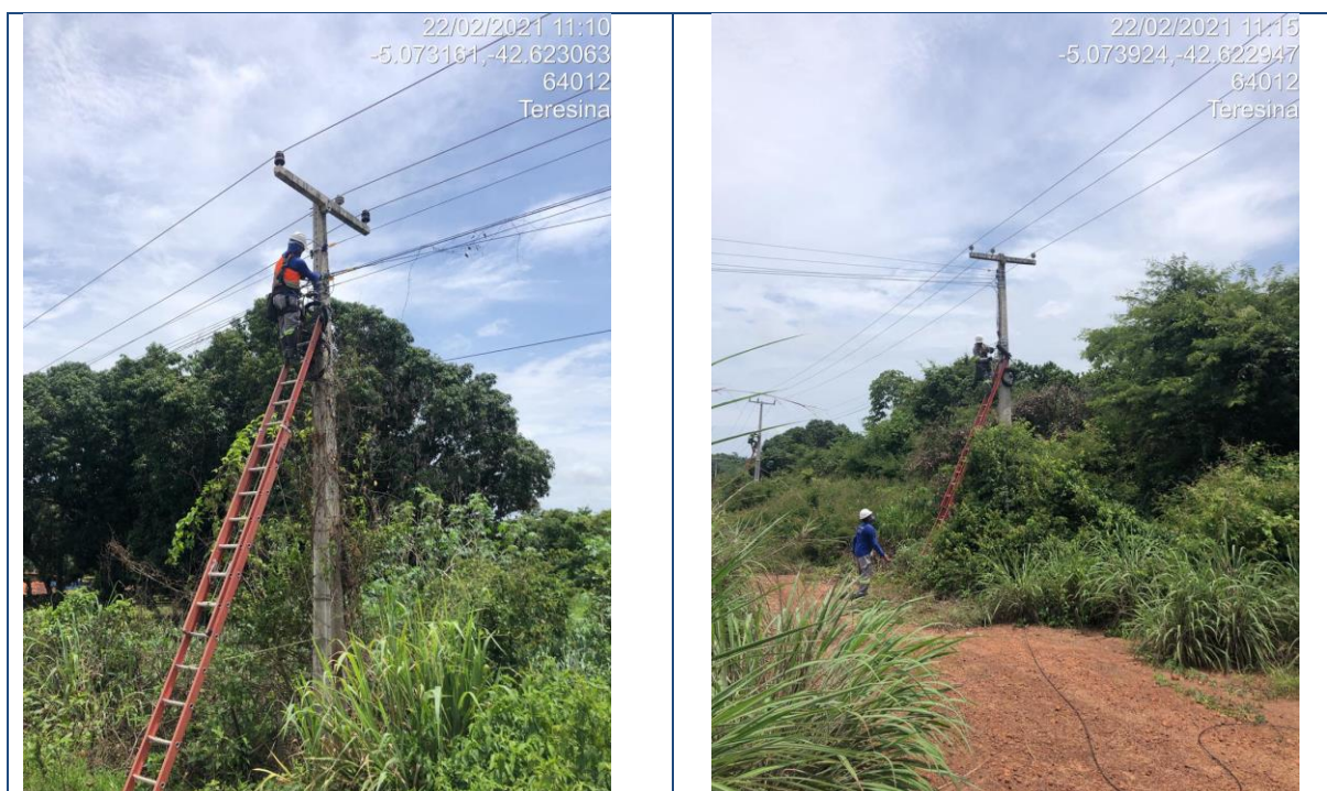
Figura 236 – Lançamento de Backbone aéreo trecho Teresina/Rodoanel
