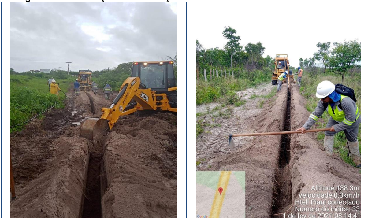
Figura 248 – Serviços de instalação dos dutos do backbone subterrâneo.
