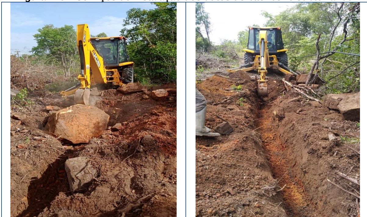
Figura 246 – Serviços de instalação dos dutos do backbone subterrâneo.
