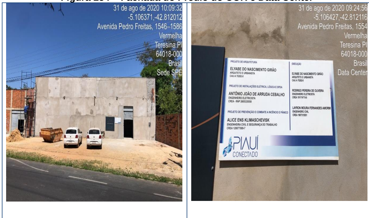
Figura 254 – Fachada do Prédio do COR e Data Center
