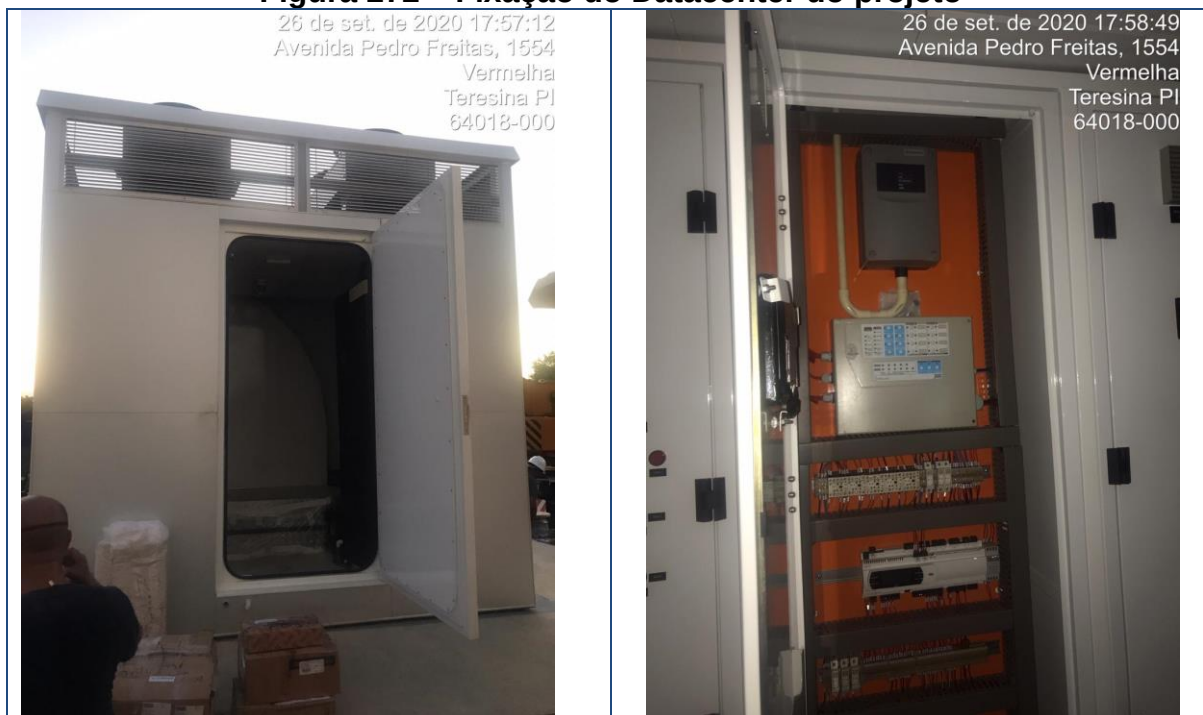
Figura 272 – Fixação do Datacenter do projeto
