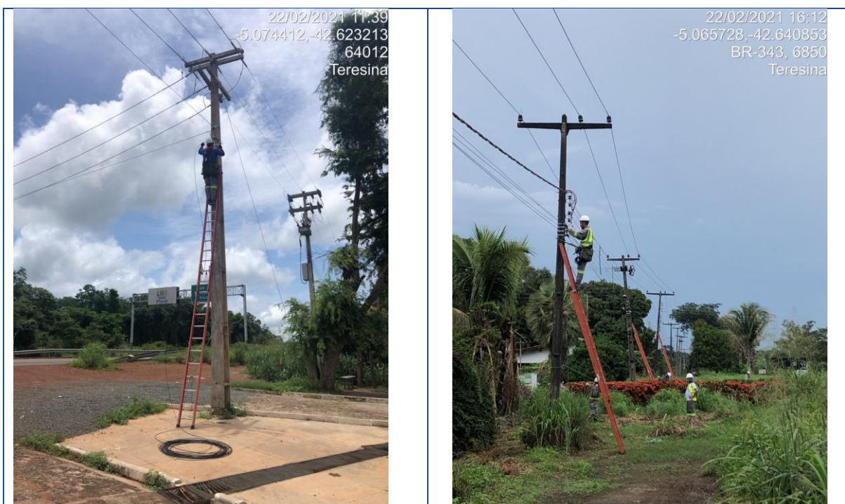
Figura 240 - Lançamento de Backbone aéreo trecho Teresina/Rodoanel
