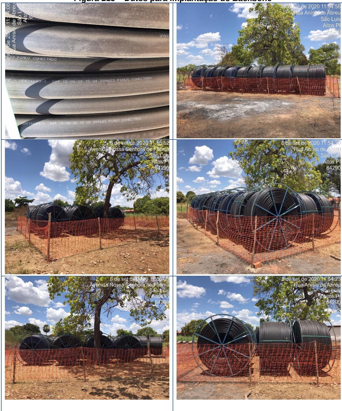
Figura 215 – Dutos para implantação do Backbone
