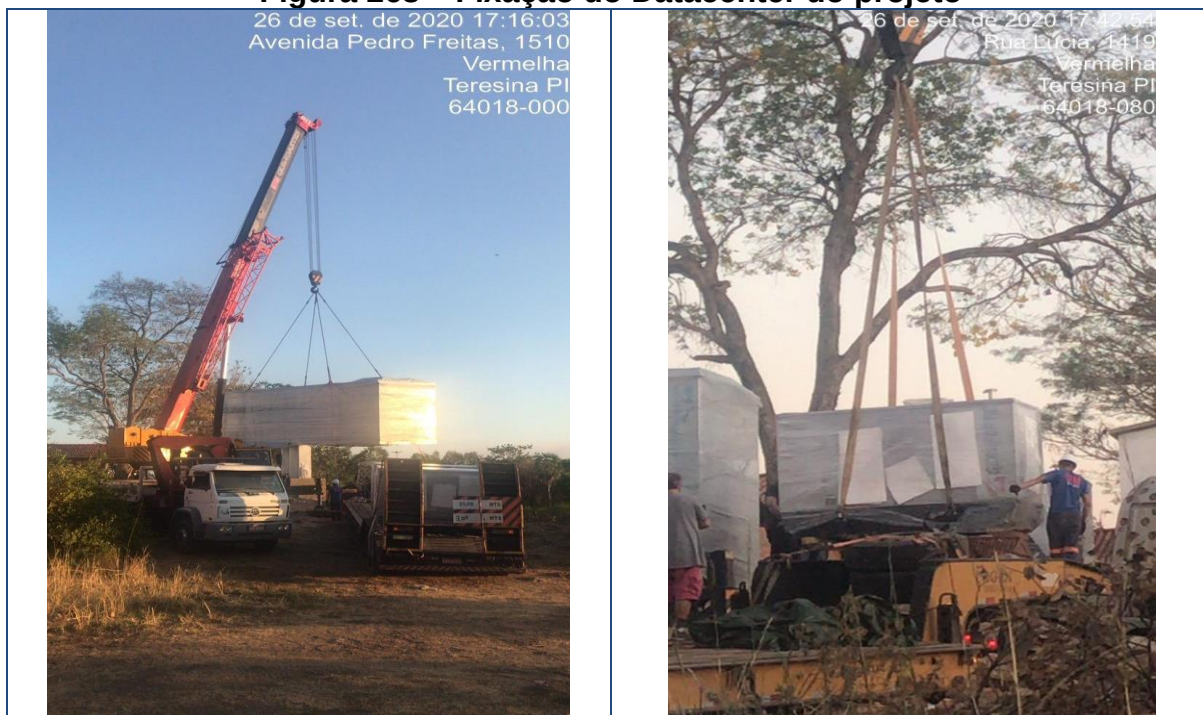
Figura 268 – Fixação do Datacenter do projeto
