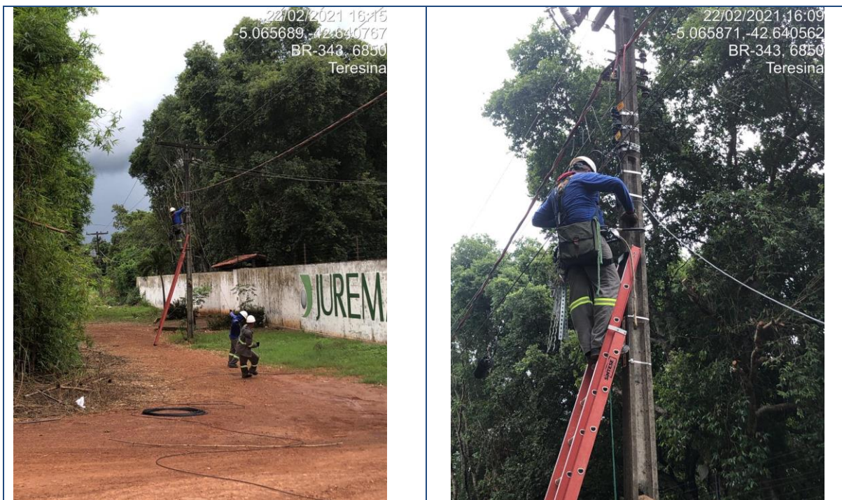
Figura 239 - Lançamento de Backbone aéreo trecho Teresina/Rodoanel
