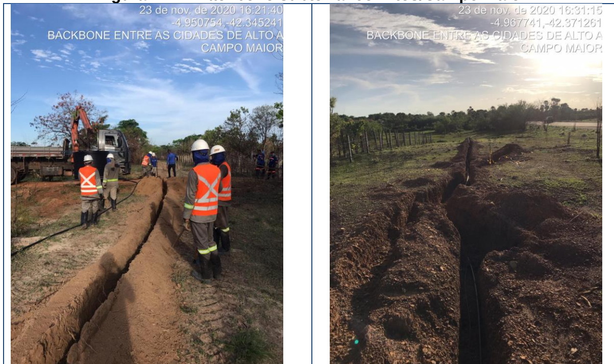
Figura 242 – Backbone subterrâneo Altos/Campo Maior
