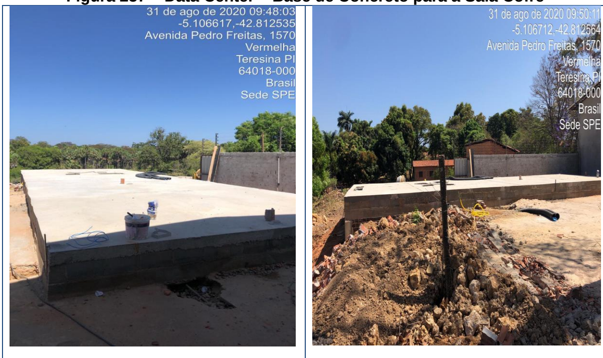
Figura 257 – Data Center – Base de Concreto para a Sala Cofre
