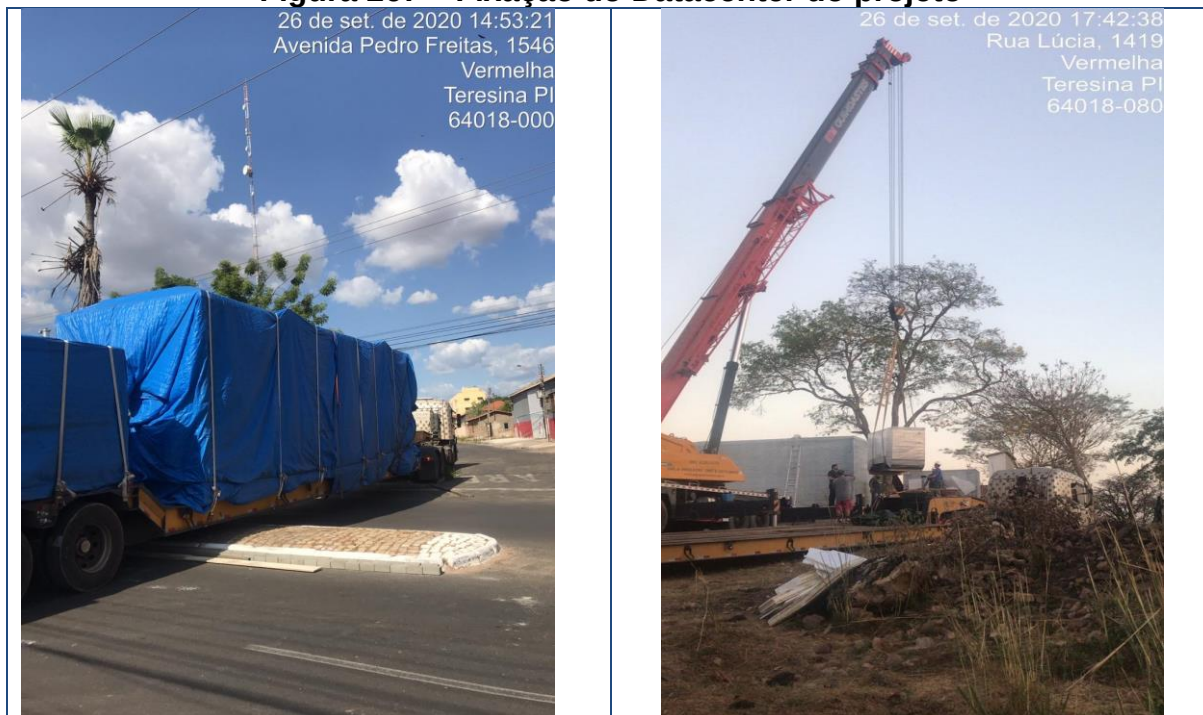
Figura 267 – Fixação do Datacenter do projeto
