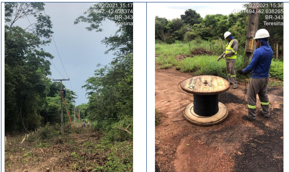
Figura 237 - Lançamento de Backbone aéreo trecho Teresina/Rodoanel
