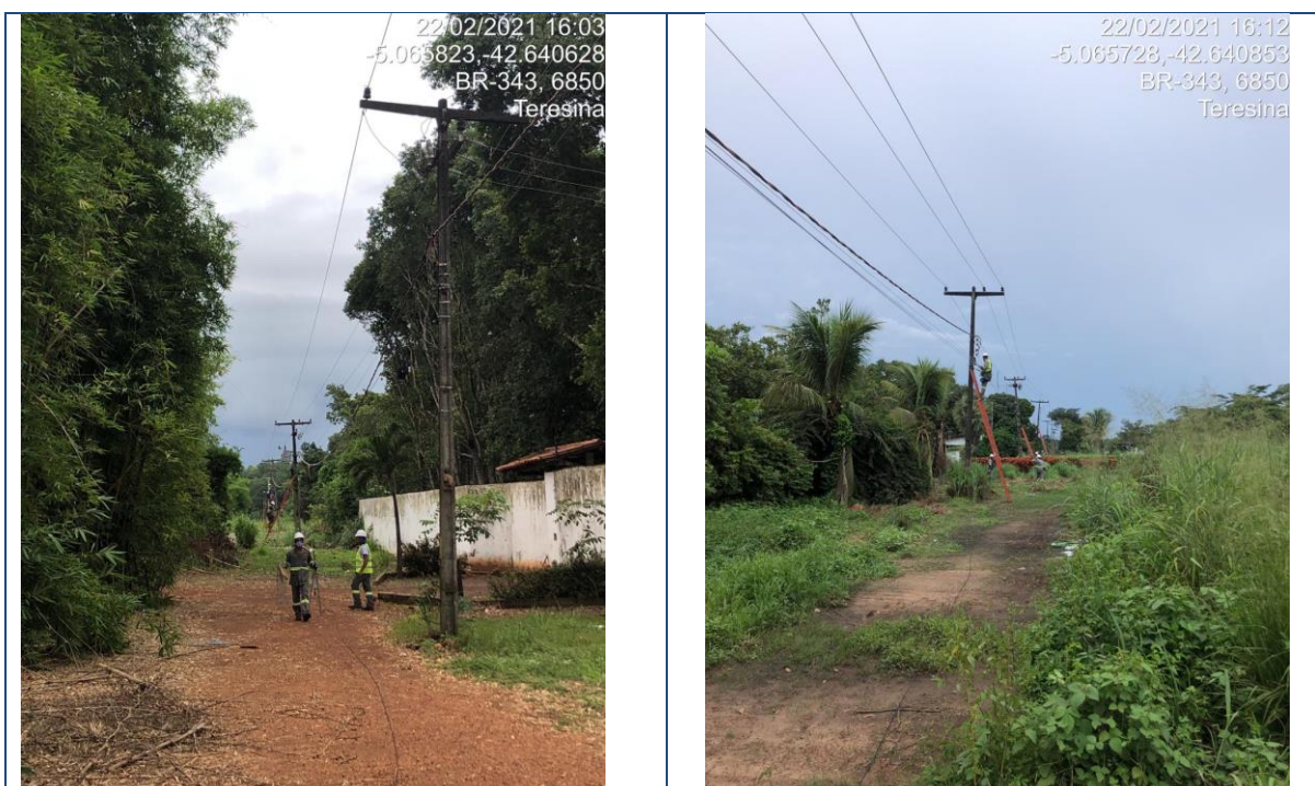
Figura 238 - Lançamento de Backbone aéreo trecho Teresina/Rodoanel
