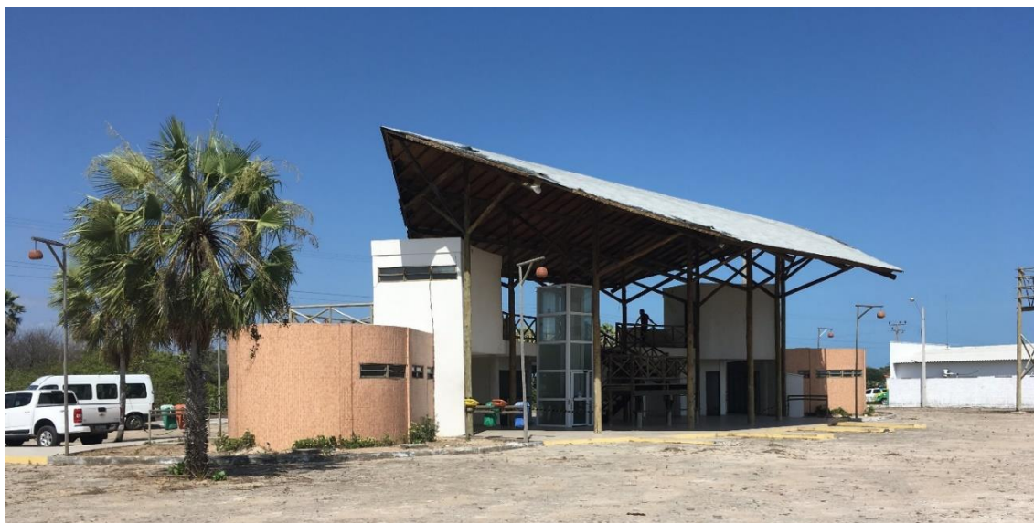
Figura 6 - Vista da edificação principal
