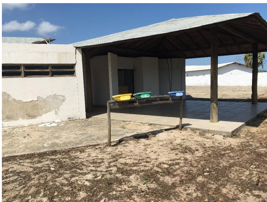
Figura 9 - Edificação de apoio aos motoristas
