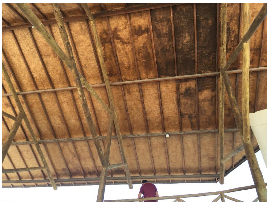
Figura 8 - Telhado da edificação principal
