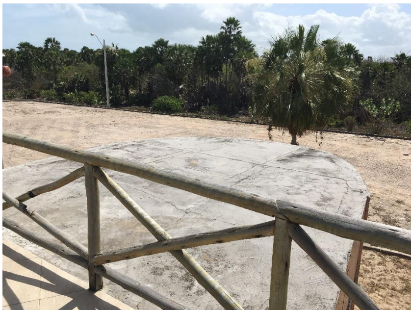
Figura 9 - Laje do banheiro do pavimento térreo
