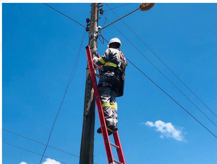
Instalação do backbone aéreo.
