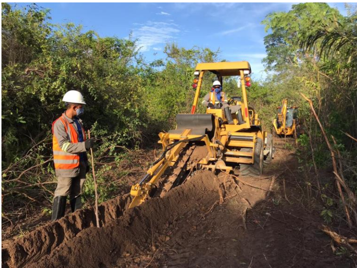
Obras de backbone subterrâneo – trecho Teresina a Altos.
