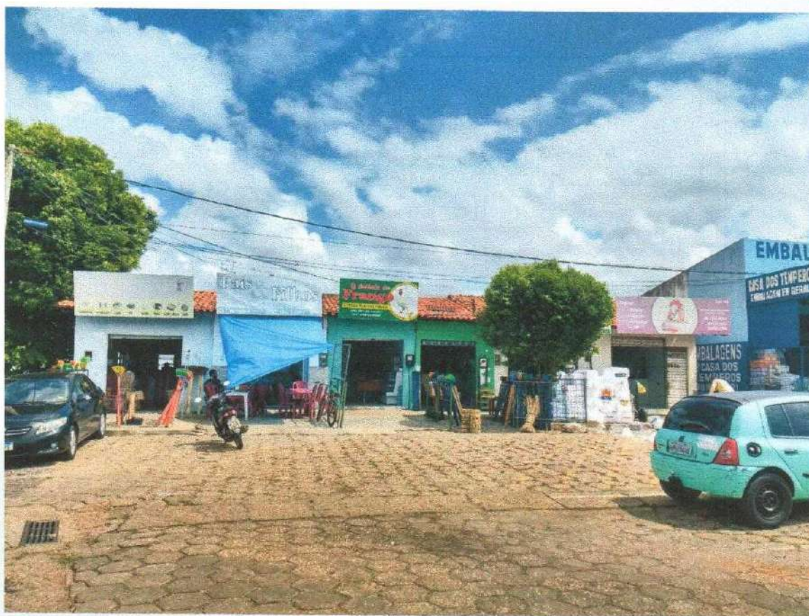
Figura 10 Cobertura PP1 - Superior - Antes da revitalização
