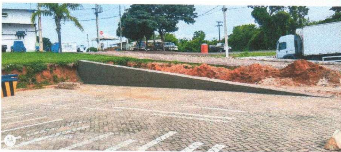
Figura 4 Muro de arrimo - Concluído
