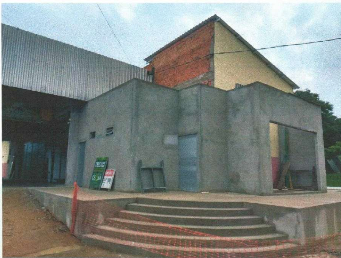
Figura 7 Banheiros PP1/Bananas - Processo construtivo
