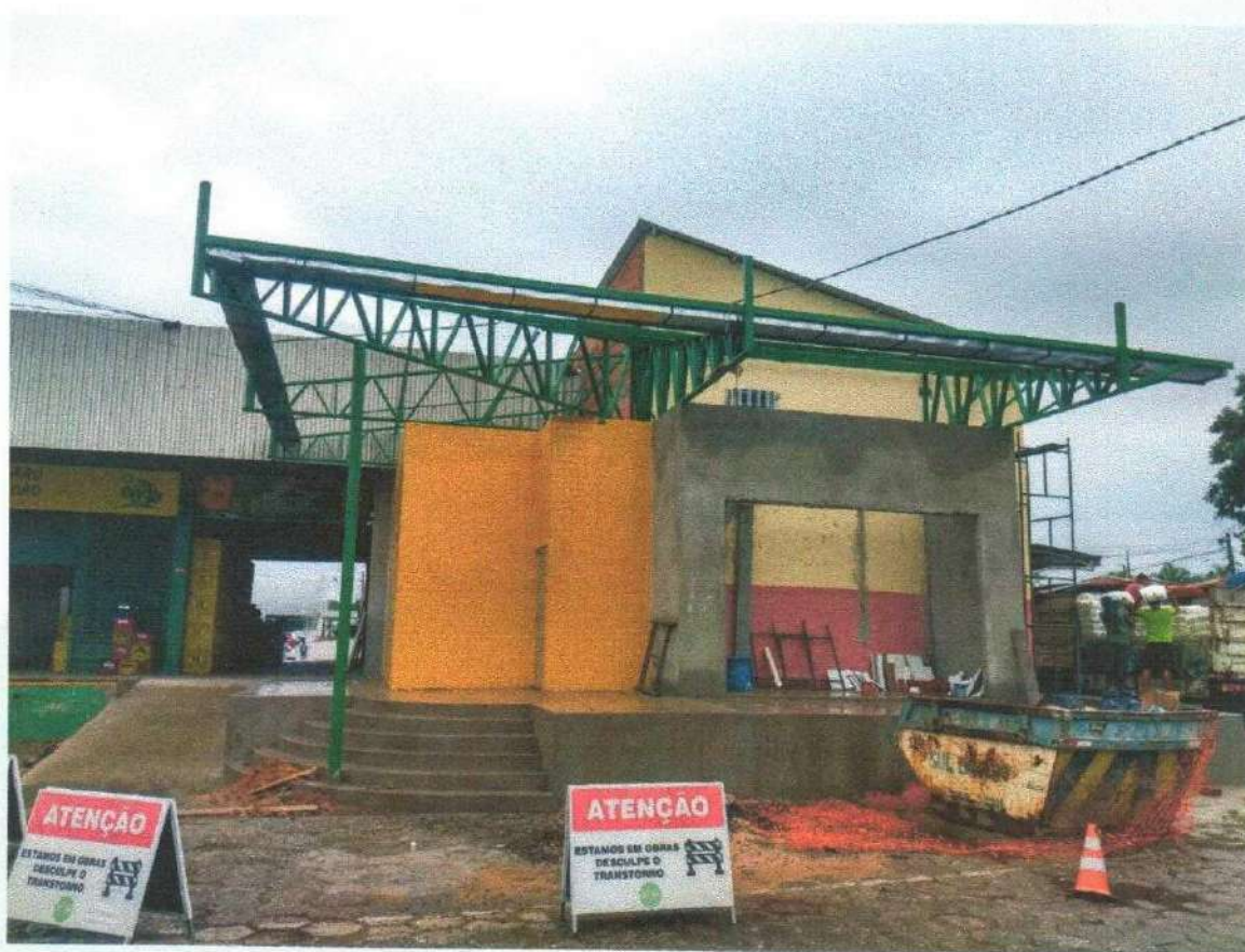
Figura 1 Cobertura PP1/Bananas - Processo construtivo
