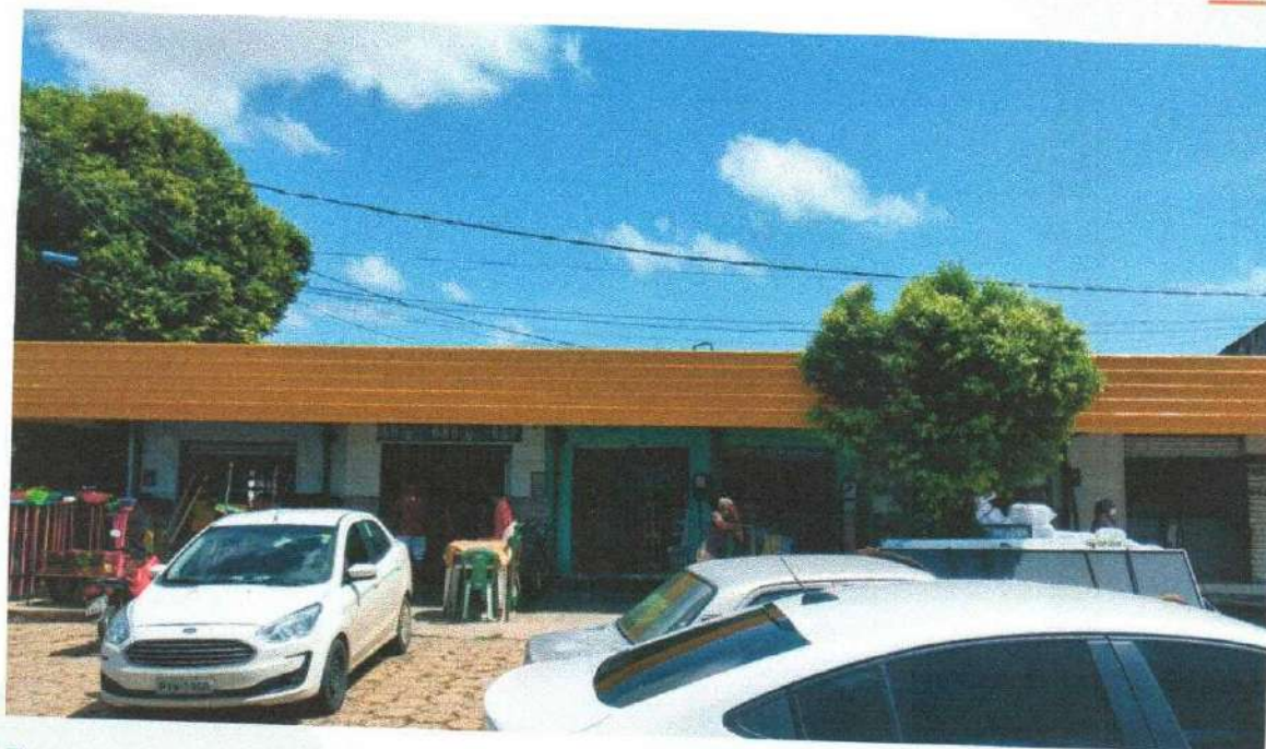
Figura 11 Cobertura PP1 - Superior – Concluído
