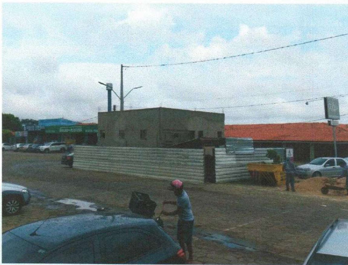
Figura 5 Banheiros Praça de alimentação - Processo construtivo
