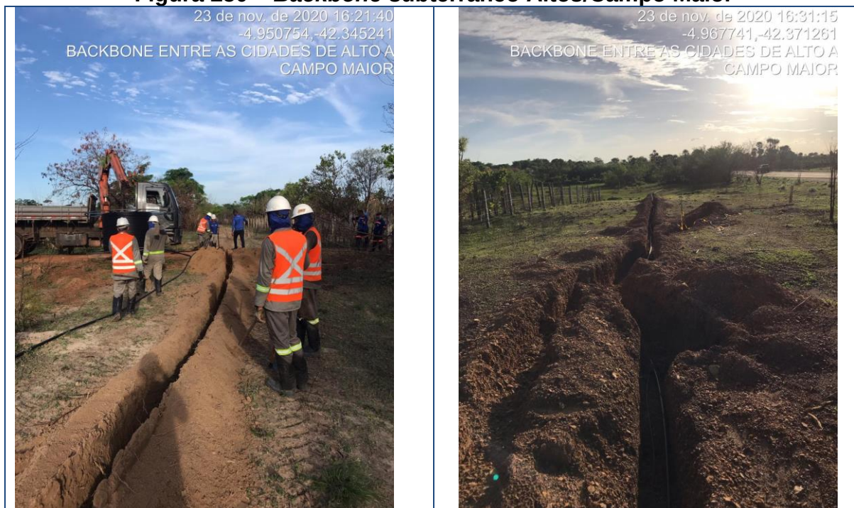
Figura 250 – Backbone subterrâneo Altos/Campo Maior
