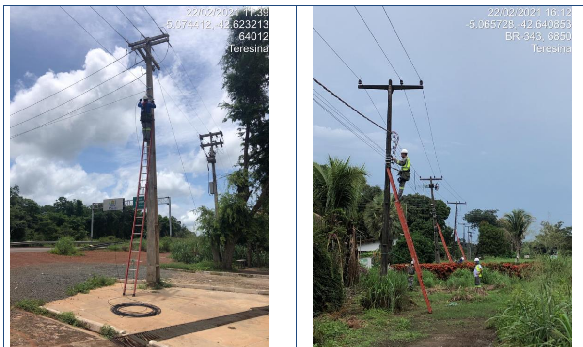
Figura 248 - Lançamento de Backbone aéreo trecho Teresina/Rodoanel
