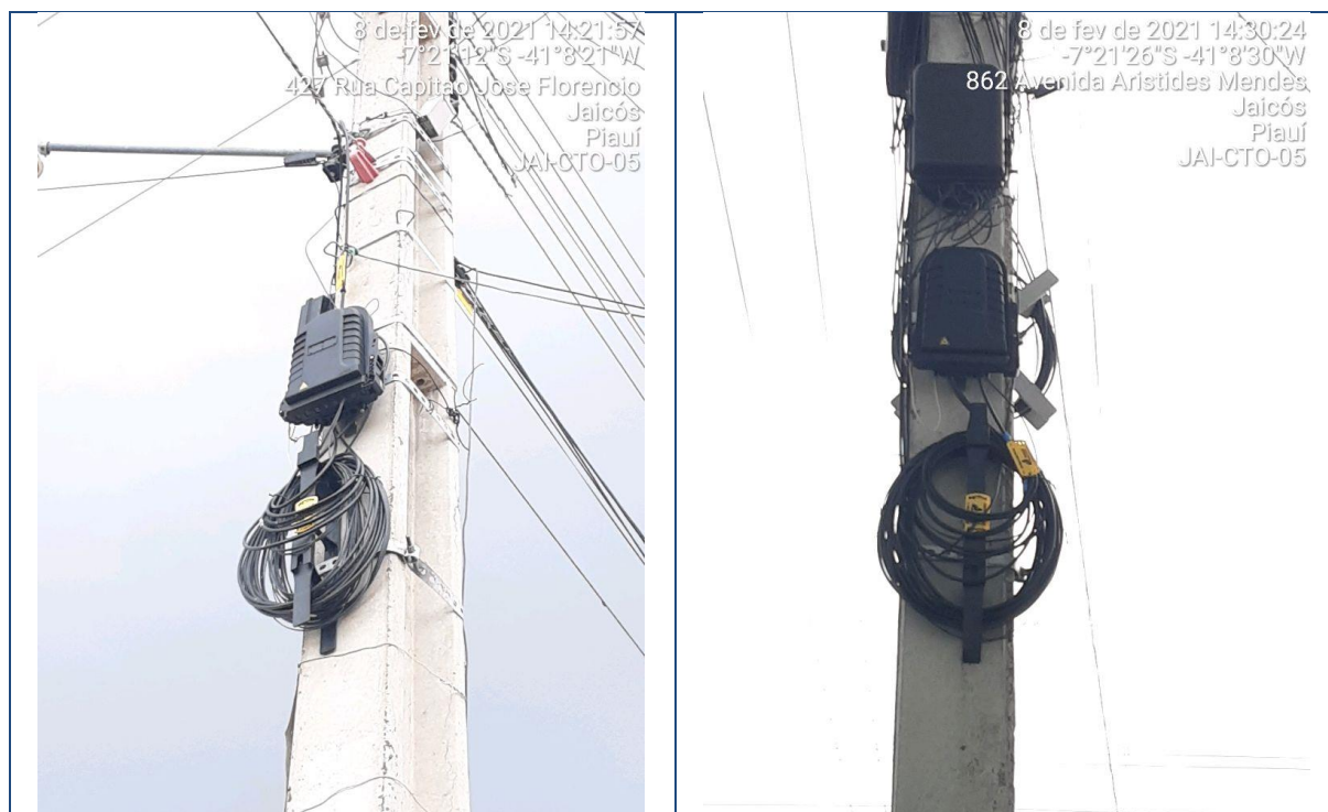
Figura 111 – JAI-CTO-05 – Reserva Técnica aplicada incorretamente – Jaicós
