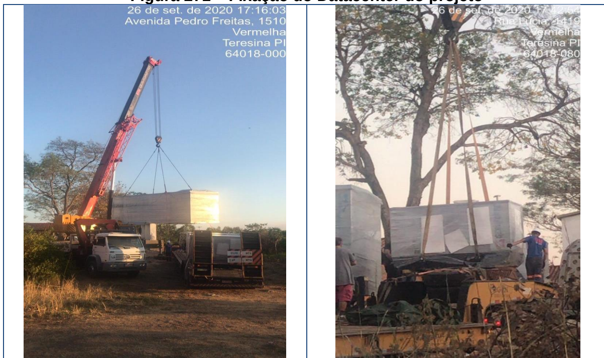
Figura 271 – Fixação do Datacenter do projeto
