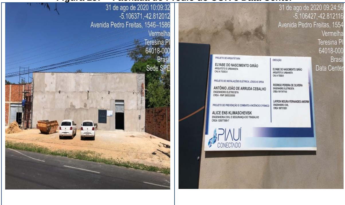
Figura 257 – Fachada do Prédio do COR e Data Center
