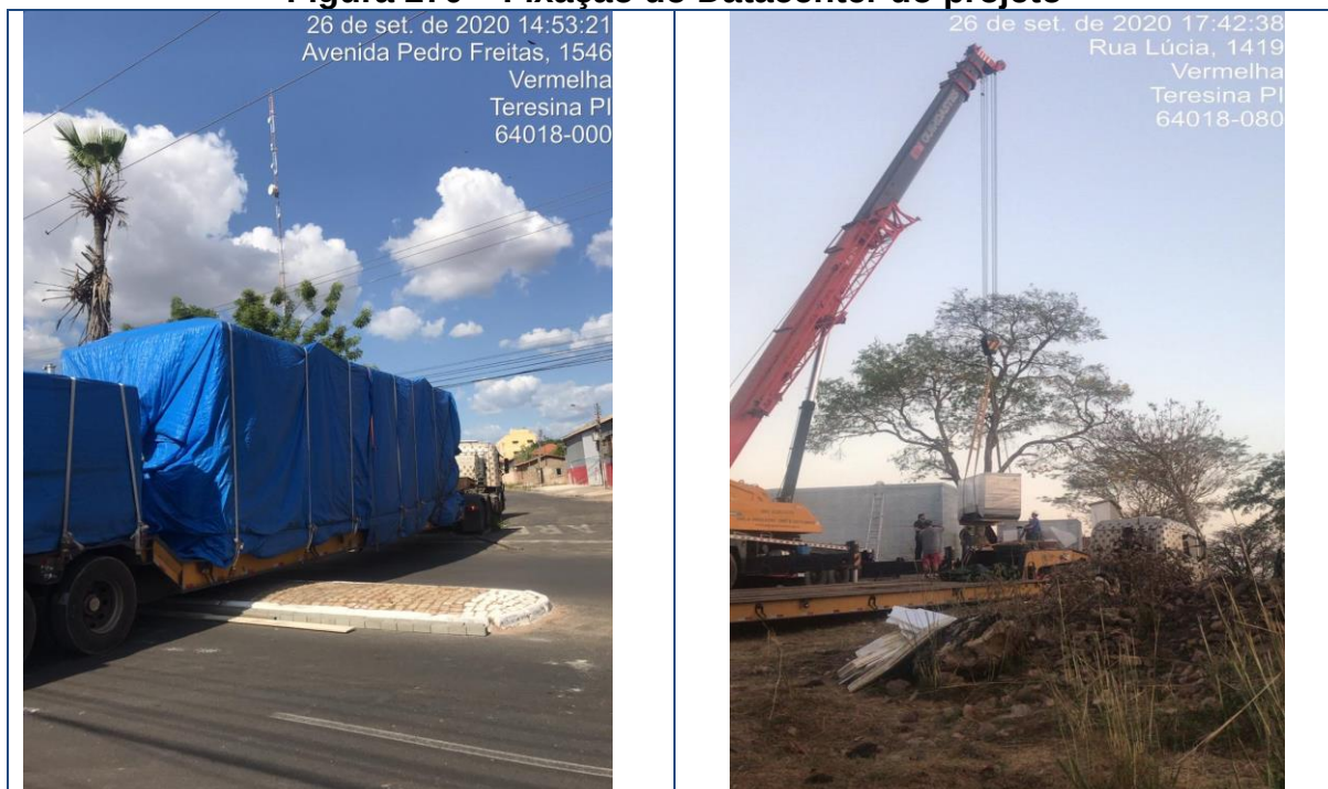
Figura 270 – Fixação do Datacenter do projeto
