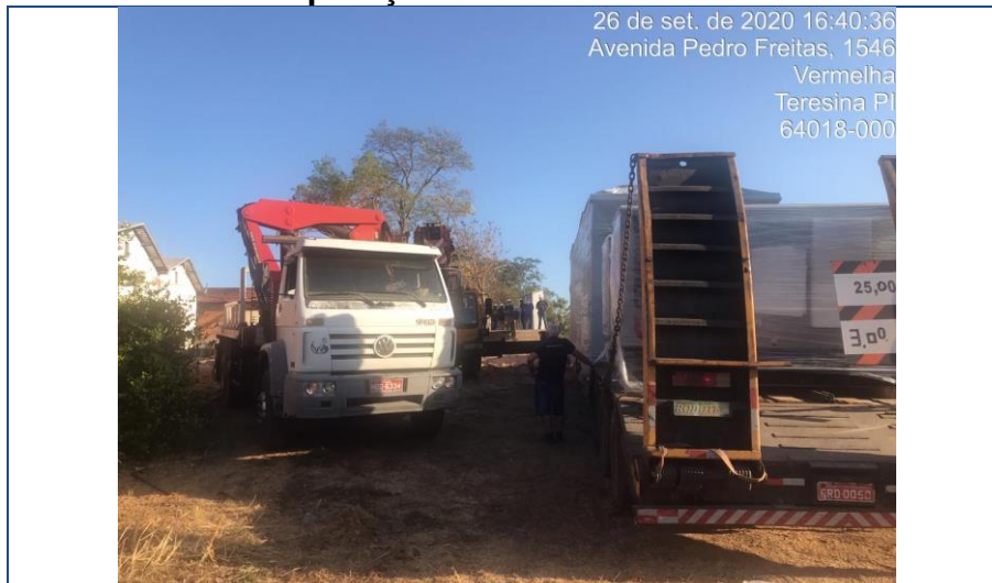
Figura 276 – Centro de Operação e Rede da Piauí Conectado e Datacenter
