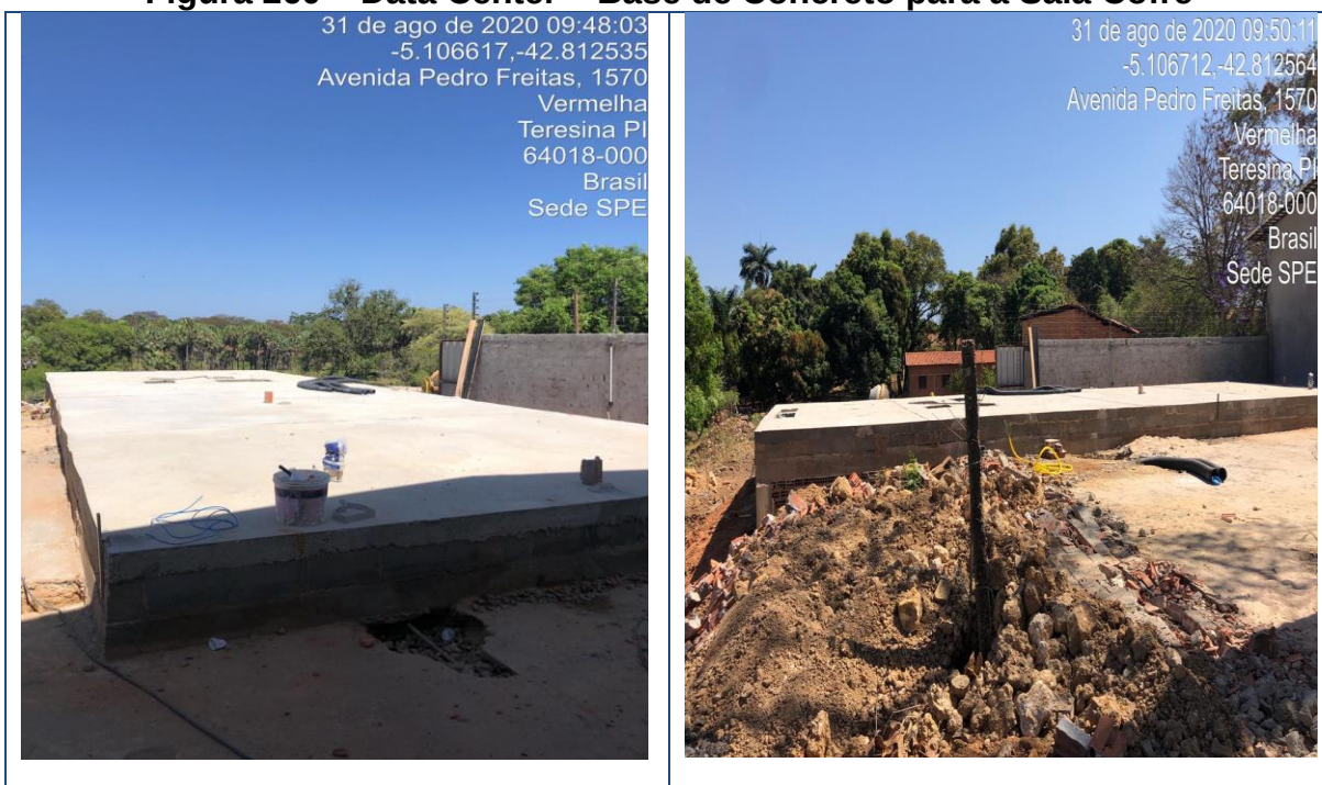
Figura 260 – Data Center – Base de Concreto para a Sala Cofre
