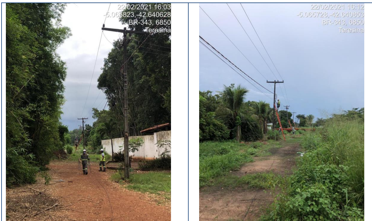
Figura 246 - Lançamento de Backbone aéreo trecho Teresina/Rodoanel
