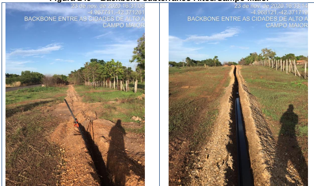
Figura 249 – Backbone subterrâneo Altos/Campo Maior
