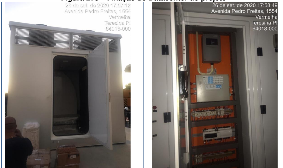
Figura 275 – Fixação do Datacenter do projeto
