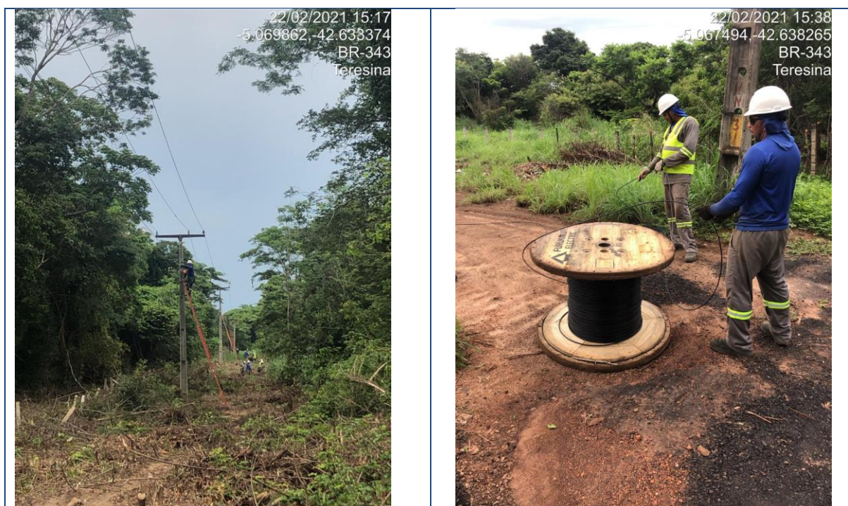
Figura 245 - Lançamento de Backbone aéreo trecho Teresina/Rodoanel
