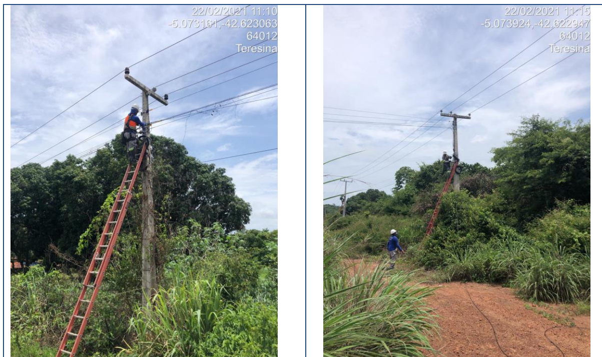
Figura 244 – Lançamento de Backbone aéreo trecho Teresina/Rodoanel
