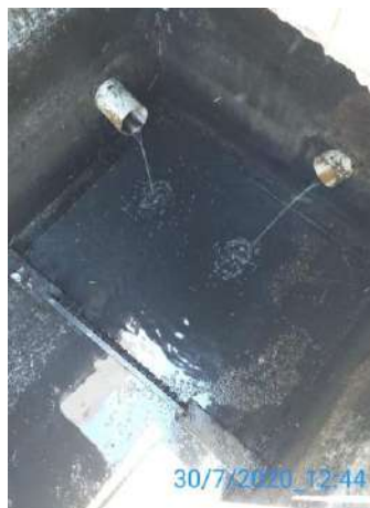
Execução da limpeza caixa de areia
