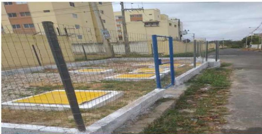
Area do gradeamento e poço
