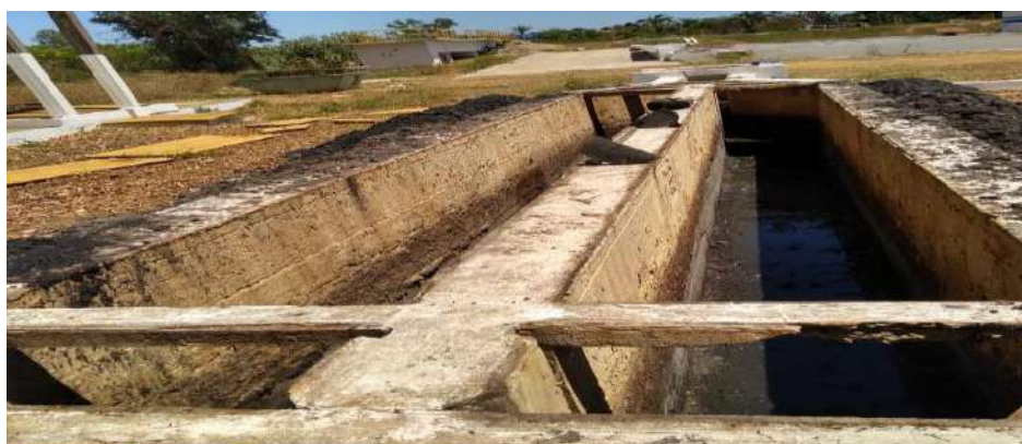
Limpeza da caixa de areia dos caminhões limpa fossa
