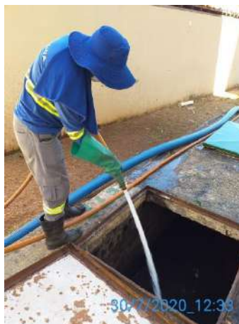
Execução da limpeza caixa de areia
