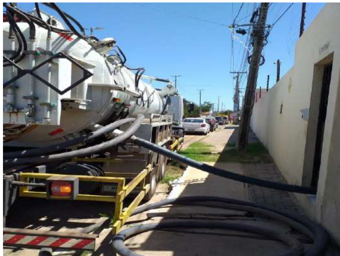
Limpeza ETE Margens do Poti
