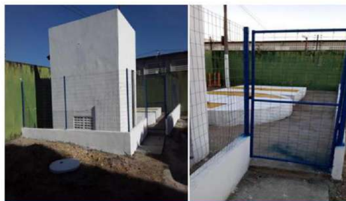
Sala de comando e area pintada
