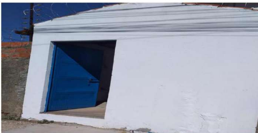
Casa de comando das bmbas
