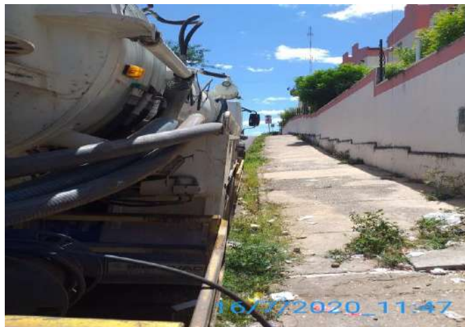
Início da limpeza ETE Bosque Residencial
