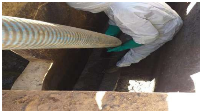
Execução da limpeza caixa de areia
