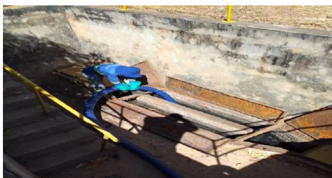
Limpeza da caixa de areia
