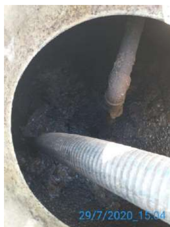
Limpeza dos reatores
