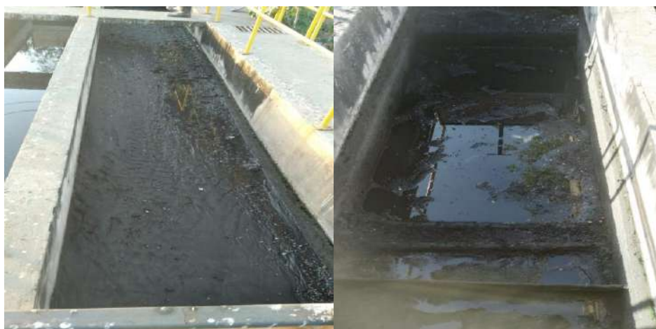
Limpeza realizada com caminhão hidrojato
