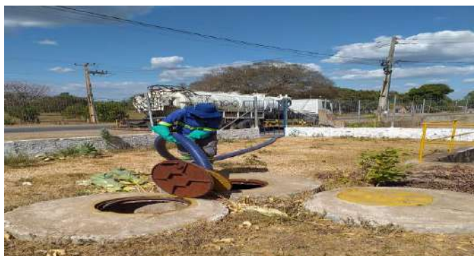
Limpeza dos reatores
