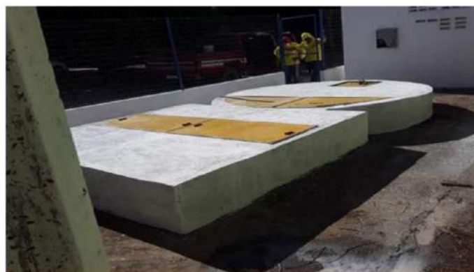
Tampas novas para o poço de sucção
