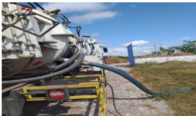
Caminhão de sucção realizando a limpeza da caixa de areia
