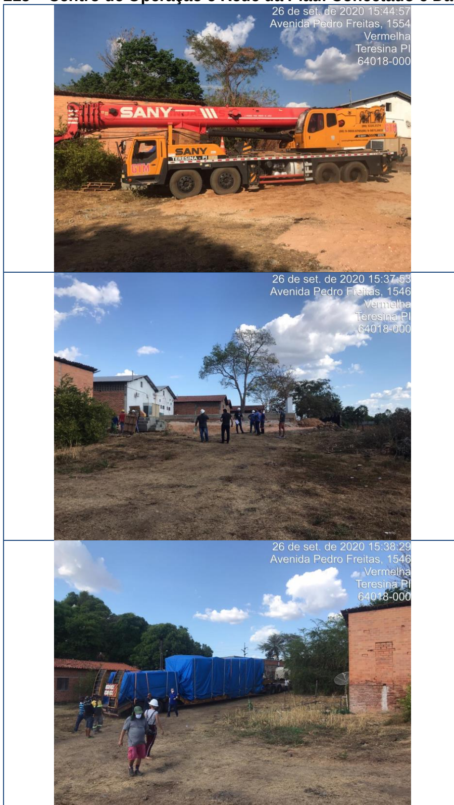
Figura 215 – Centro de Operação e Rede da Piauí Conectado e Datacenter
