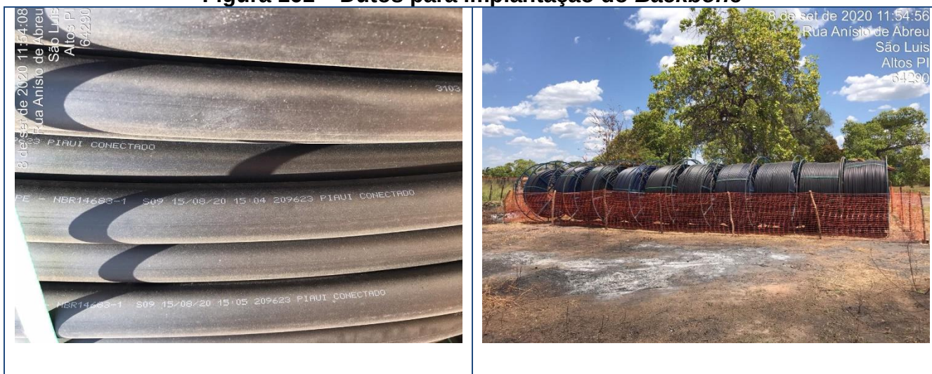
Figura 161 – Dutos para implantação do Backbone
