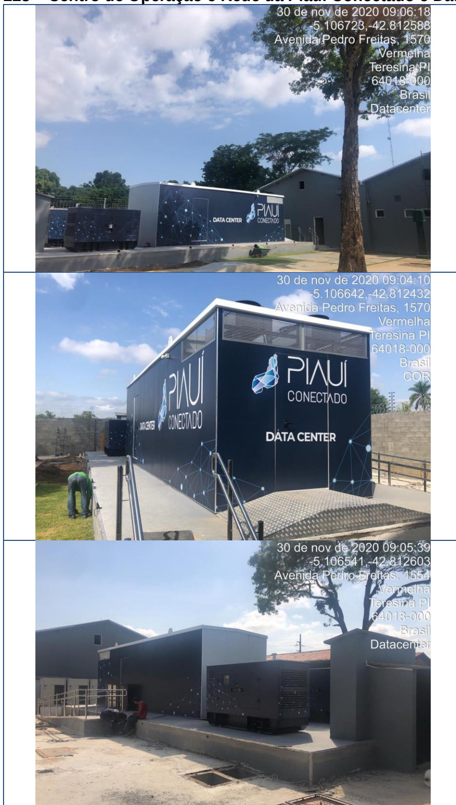
Figura 223 – Centro de Operação e Rede da Piauí Conectado e Datacenter
