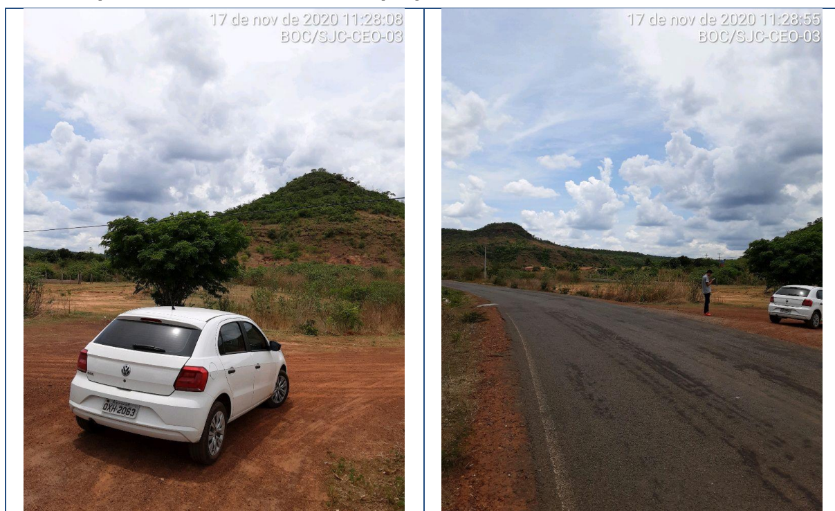
Figura 49 – BOC/SJC-CEO-03 – Lançamento padrão e Altura do lançamento do cabo óptico não conforme com o projeto – Bocaina/São João da Canabrava
