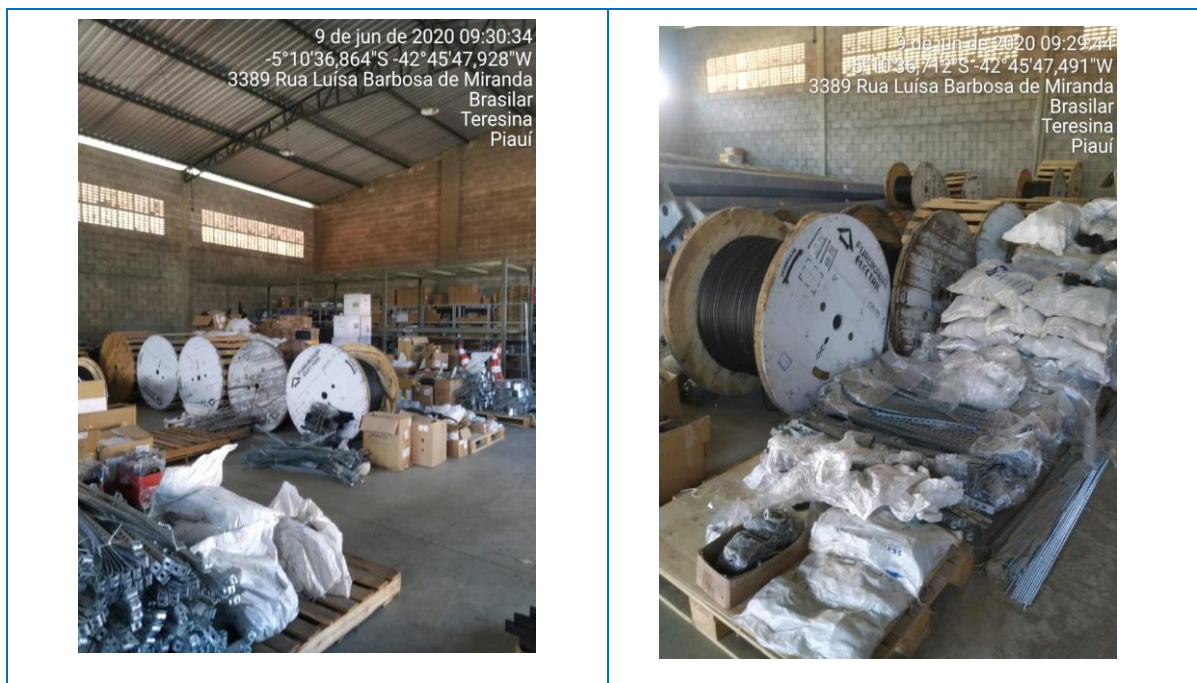
Figura 19 – Bolbina de fibra 12 FO, Dio elétrico e Bapi
