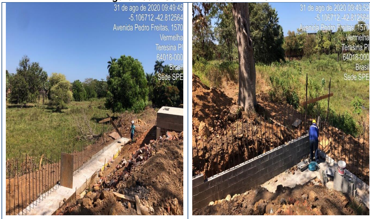
Figura 200 – COR – Muro de Arrimo.
