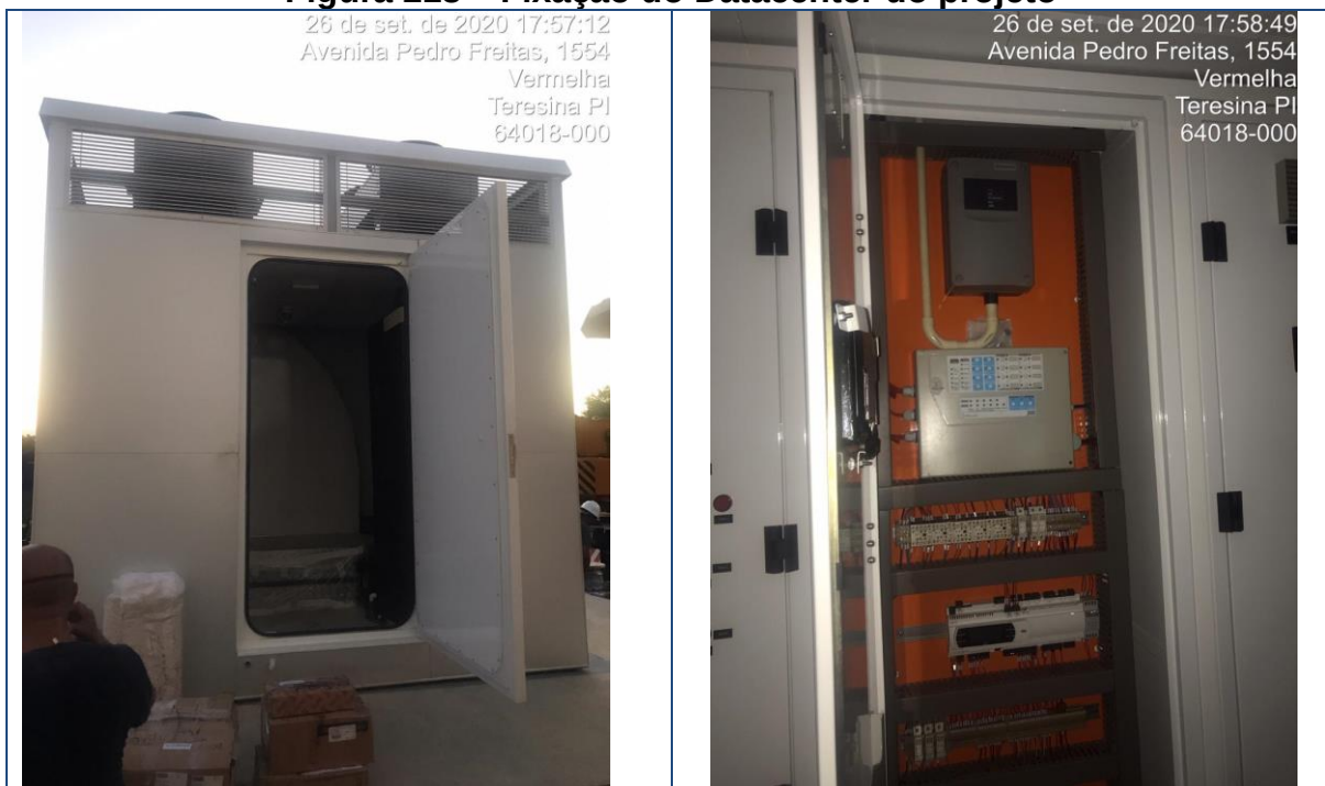
Figura 218 – Fixação do Datacenter do projeto
