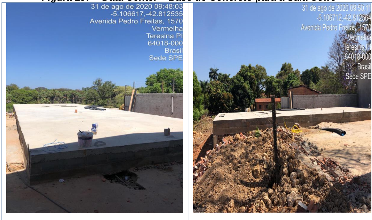
Figura 197 – Data Center – Base de Concreto para a Sala Cofre
