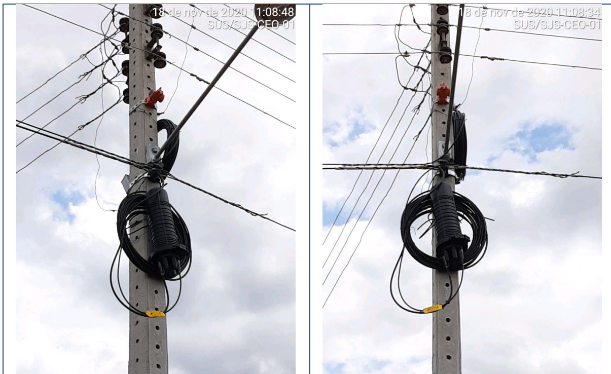
Figura 53 – SUS/SJS-CEO – Reserva técnica não aplicada corretamente – Sussuapara/São José do Piauí
