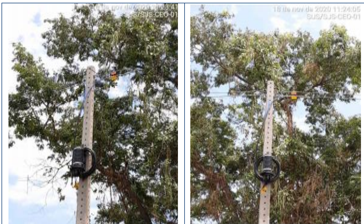
Figura 55 – CGP-PRI-01 – Suporte para fixação para caixa de emenda (CEO e CTO) aplicado não corretamente – Campo Grande do Piauí
