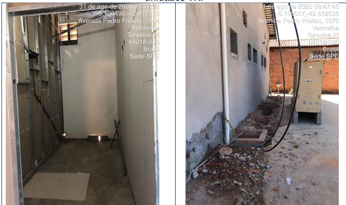
Figura 196 – COR – Sala de Telecomunicações (Rack) e área técnica para unidades VRF
