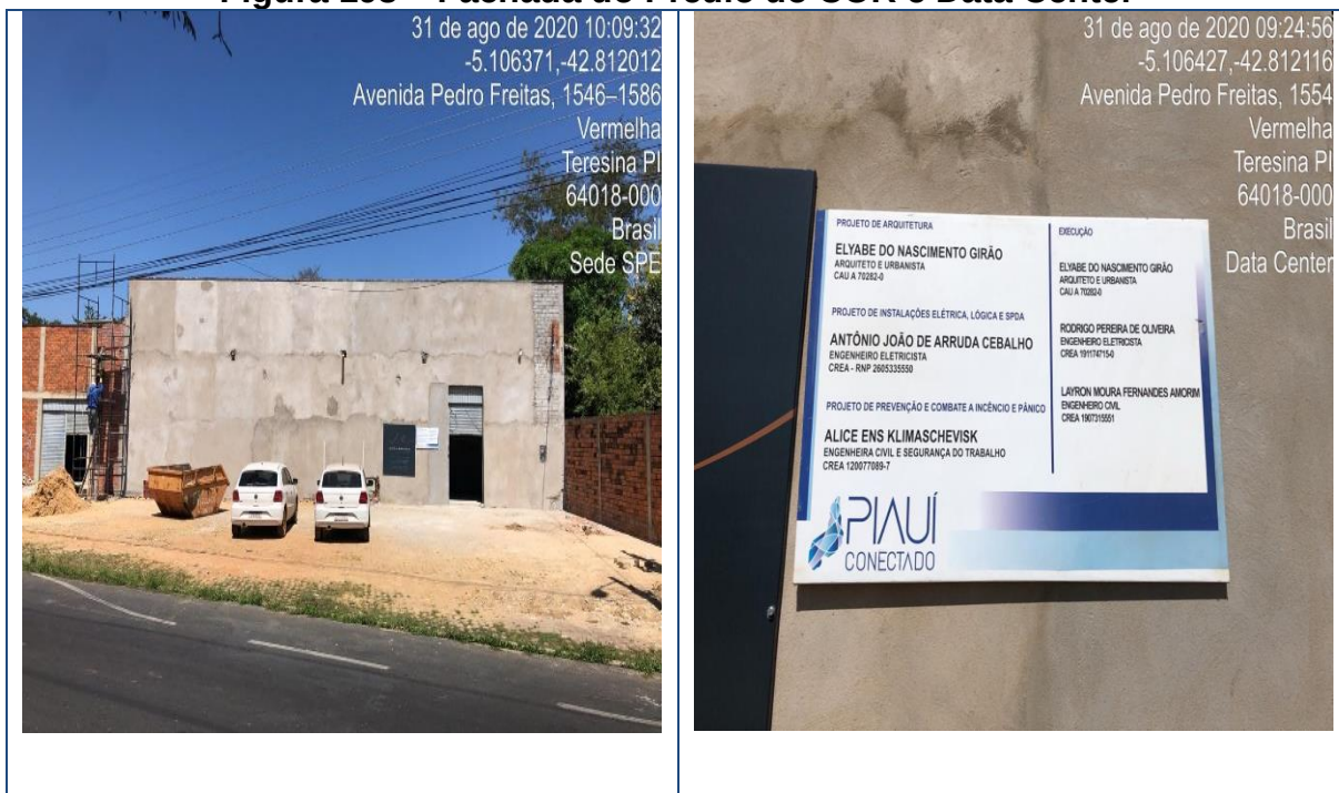
Figura 193 – Fachada do Prédio do COR e Data Center
