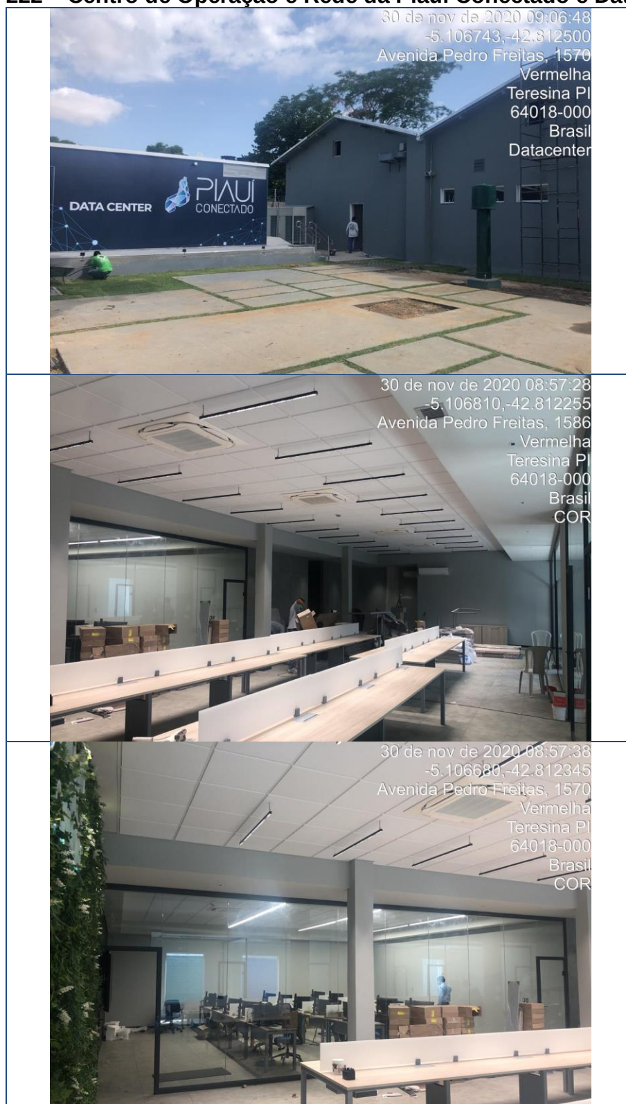
Figura 222 – Centro de Operação e Rede da Piauí Conectado e Datacenter
