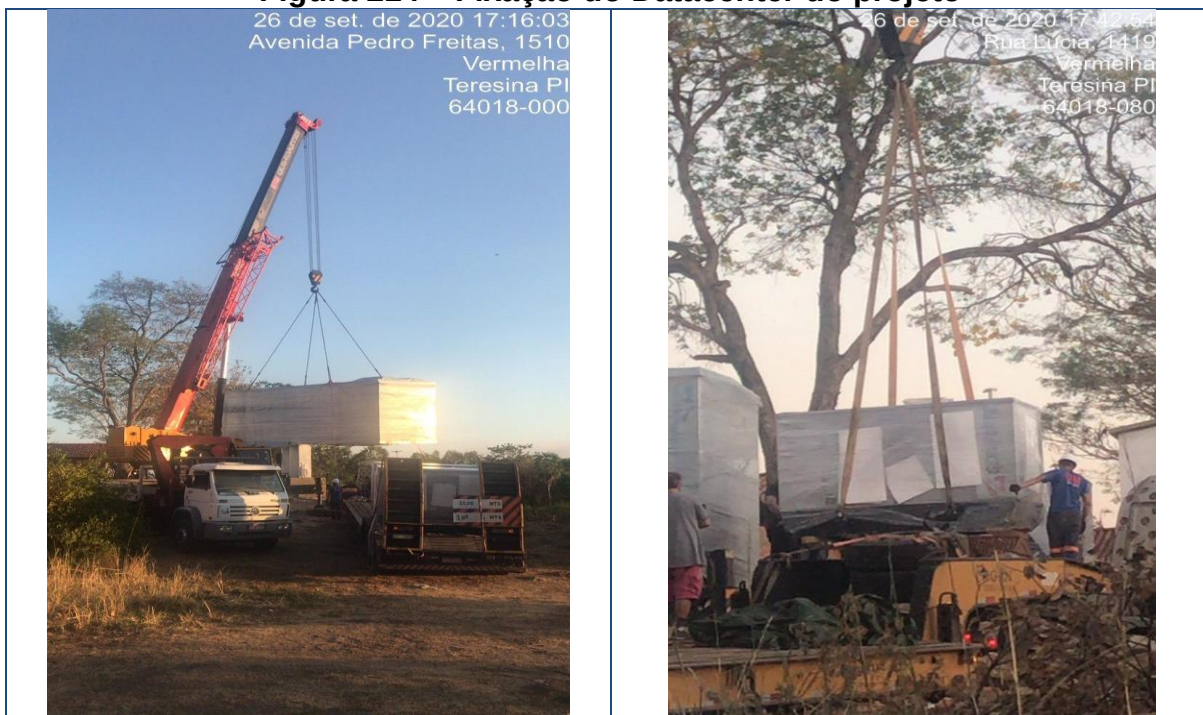
Figura 214 – Fixação do Datacenter do projeto
