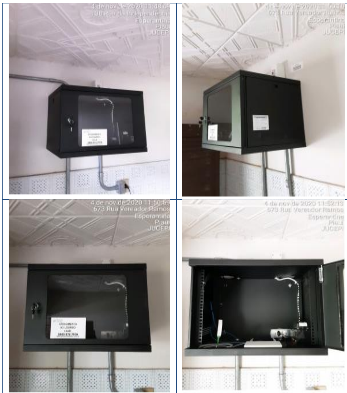
Figura 115 – PAG JUCEPI: NÃO CONFORME – Ausência de adesivo com identificação do rack – ESPERANTINA
