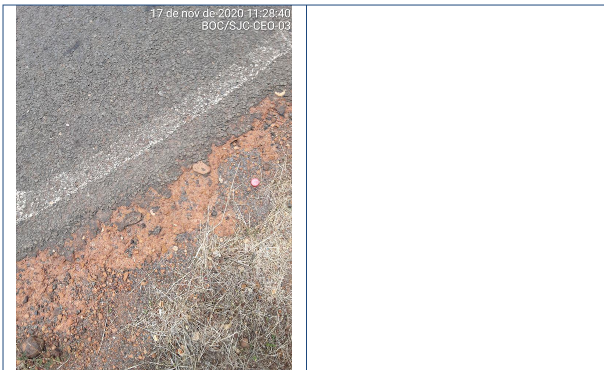
Figura 50 – BOC-CEO-01 – Reserva técnica aplicada não corretamente– Bocaina
