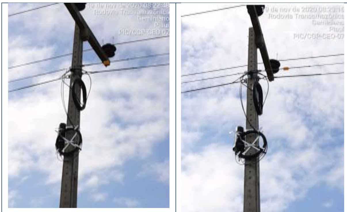
Figura 56 – PIC/CGP-CEO-07– Placa de identificação do cabo lançado não conforme – PICOS/CAMPO GRANDE DO PIAUÍ
