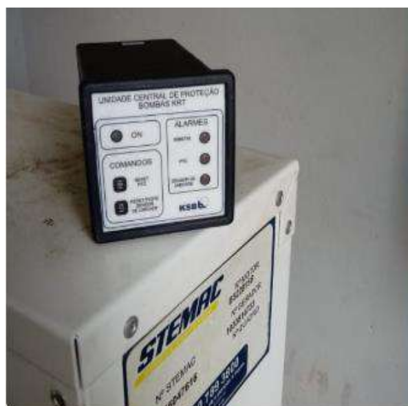
Instalação da unidade de proteção do CMB da EEE Santa Marta.
