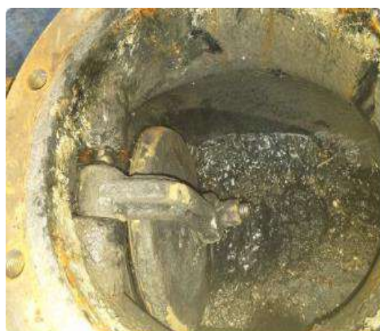
Manutenção da válvulas de retenção da CMB 02 da EEE Jose compasses já concluída
