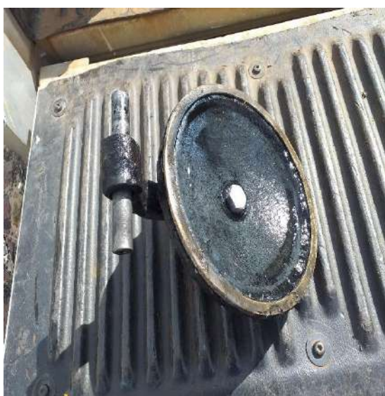
Recomperado o batedor da válvulas de retenção da CMB 02da EEE Jose compasses na telemec
