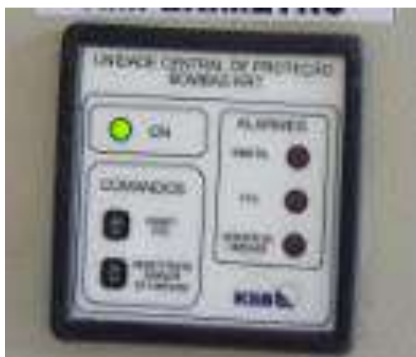
Instalação da unidade de proteção do CMB da EEE Santa Marta.
