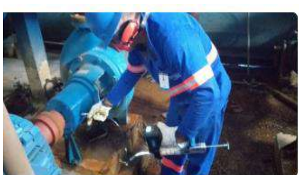
Realizado a lubrificação dos cmb do RN 1
