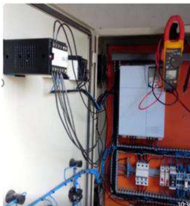
Instalação da unidade de proteção do CMB da EEE Santa Marta.
