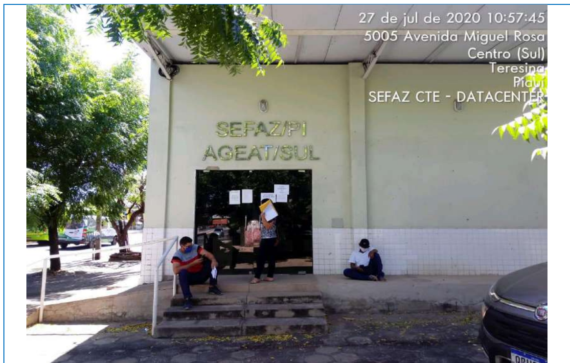
Figura 36 – PAG SEFAZ CTE (DATACENTER) - Teresina
