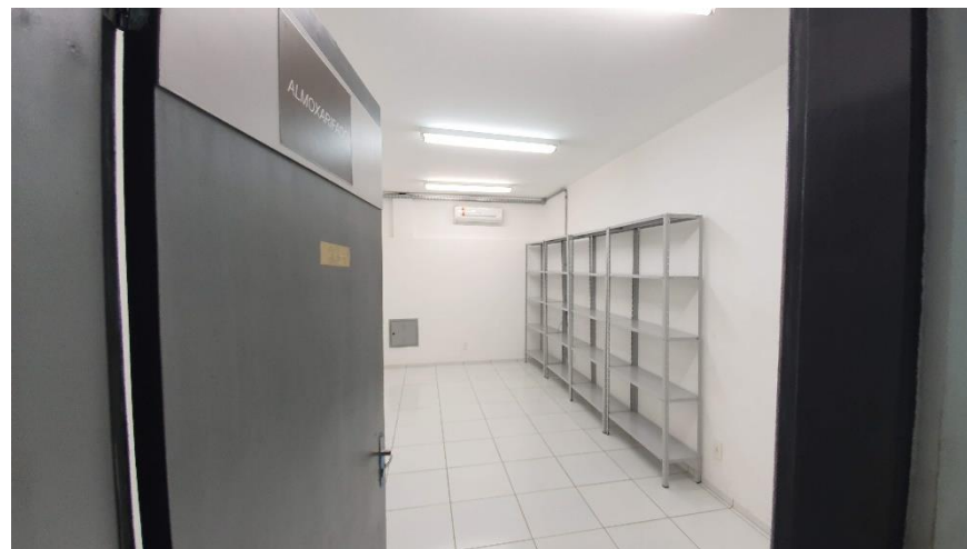
Área 30 - Almoxarifado - Figura 146
