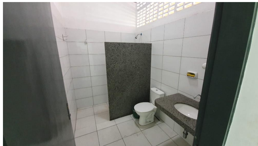
Área 04 - Expurgo Central - Figura 106
