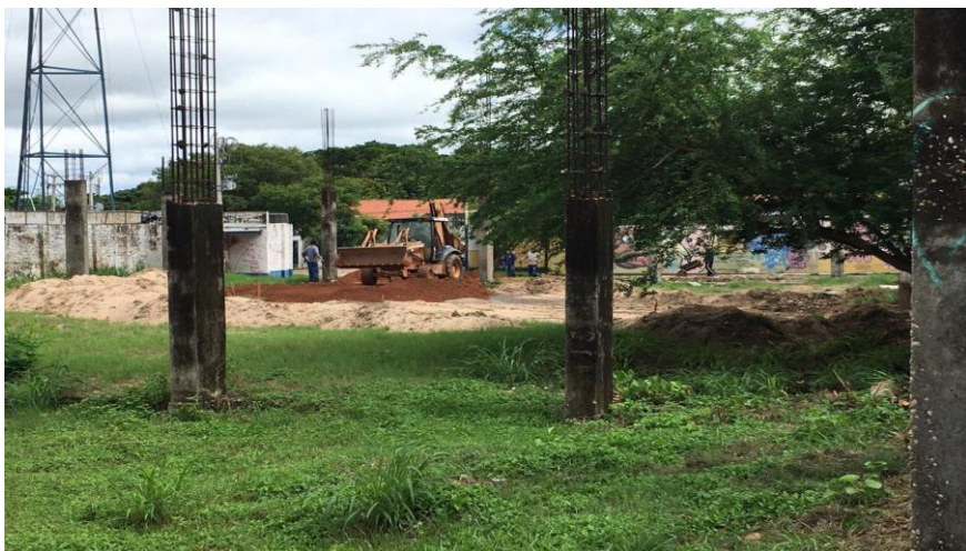
Urbanização do acesso das ambulâncias - Figura 193
