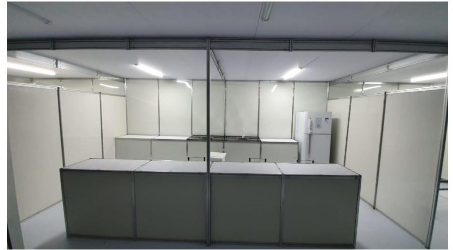
Hospital de Campanha - Figura 42
