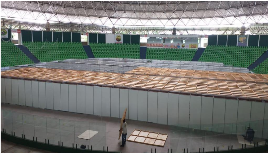
Hospital de Campanha - Figura 21
