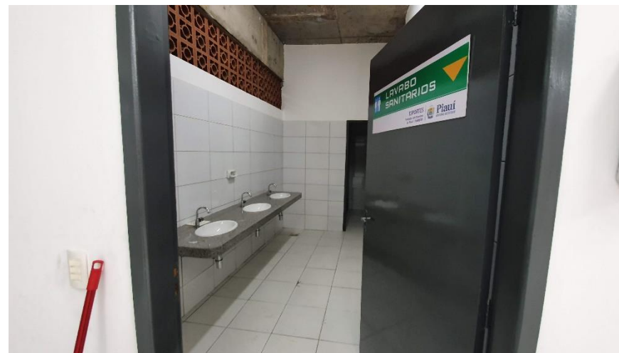
Área 18 - Administração Hospital - Figura 126
