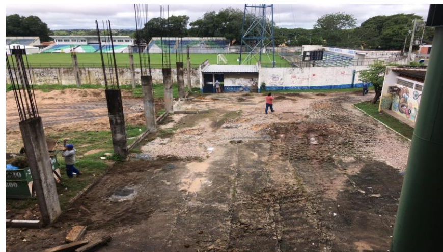
Urbanização do acesso das ambulâncias - Figura 192
