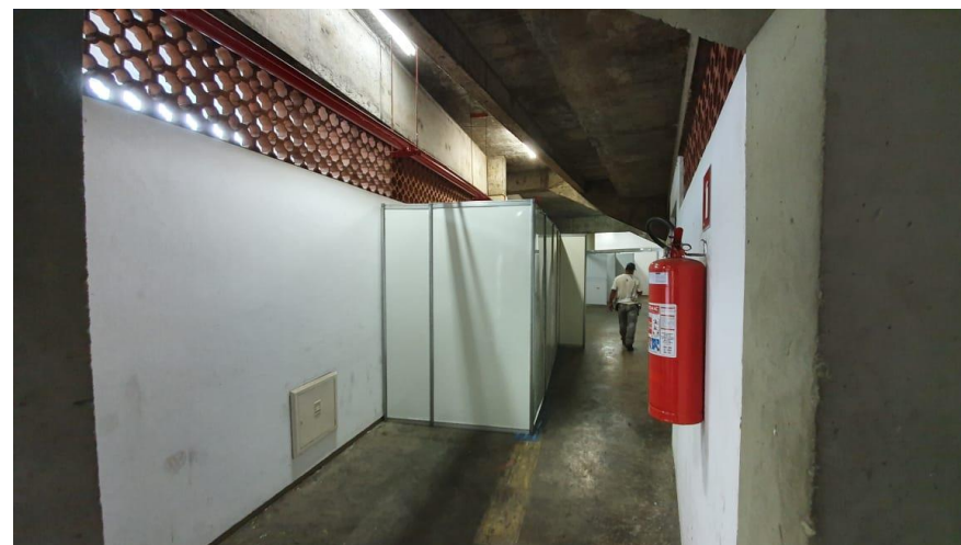
Área de circulação - Figura 48
