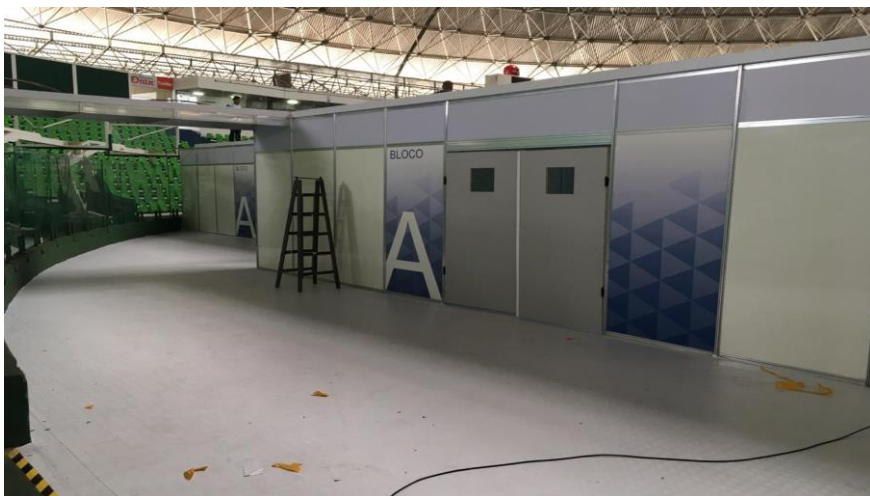
Hospital de Campanha - Figura 77
