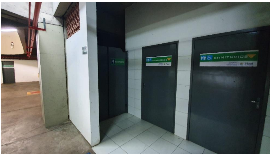
Área 20 - Sanitário Feminino - Figura 129
