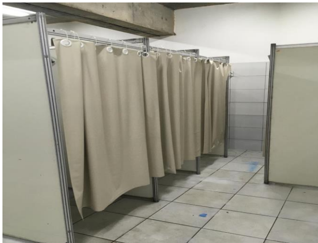
Instalação das cortinas nos vestiários - Figura 207
