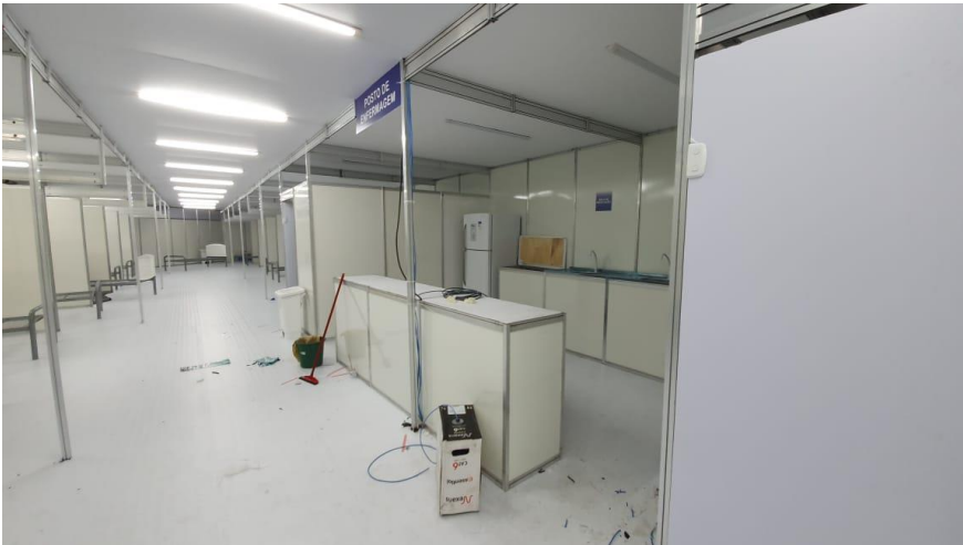
Hospital de Campanha - Figura 43
