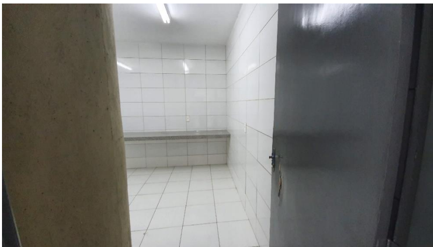
Área 18 - Administração Hospital - Figura 125
