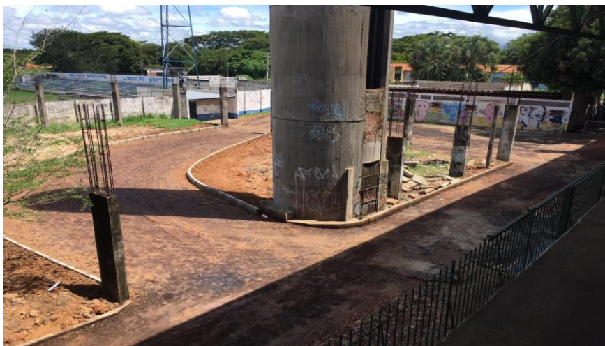
Urbanização para entrada de ambulâncias - Figura 205
