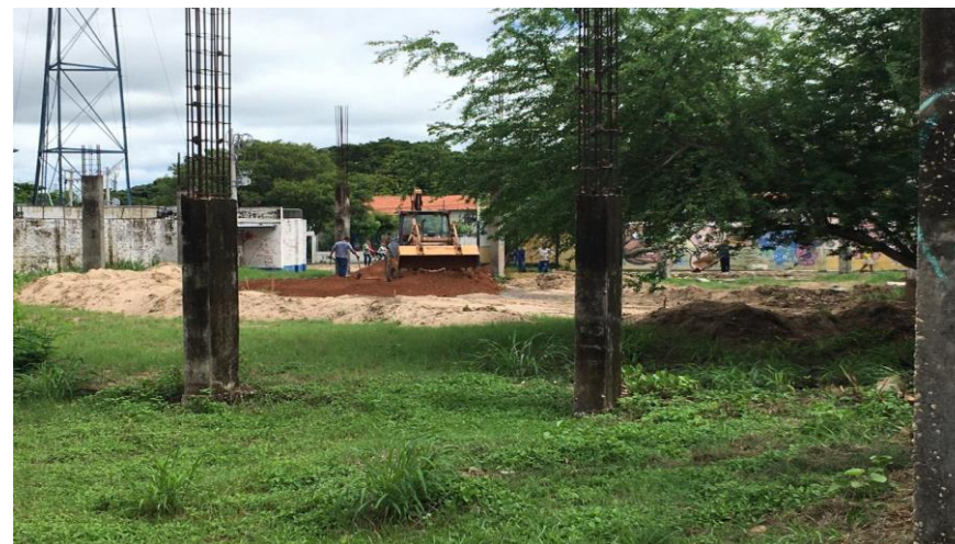
Urbanização do acesso das ambulâncias - Figura 194
