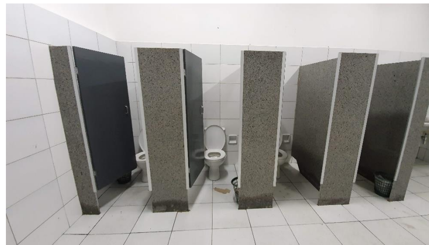
Área 42 - Sanitário Feminino - Figura 178
