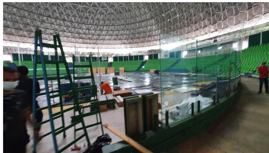
Hospital de Campanha - Figura 18
