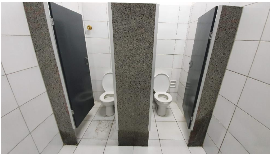
Banheiros / Vestiários - Figura 89
