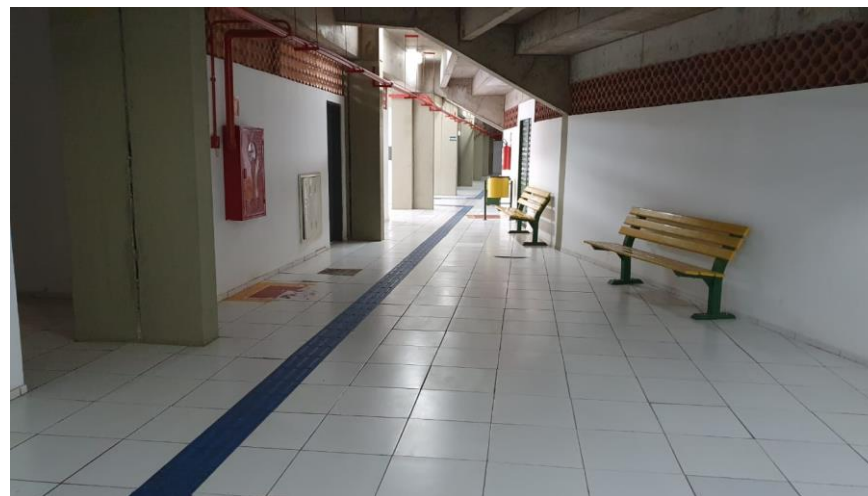
Área de Circulação - Figura 214
