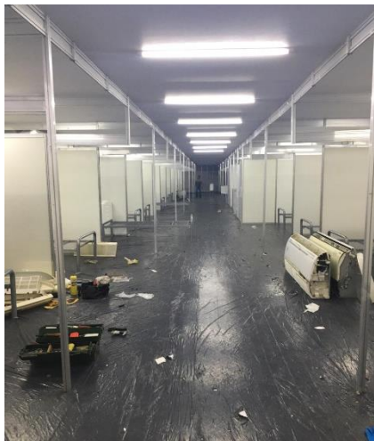
Hospital de Campanha - Figura 29
