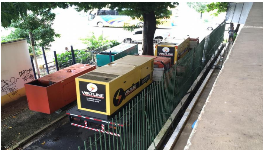
Instalação dos Geradores - Figura 81
