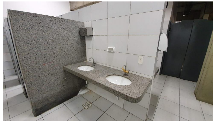
Banheiros / Vestiários - Figura 88
