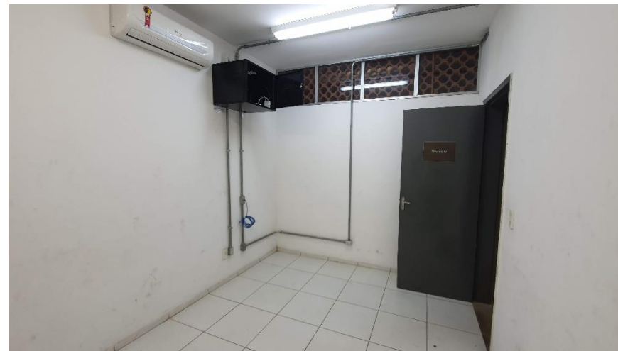
Sala de apoio do Hospital - Figura 202
