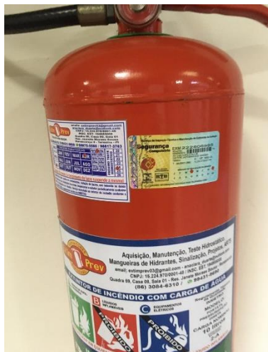
Substituição de extintores - Figura 203
