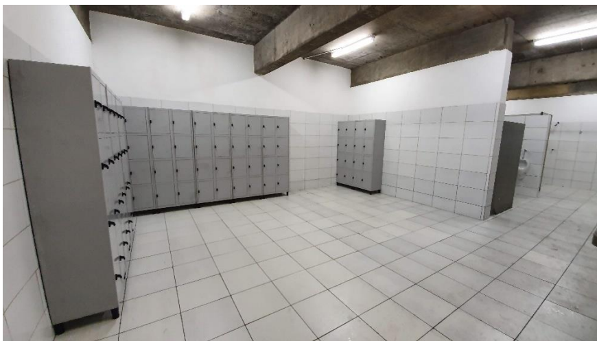
Área 42 - Sanitário Feminino - Figura 177
