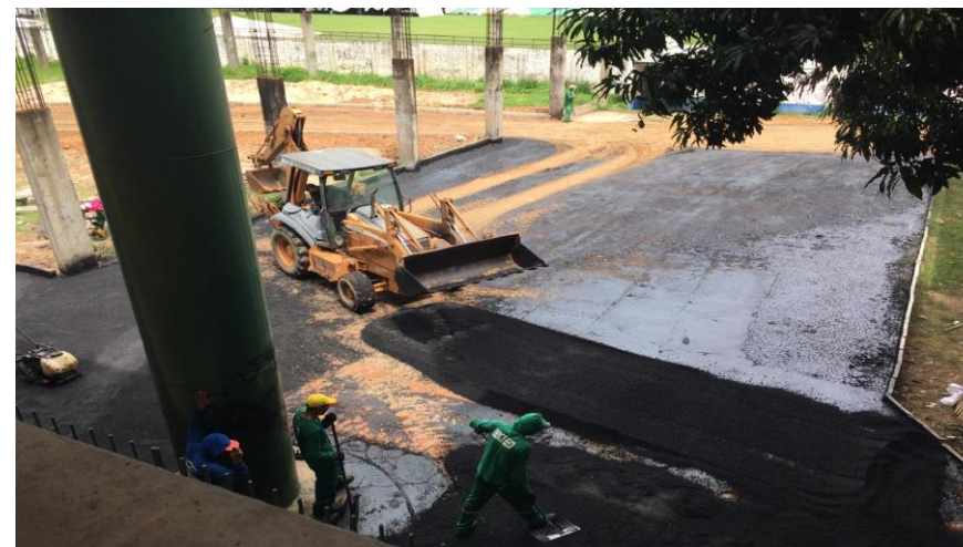
Urbanização para entrada de ambulâncias - Figura 210
