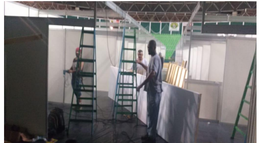
Hospital de Campanha - Figura 22
