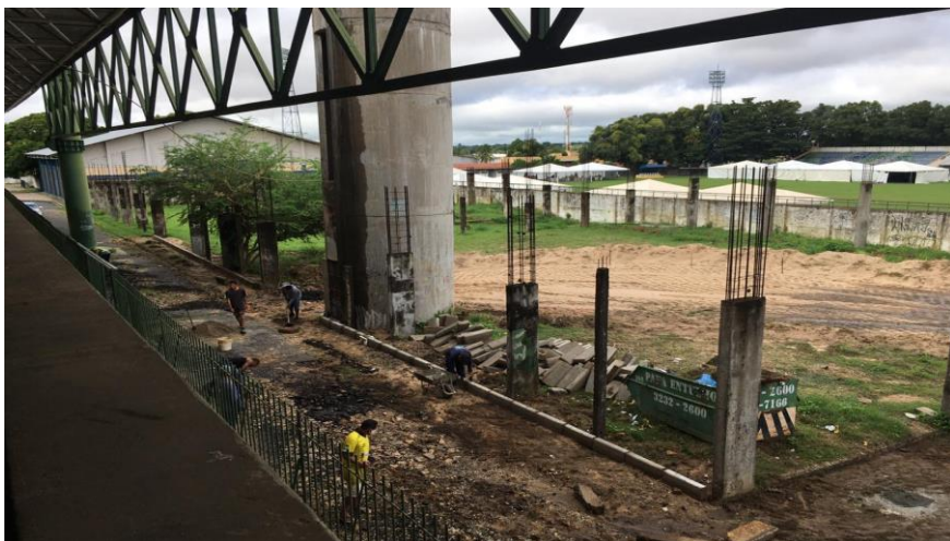
Urbanização do acesso das ambulâncias - Figura 191
