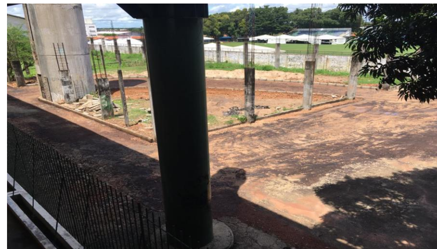
Urbanização para entrada de ambulâncias - Figura 206
