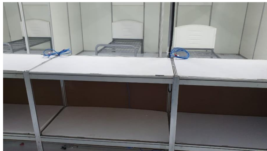
Cabeamento Piauí Conectado - Figura 72
