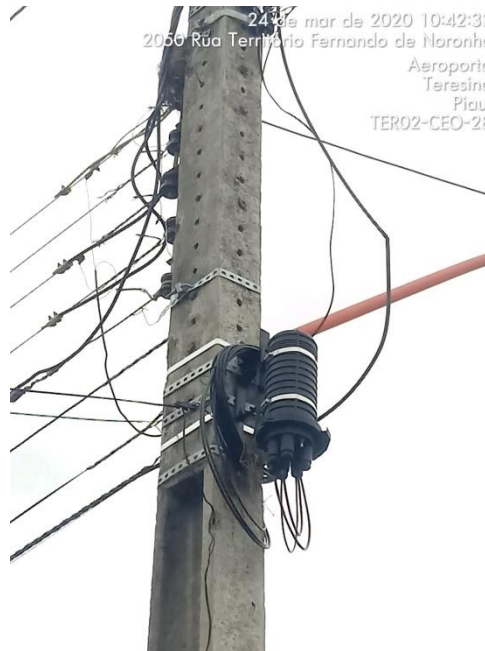
Figura 151 - TER 02-CEO 28 – sem plaqueta de identificação.
