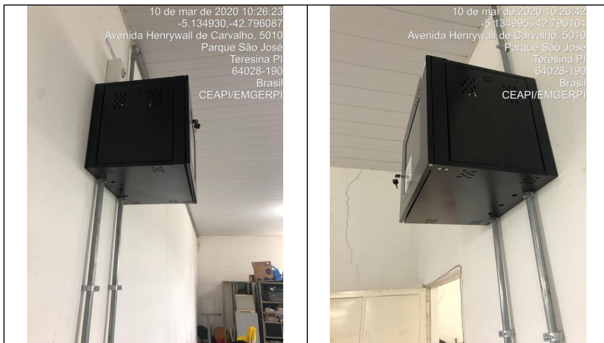
Figura 198 – PAG CENTRO DE APOIO PEDAGÓGICO – TERESINA. NÃO CONFORMIDADE: AUSÊNCIA DE IDENTIFICAÇÃO DO RACK.
