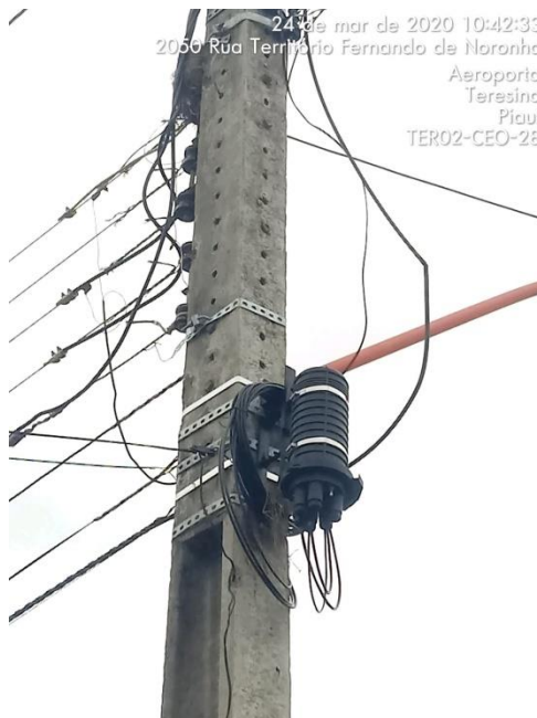
Figura 116 - TER 02-CEO 28 – sem plaqueta de identificação.
