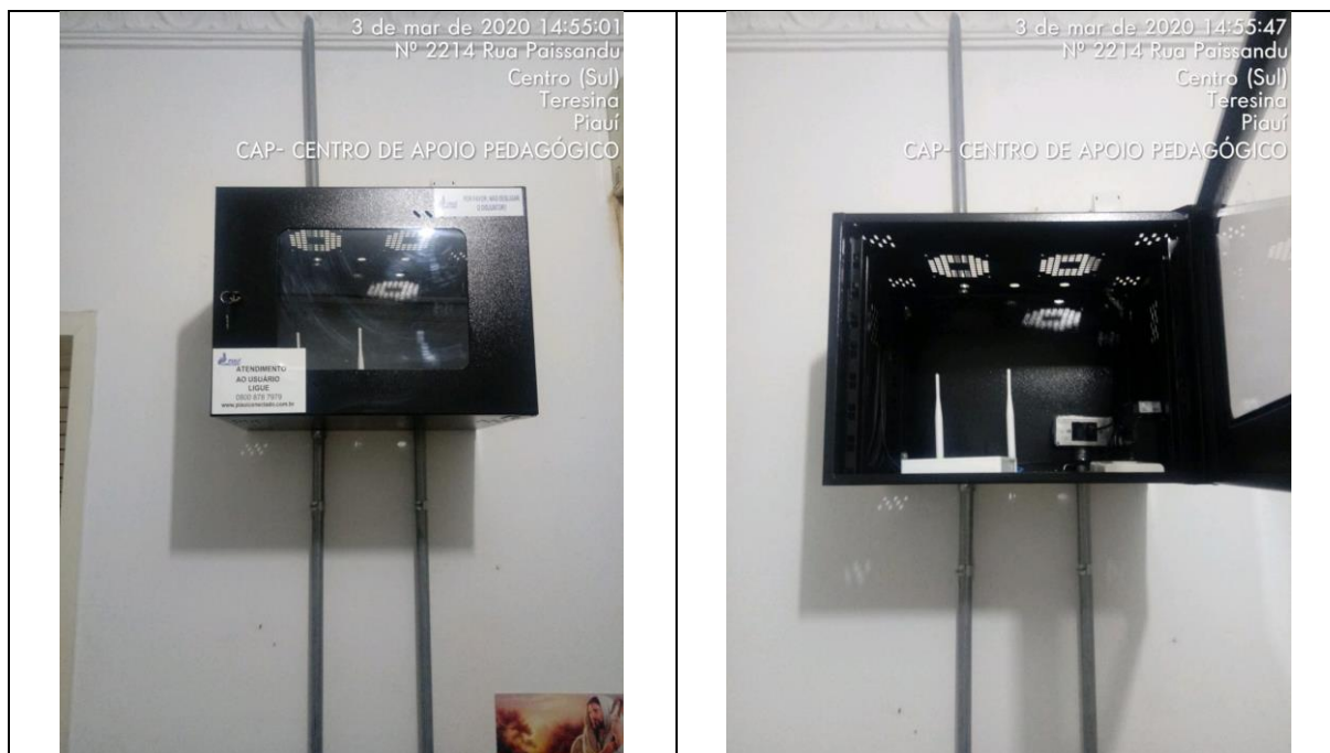
Figura 198 – PAG CENTRO DE APOIO PEDAGÓGICO – TERESINA. NÃO CONFORMIDADE: AUSÊNCIA DE IDENTIFICAÇÃO DO RACK.
