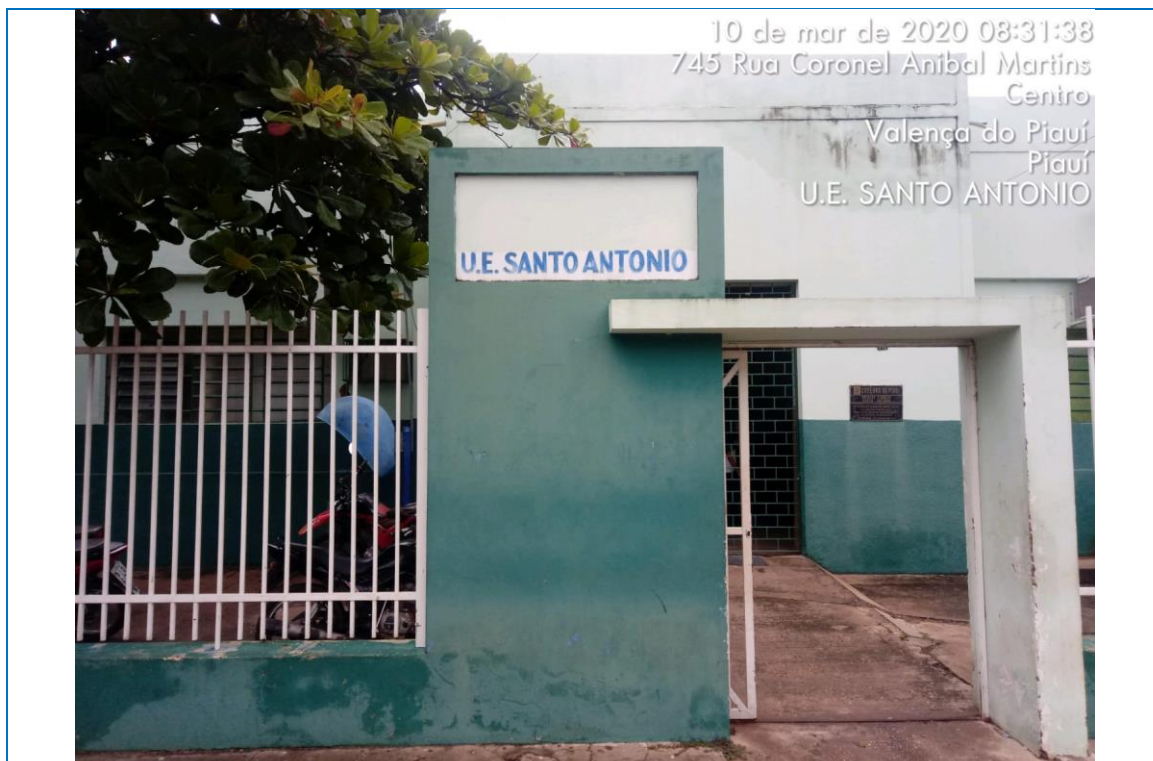
Figura 40 – Unidade Escolar Santo Antônio – Valença do Piauí
