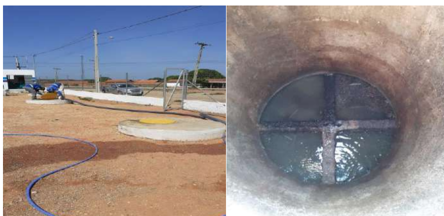
Limpeza dos reatores
