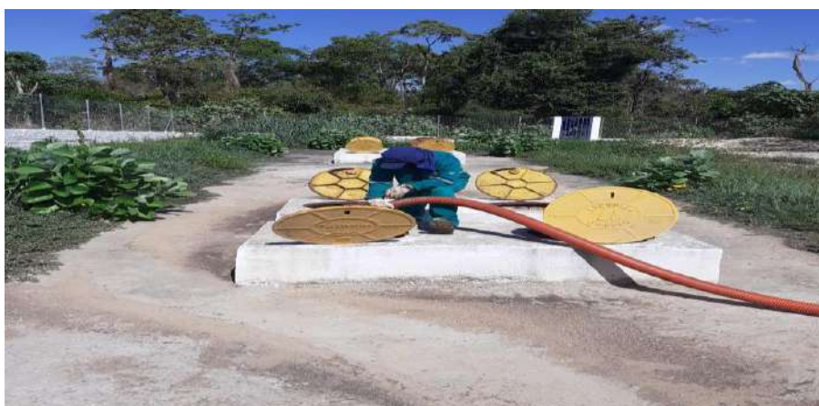
Limpeza dos reatores
