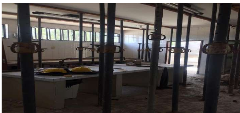
Laboratório em reforma
