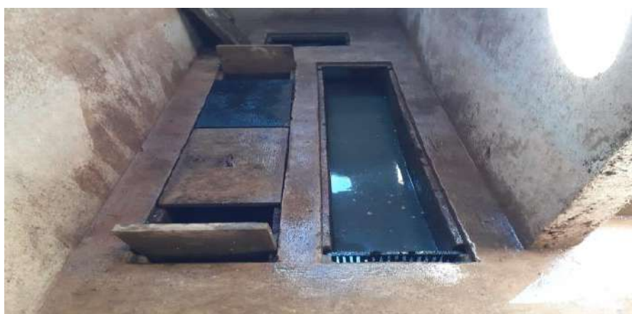
Limpeza caixa de areia finalizada
