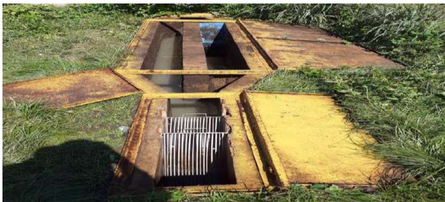
Limpeza caixa de areia finalizada
