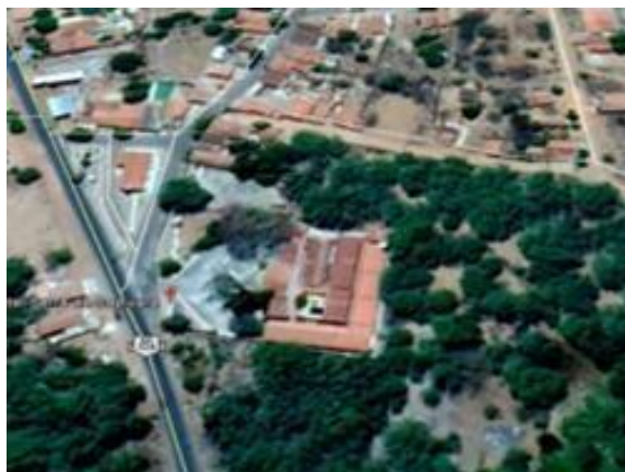
Figura 01 - Vista aérea do Hotel Serra da Capivara
