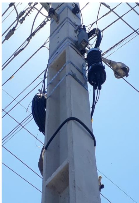
Imagem 4 – CEO já instalada fazendo a junção das fibras nos
