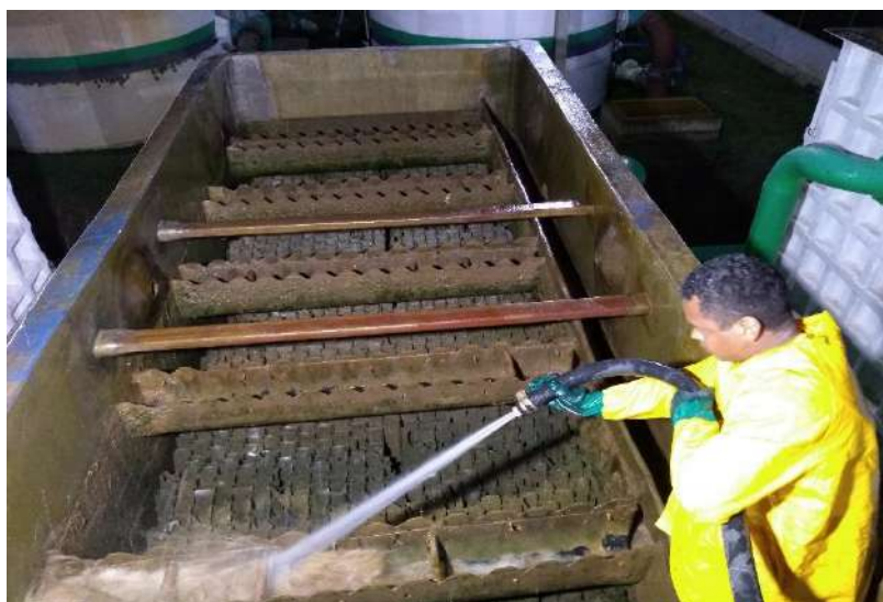
Limpeza dos módulos de decantação
