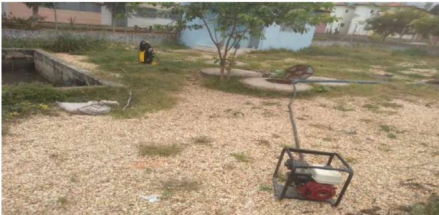
Limpeza dos reatores enterrados da ETE Francisco das Chagas
