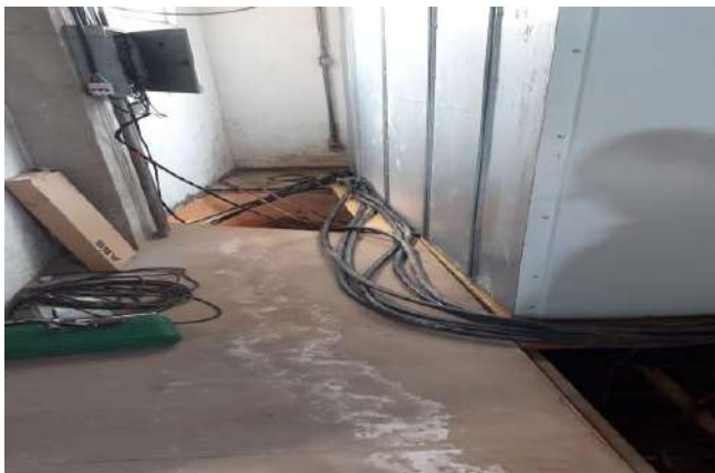
Cabos sendo retirados do CMB 03 e 04 (Antes)
