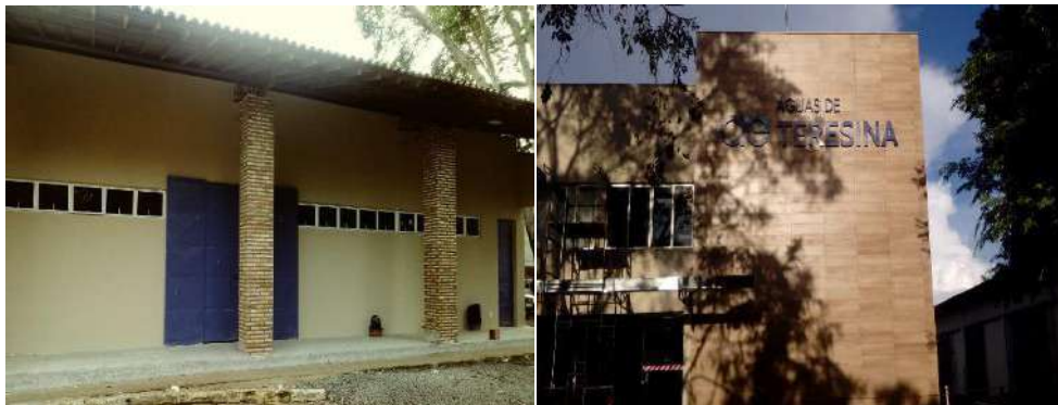
Sede Administrativa - reforma do vestiário, acabamento e pintura externa. Pintura e aplicação de azulejo na fachada principal.
