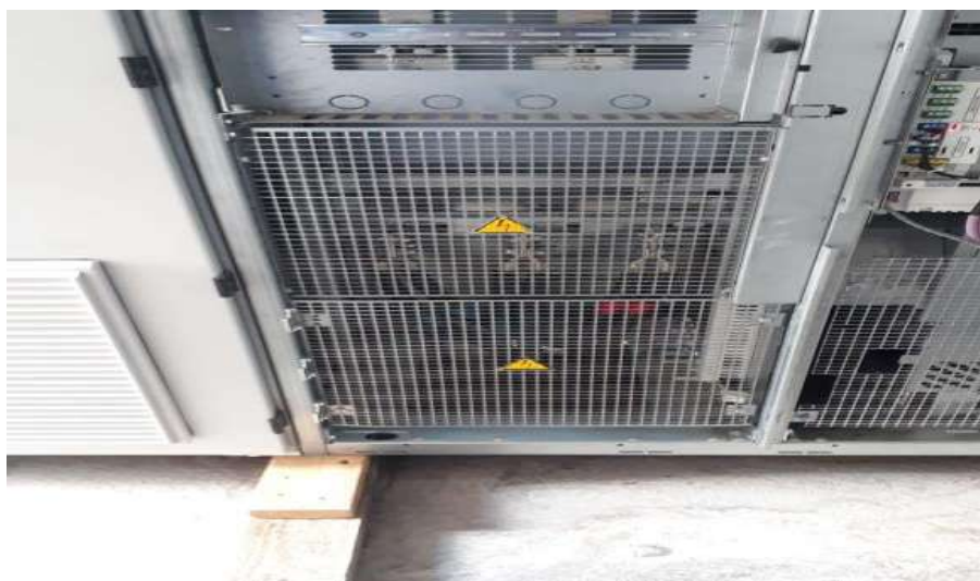
Cabos sendo retirados do CMB 03 e 04 (Depois)
