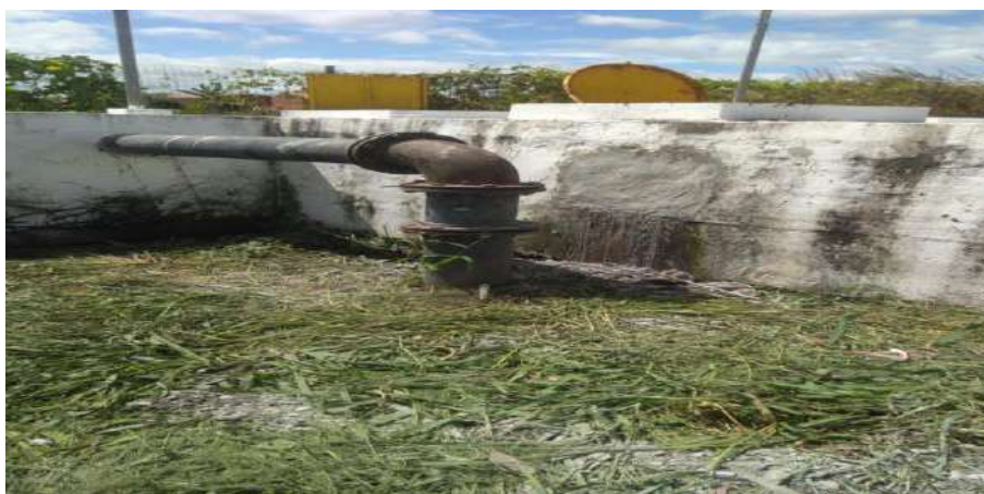
Local do vazamento após reparo.
