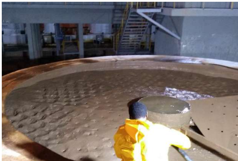
Limpeza dos módulos de floculação
