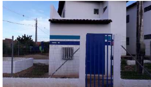
ETE Torquato Neto – execução de escada para acesso aos tanques, realizado pintura e melhoria nos abrigos, incluindo troca de tampas e troca de portão.
