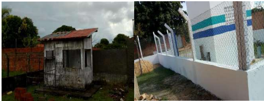
Poço Parque Brasil – pintura e criação de um novo abrigo das bombas incluindo alvenaria e teto.
