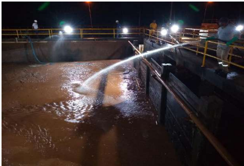
Jateamento dos módulos de decantação
