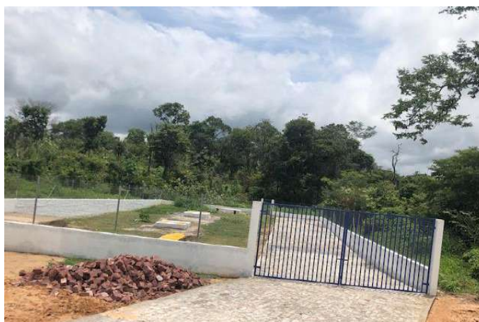
ETE Eduardo Costa Depois
