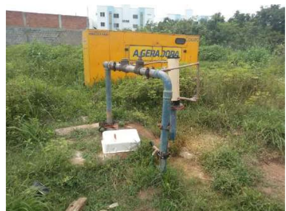
Barrilete após a retirada do vazamento (Depois)
