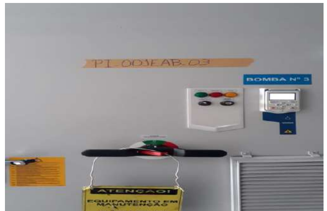
Cabos sendo retirados do CMB 03 e 04 (Antes)
