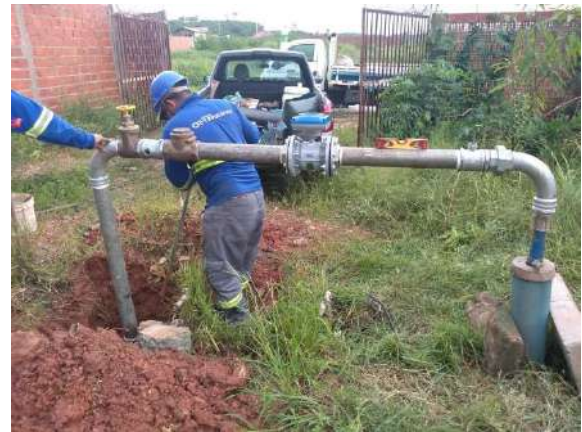
Instalação do barrilete pelos técnicos
