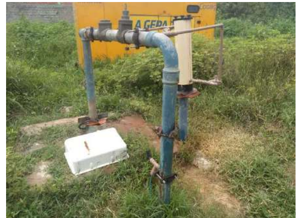
Barrilete após a retirada do vazamento (Depois)
