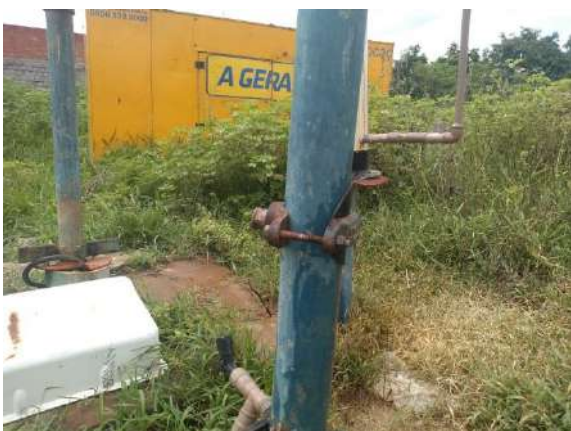
Barrilete após a retirada do vazamento (Depois)
