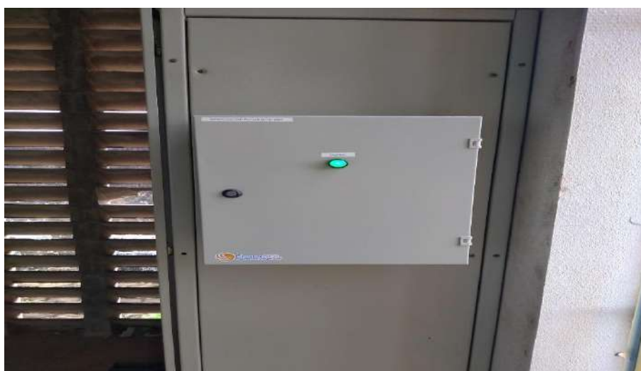
Banco de capacitores Captação EEAT Parque da Cidade
