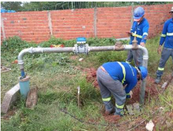
Instalação do barrilete pelos técnicos
