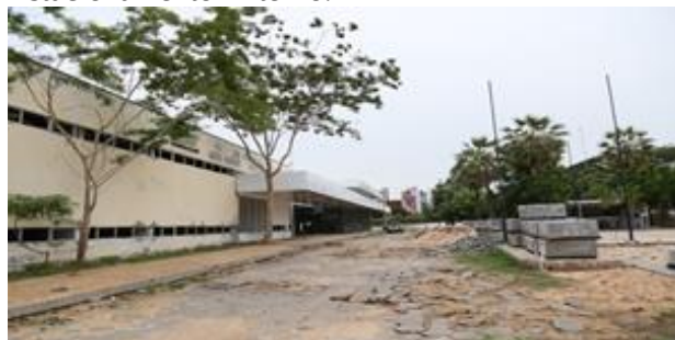
Figura 04 - Situação Atual da Área do Estacionamento Externo.
