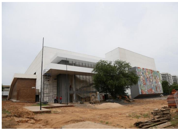
Figura 02 - Situação Faixada do Imóvel
