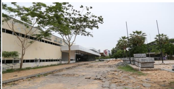
Figura 04: Situação Atual da entrada.
