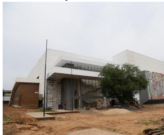
Figura 02: Situação Atual da faixa do imóvel
