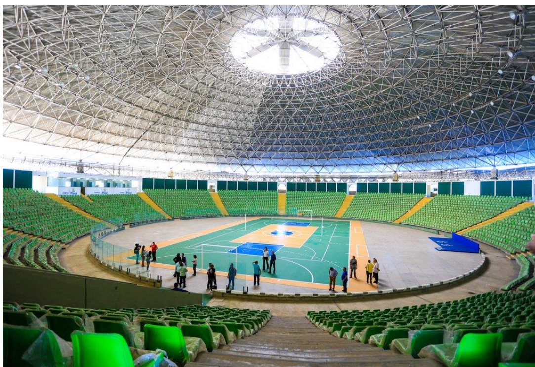
Figura 3: Imagem do estádio apos a reforma, ficando com 5
