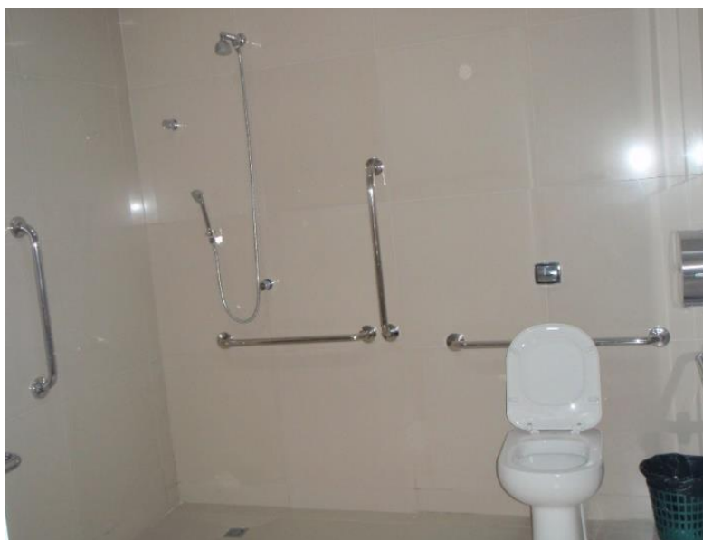
Figura 12: Banheiro PNE do Térreo
