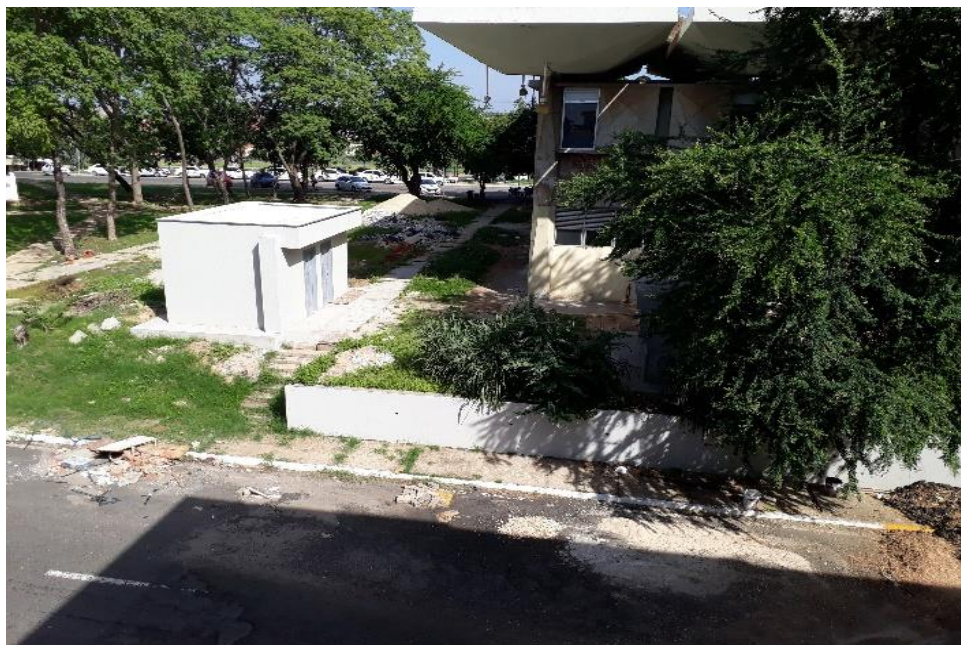
Figura 22: Construção da casa DG e PI
