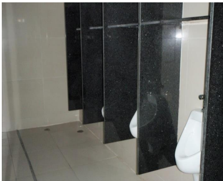
Figura 08: Banheiro masculino da Praça de Alimentação
